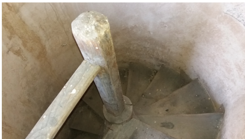
Obr. 19: Dřevěné vřetenové schodiště vedoucí na kruchtu
