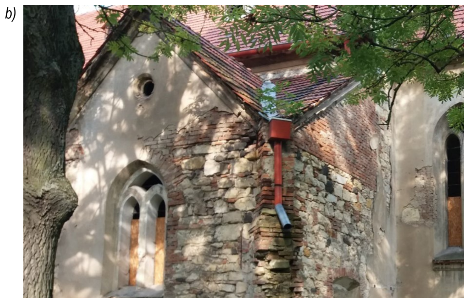
Obr. 25: a), b) Pohled na střechu jihovýchodní sakristie
