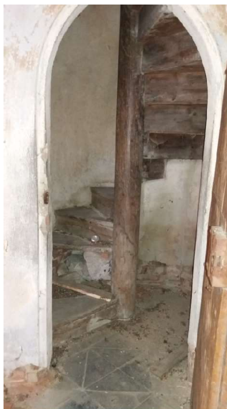
Obr. 20: Dřevěné vřetenové schodiště vedoucí na kruchtu
