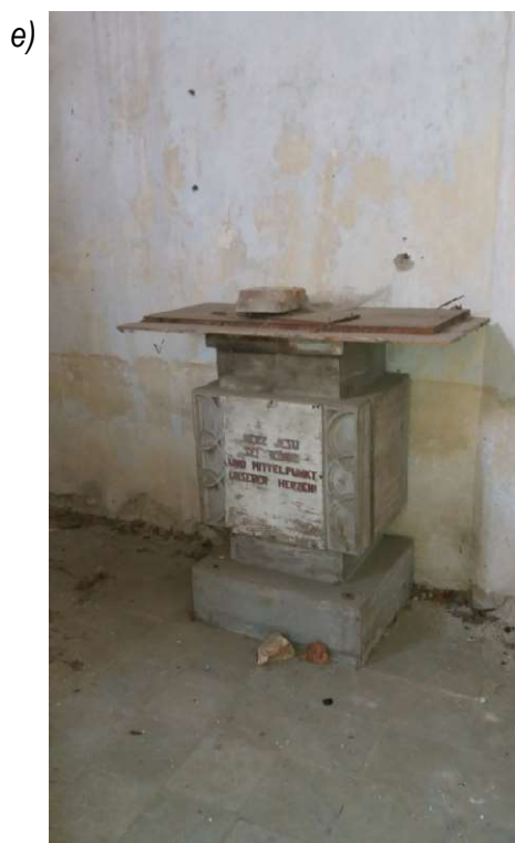
Obr. 39: Vlhkostní mapy a opadaná omítka z důvodu vysoké vlhkosti
