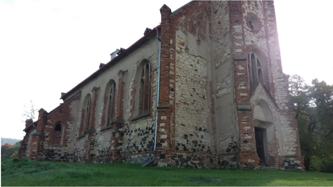
Obr. 15: Pohled na fasádu ztuženou opěráky v nárožích i ve stěně lodi
