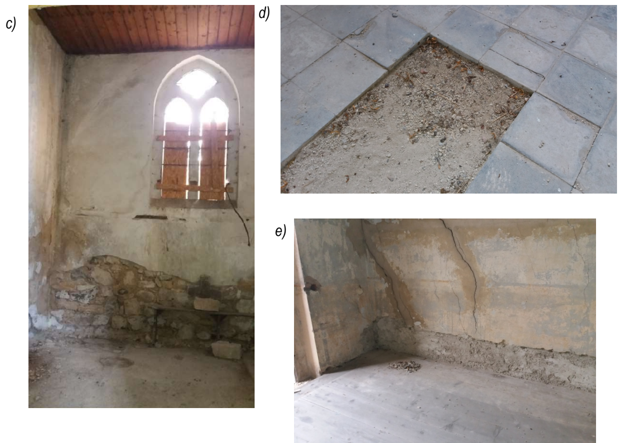
Obr. 28: Vnitřní podlahové konstrukce
