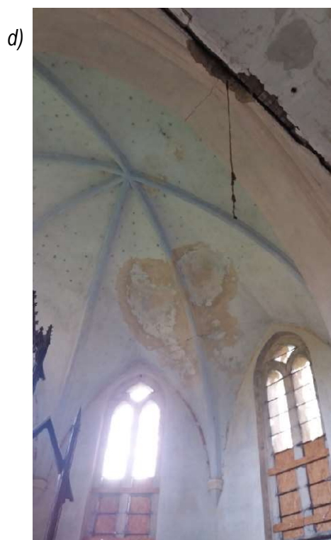
Obr. 53: Vlhkost v konstrukci způsobená srážkovou vodou
