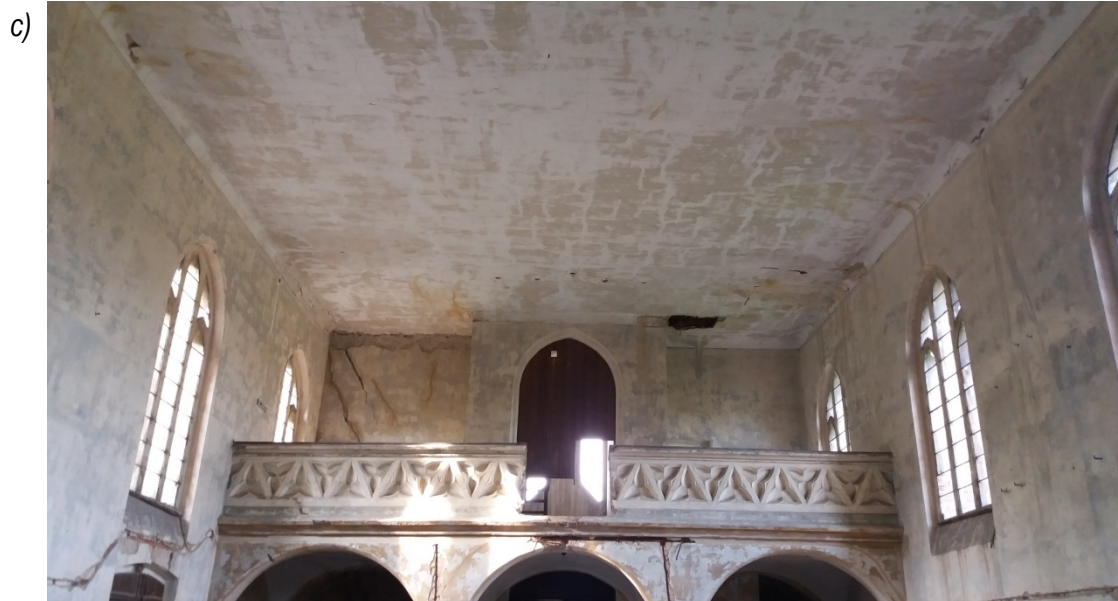
Obr. 17: Vodorovné konstrukce I
