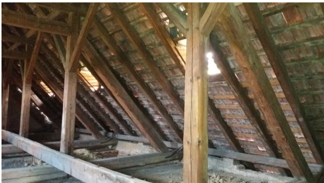
Obr. 23: a), b), c), d), Střešní konstrukce lodi- stojatá stolice (zavěšený pohled)
