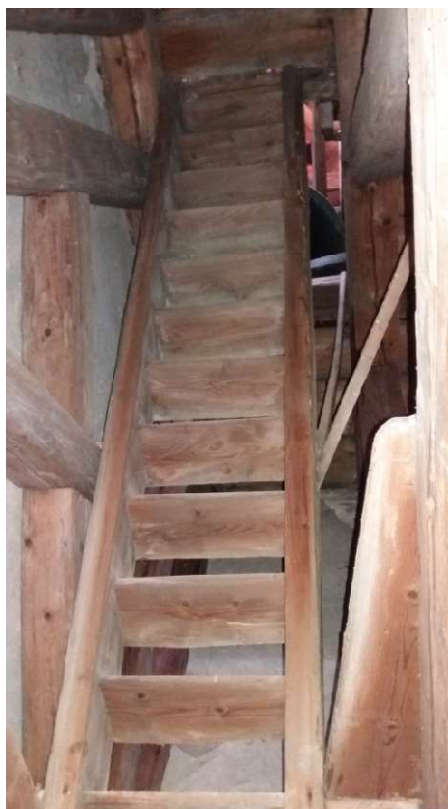
Obr. 22: Dřevěné schody vedoucí do věže
