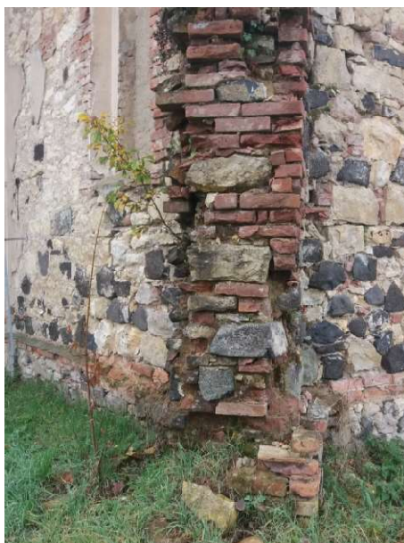
Obr. 51: a), b), c) Výskyt vyšších rostlin na opěráku SZ sakristie
