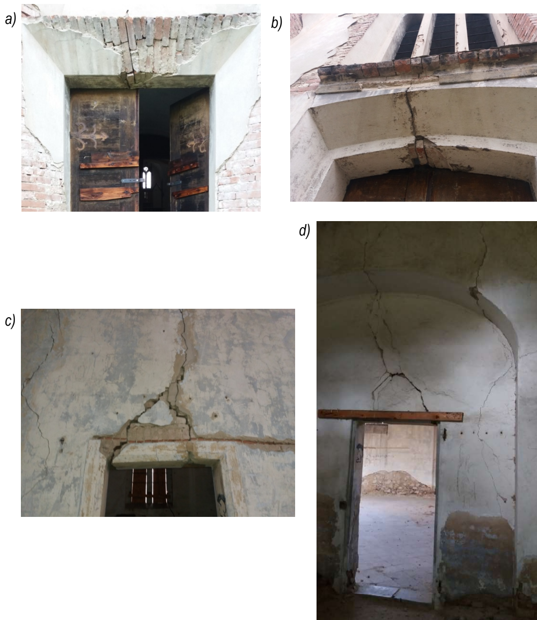
Obr. 59: Poruchy otvorů
