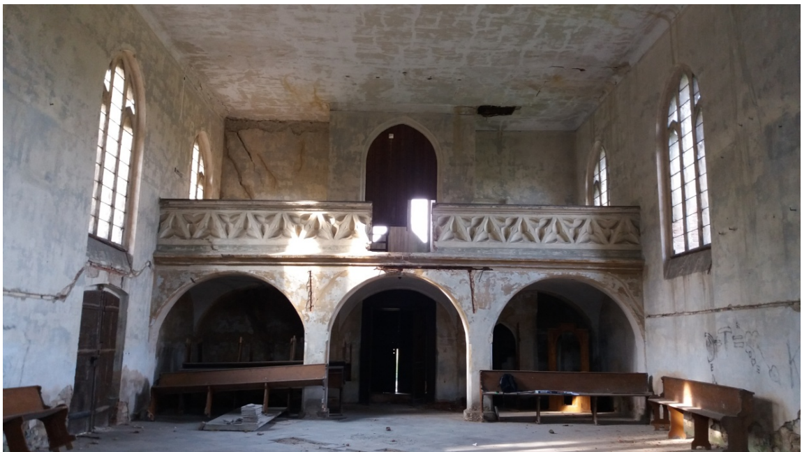
Obr. 16: Vnitřní svislé konstrukce
