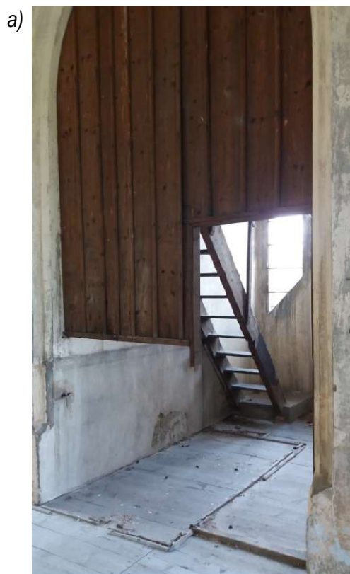
Obr. 21: Dřevěné schodiště vedoucí do konstrukce zastřešení lodi
