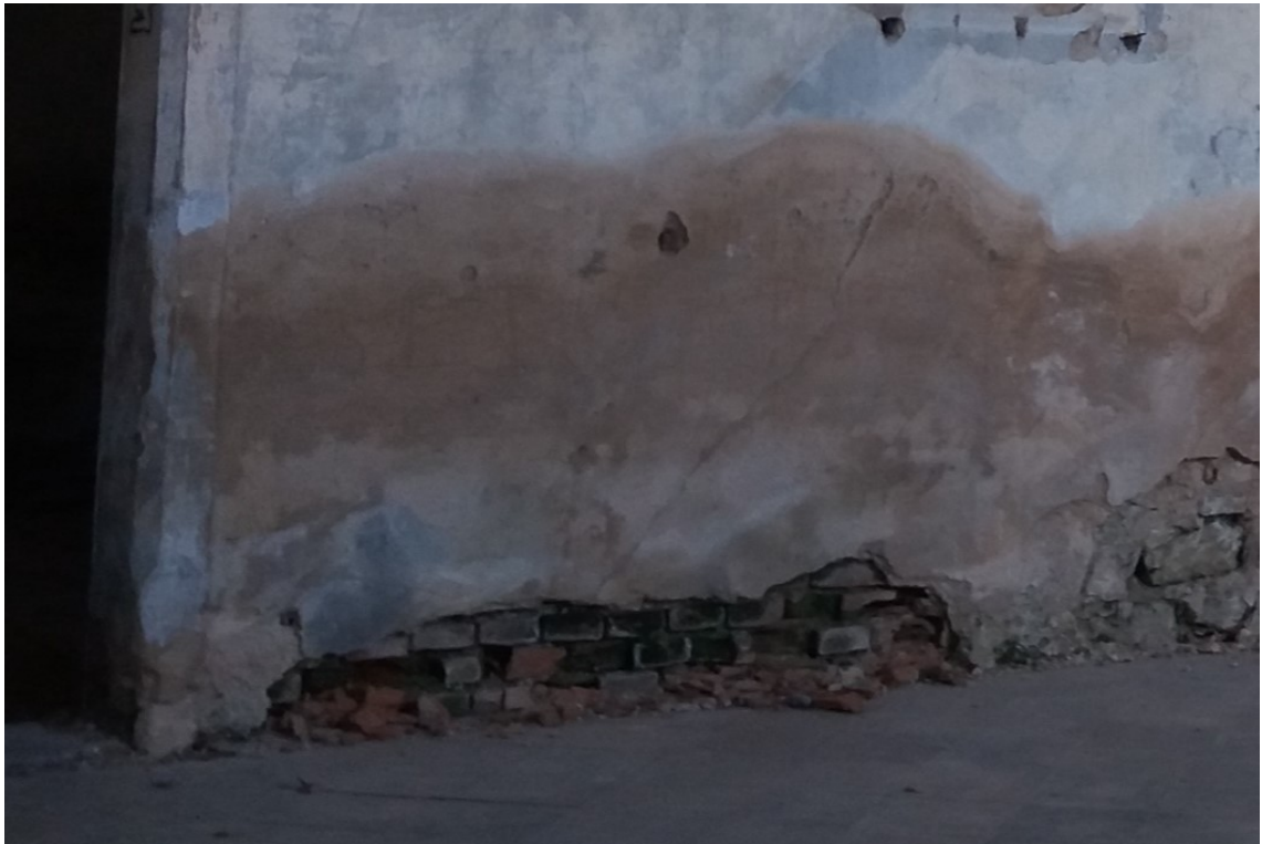
Obr. 50: Výskyt řasy v objektu
