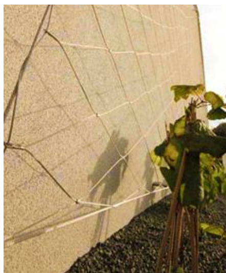
Obr. 16 - Detail lanové sítě, Digital park III. 1/2, Bratislava - [29]
