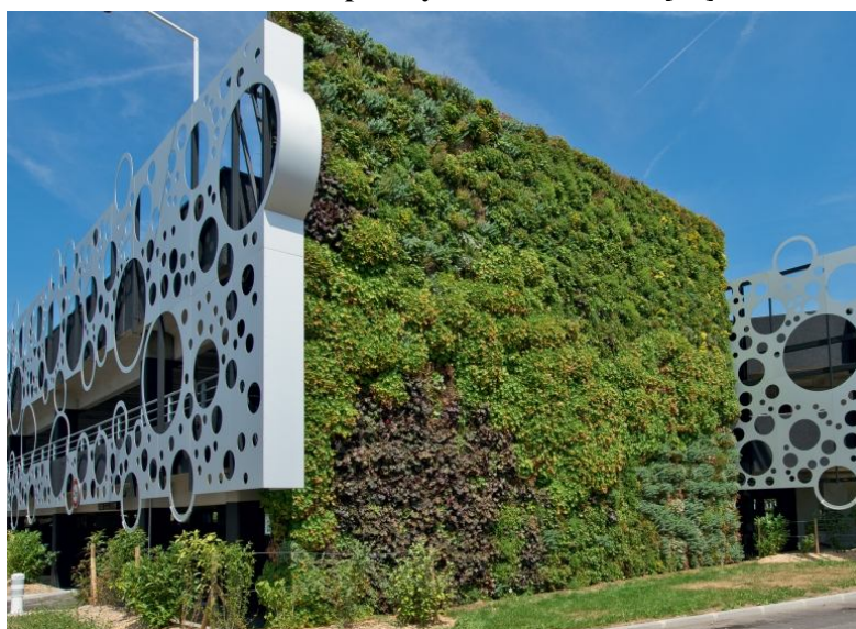
Obr. 28 - Příklad plně rozvinuté modulové živé stěny systémem boxů LIKO-S, Na stěně není patrný rastr modulů. - [36]
