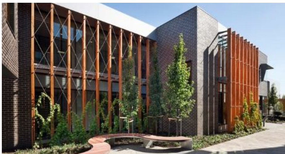
Obr. 22 - Kombinace systému dřevěných podpor a rastru ocelových lan, St. Catherine's School, Melbourne, Austrálie 2017 - [33]
