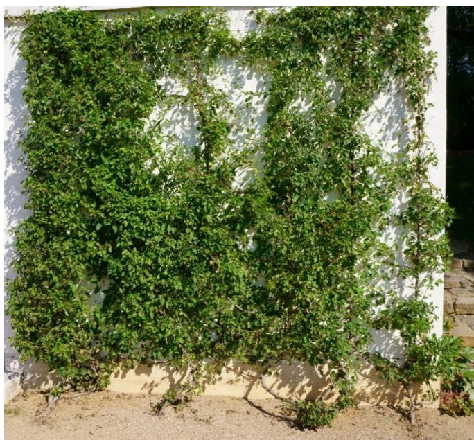
Obr. 14 - Příklad zelené fasády s lanovým podpůrným systémem pnutí, Vila Tugendhat, Brno, říjen 2017 - [Autorské foto]
