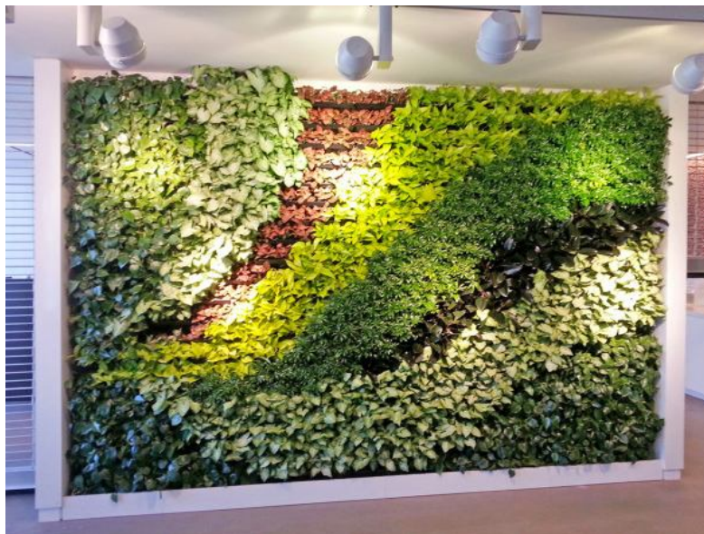
Obr. 36 - Příklad živé stěny v interiéru ze systému truhlíků a květináčů - [45]
