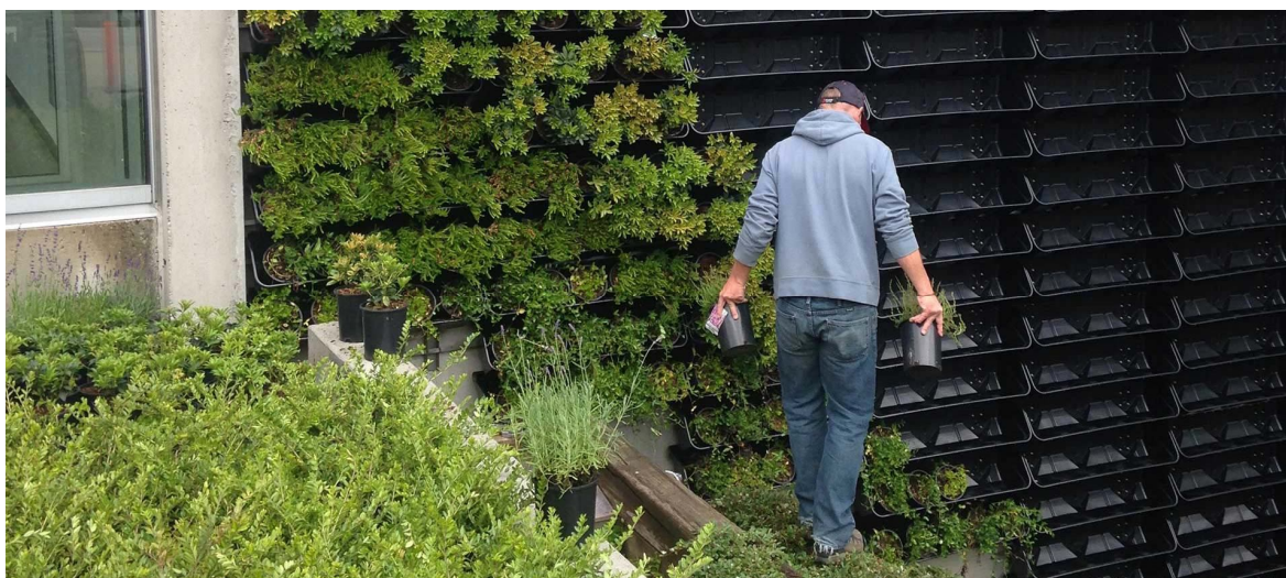
Obr. 29 - Instalace květináčů do připravených truhlíků, systém Versa Wall XT - [38]
