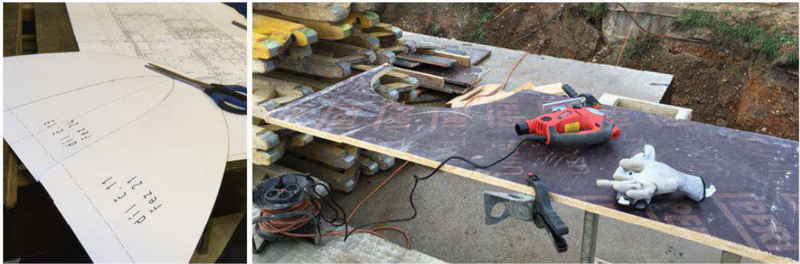
Obrázek 47: Výroba profilů pro stavbu bednění
