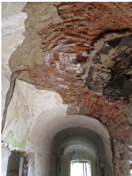
Obrázek 27 - odhalený líc křížové klenby ve střední části chodby
