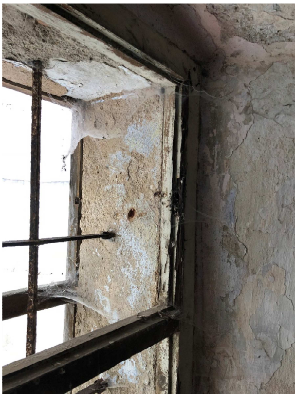
Obrázek 10 – fotografie typického ostění okna
