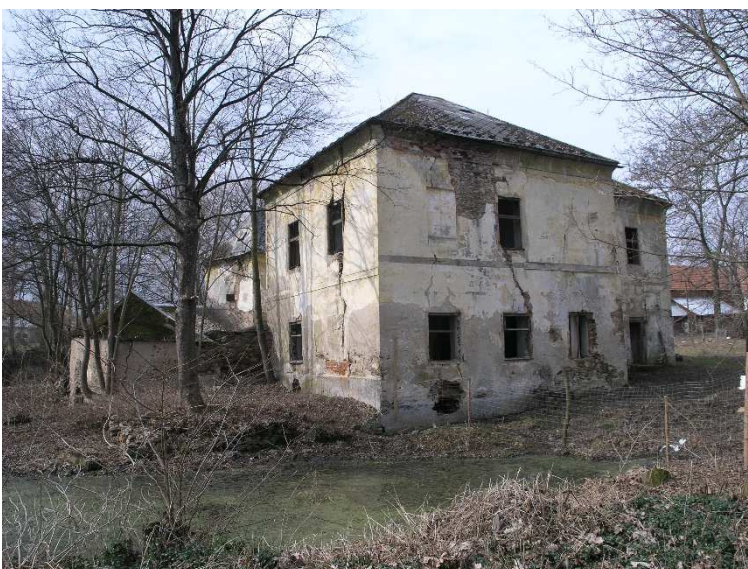
Obrázek 4 – pohled na východní věž před stavebními úpravami
