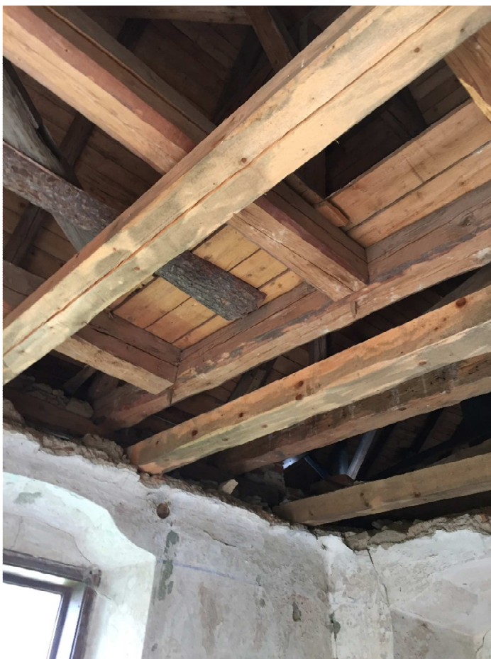
Obrázek 8 – pohled na odhalený trámový strop a baldachýnový záklenek v jižní věži
