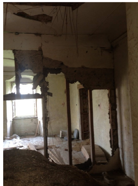
Obrázek 7 – degradovaná heraklitová příčka
