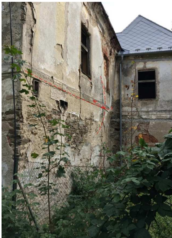
Obrázek 15 - vychýlení osy obvodové stěny na jihozápadní straně středního křídla
