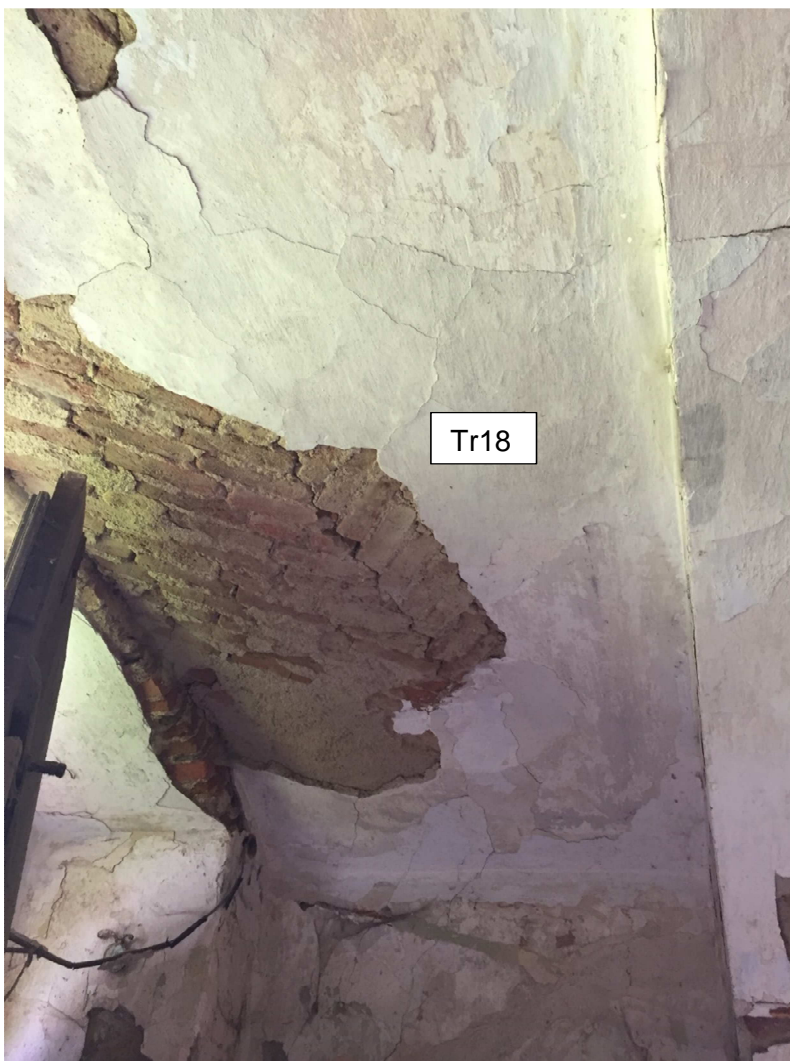
Obrázek 26 – trhlina ve vrcholu segmentové klenby
