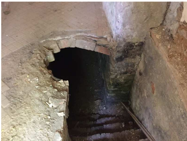
Obrázek 11 – Vstupní schodiště do podsklepených prostor zámku
