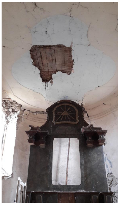
40. Strop pod konstrukcí věže
