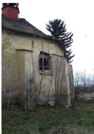
16. Stav jižní fasády rok 2017
