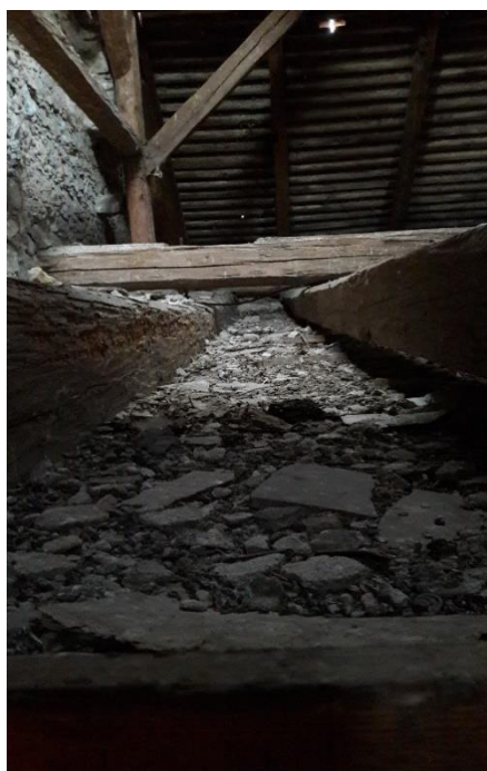
35. Vlevo: stropní trám, vpravo: střešní trám
