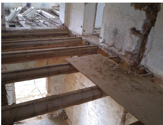
Foto /35/ - Pohled do konstrukce stropu
