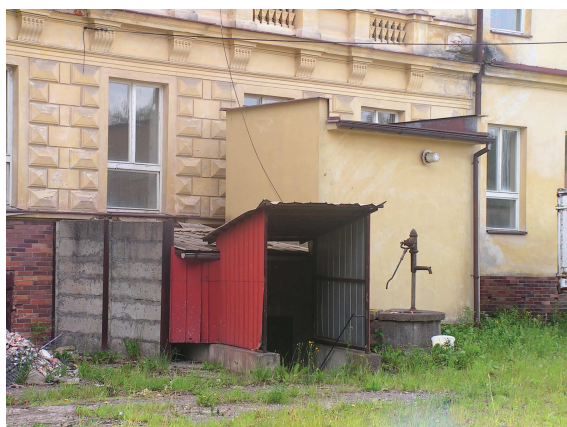
Foto /19/ - Pohled od východu
