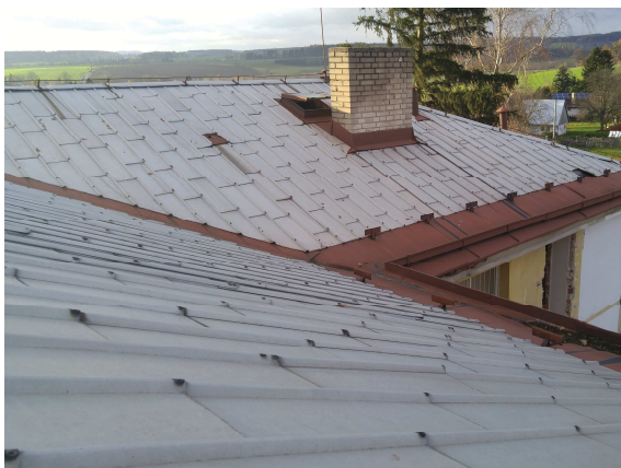
Foto /20/ - Pohled na střešní plášť
