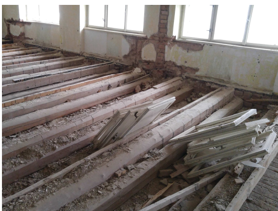
Foto /36/ - Pohled do konstrukce stropu
