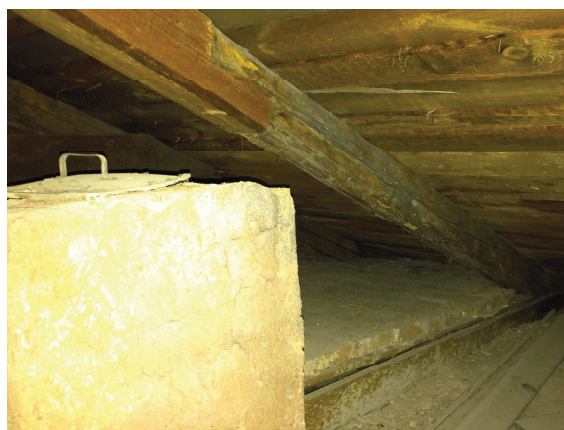
Foto /31/ - Pohled do konstrukce krovu Oprava krokve
