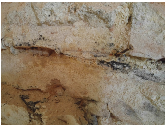
Foto /8/ - pohled na stávající asfaltovou vodorovnou hydroizolaci zdiva
