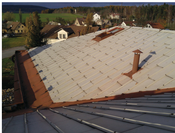
Foto /21/ - Pohled na střešní plášť
