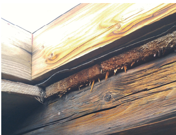
Foto /22/ - Pohled na skladbu střešního pláště
