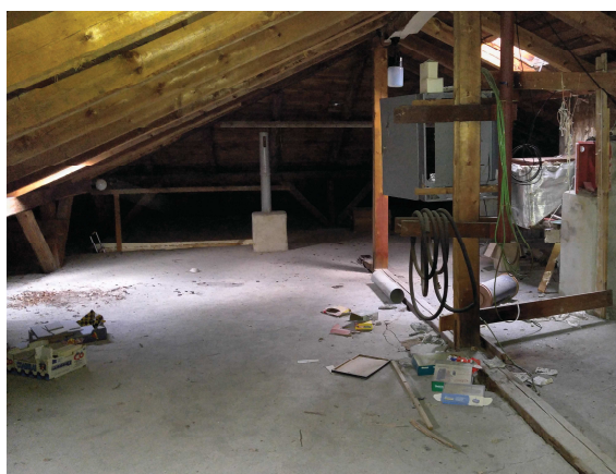
Foto /23/ - Pohled do konstrukce krovu
