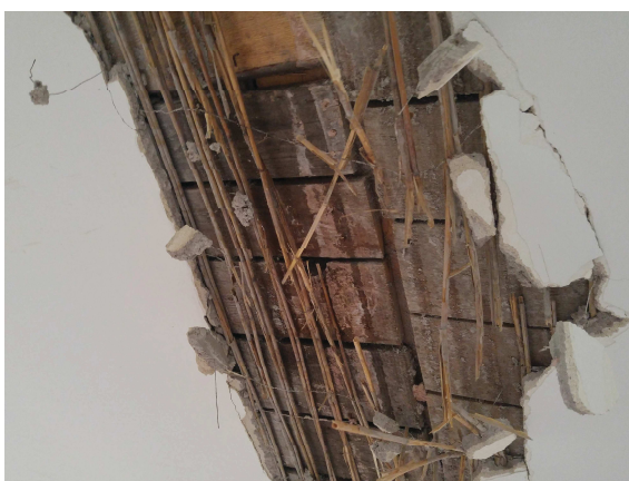
Foto /37/ - Pohled do konstrukce stropu
