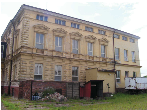
Foto /18/ - Pohled od východu
