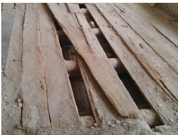
Foto /34/ - Pohled do konstrukce stropu
