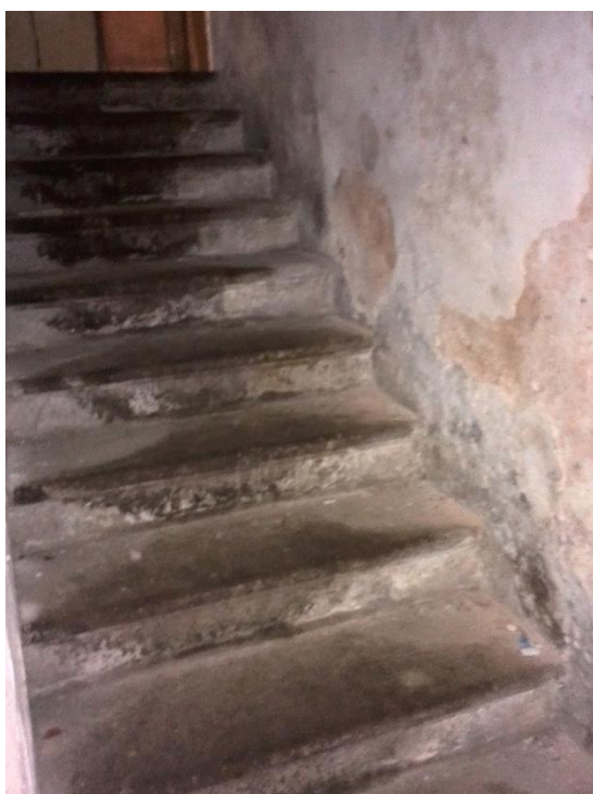
Obrázek 27 – Schodiště ze suterénu do přízemí
