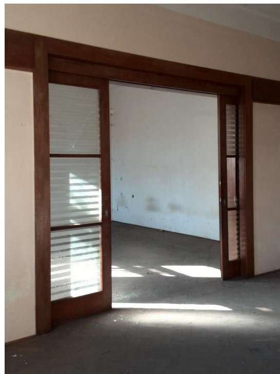
Obrázek 24 – Posuvné dveře do příčky
