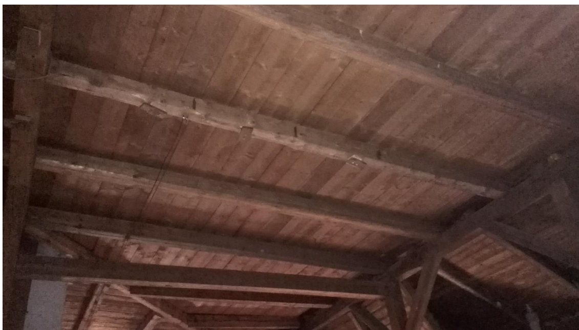
Obrázek 8 – Vrchní část krovu mansardové střechy
