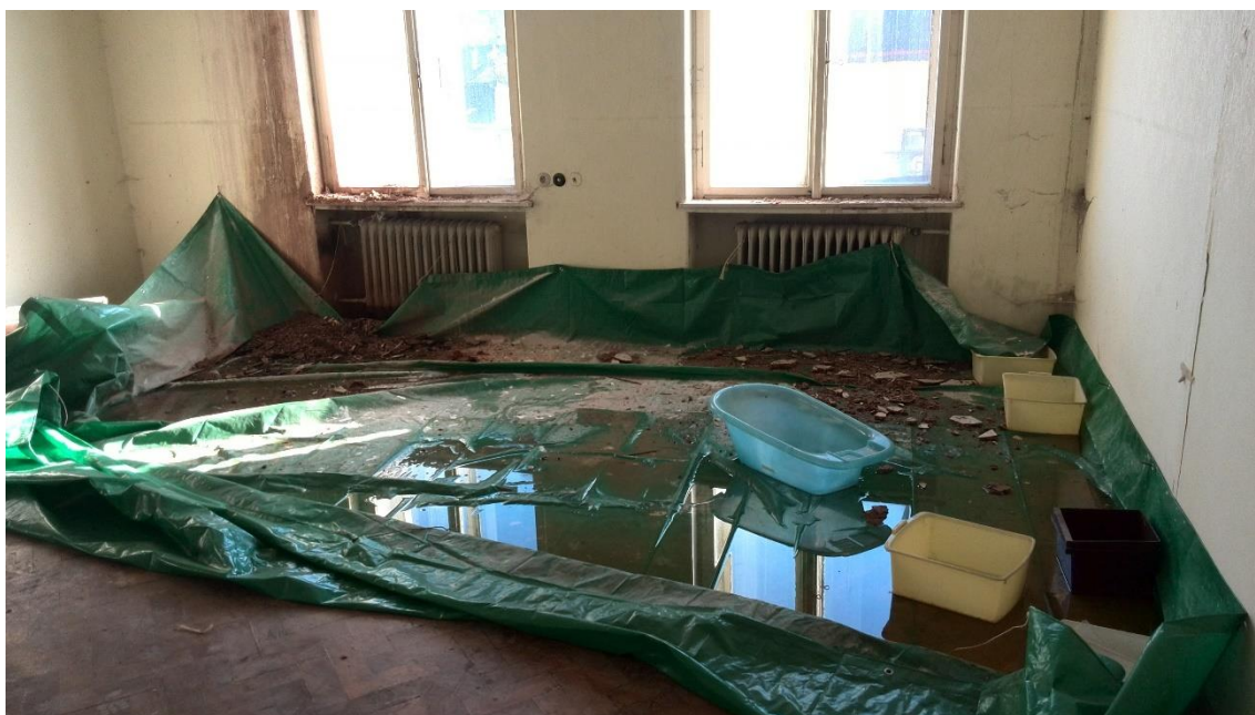
Obrázek 26 – Opatření proti zatékání do nižších pater
