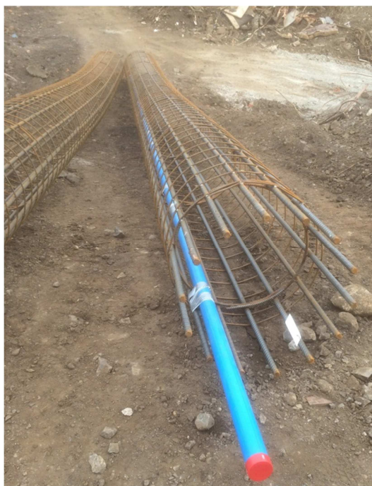
Obr. č. 40: Připravená pažnice v armokoši (zdroj: autor)
