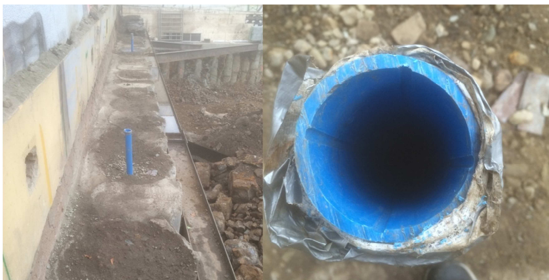
Obr. č. 41: Vlevo části osazené pažnice a v pravé detail průřezu pažnice s drážkami - detail průřezu vpravo je bližší pažnice z levé části (zdroj: autor)
