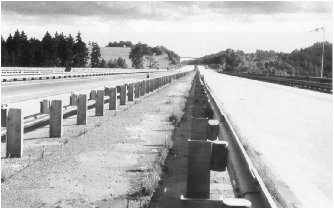
Obr. 1.18 –Dokončená vozovka a vybavení mostu [4]
