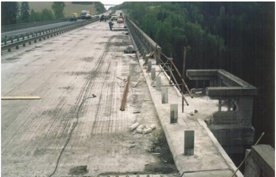
Obr. 1.19 –Rekonstrukce mostu (Konec 80.let 20.stol) [4]
