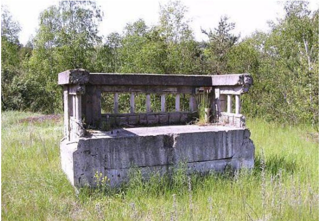
Obr. 1.20 –Odstraněný balkónek po rekonstrukci mostu [4]
