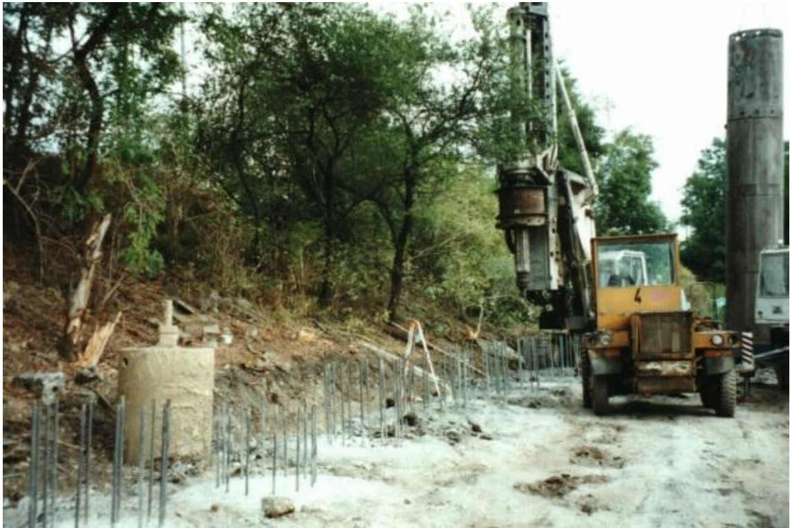
Fotografie 6: Sanace svahu, hotové piloty [14]
