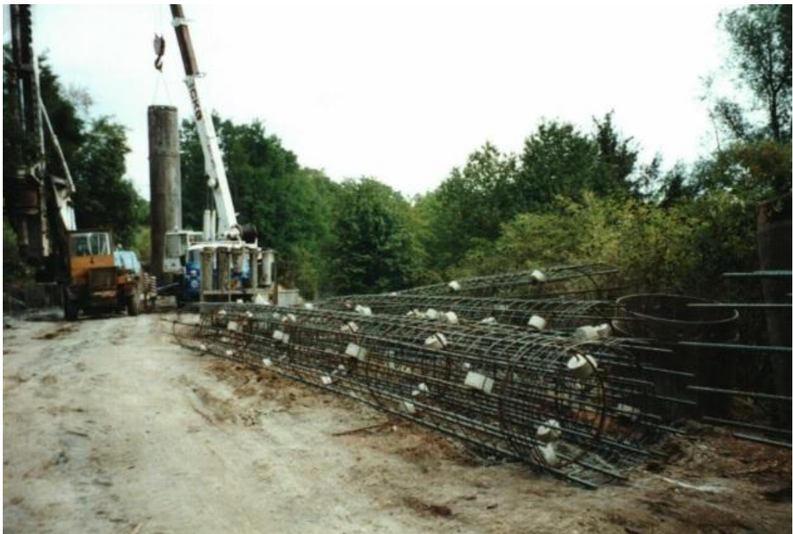
Fotografie 7: Sanace svahu, výztuž piloty [14]
