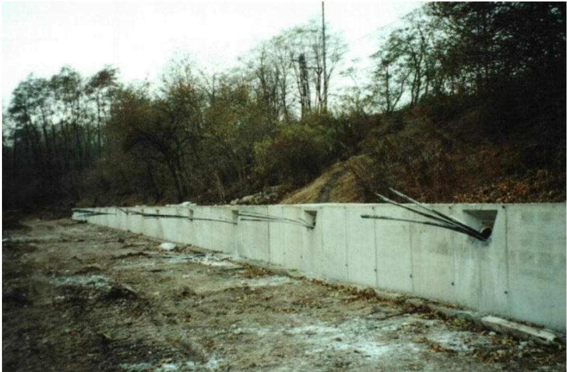
Fotografie 8: Sanace, železobetonový věnec [14]
