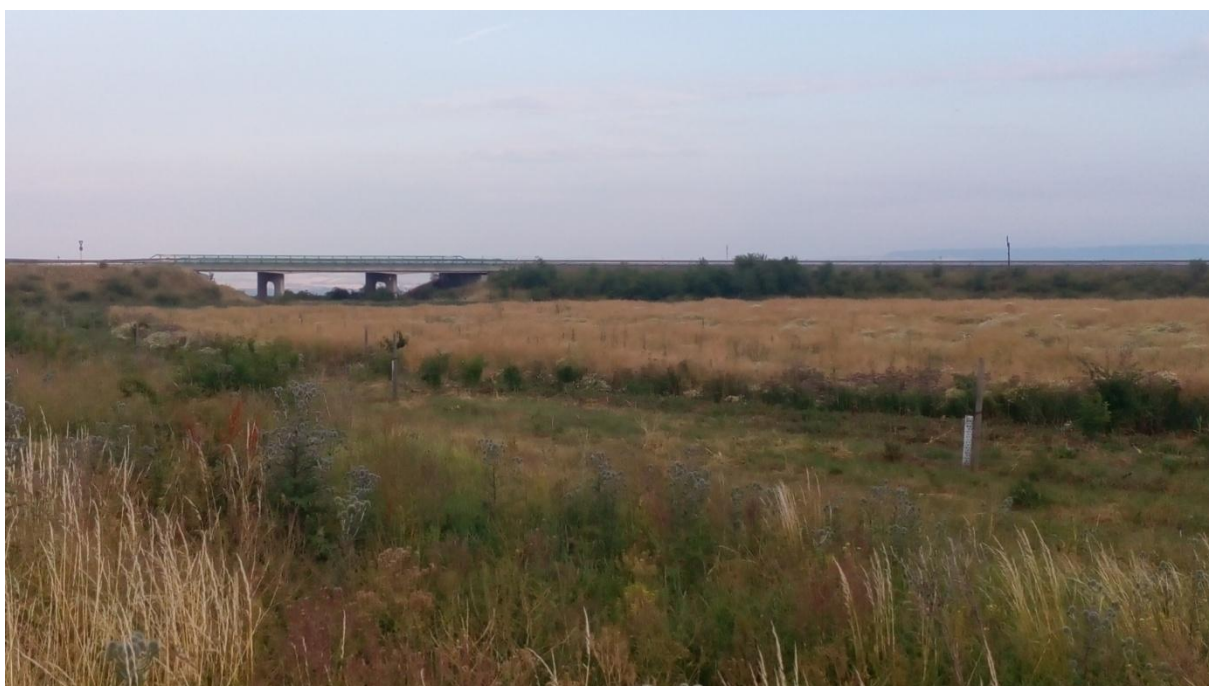
Obrázek 11: Silniční most, pod kterým má vést vlečka
