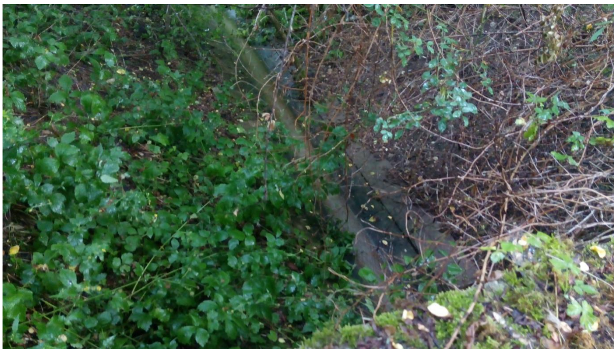
Obrázek 9: Potok vytékající ze sanovaného svahu
