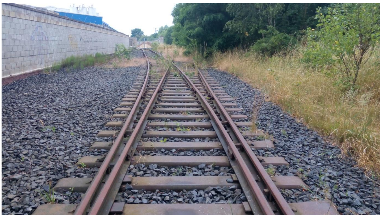
Obrázek 3: Výhybka do firmy KB Blok na ocelových pražcích
