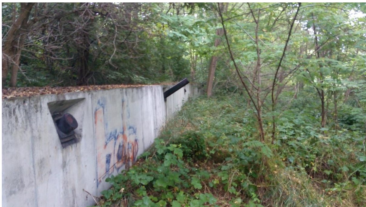
Obrázek 8: Železobetonový věnec nad pilotami pod sanovaným svahem
