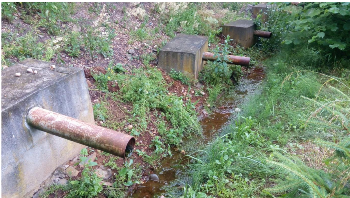
Obrázek 10: Odvodnění sanovaného svahu
