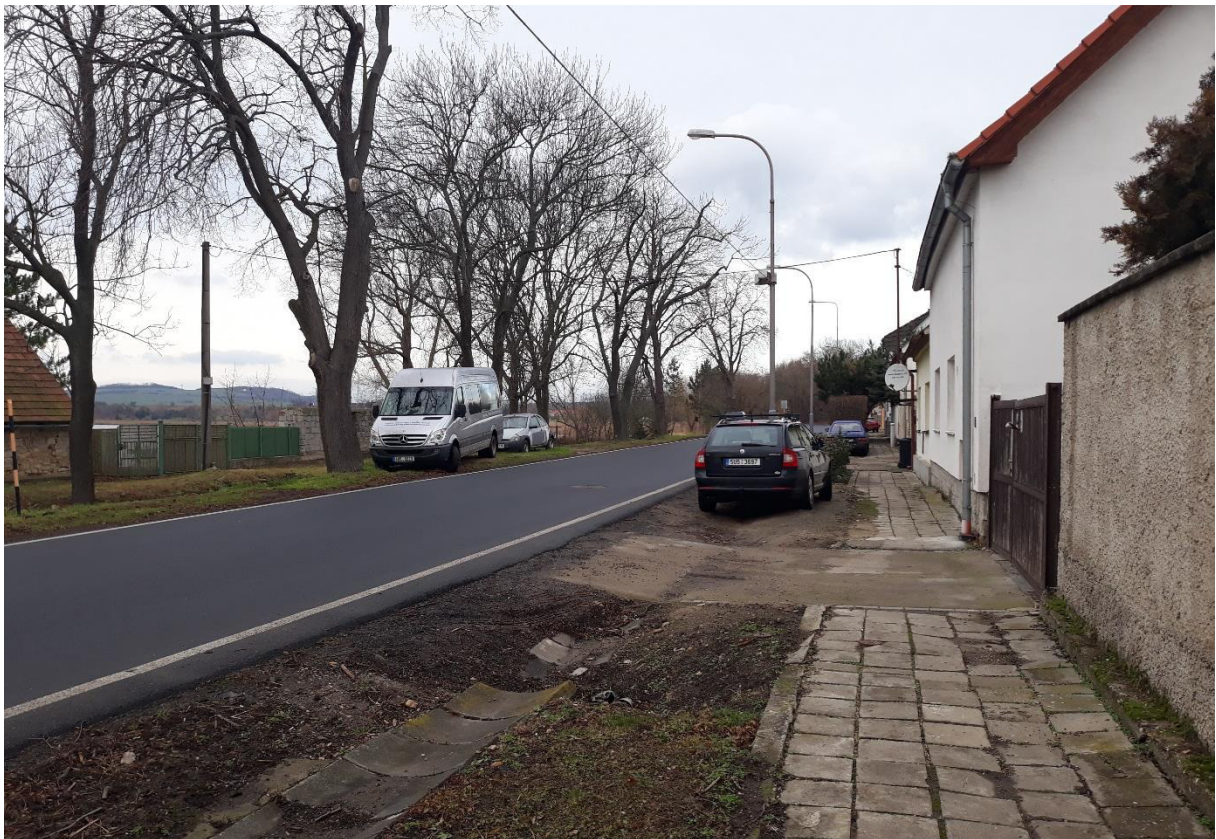
Obr. 65 Ul. Jiráskova, stávající chodník a napojení nemovitosti na komunikaci
