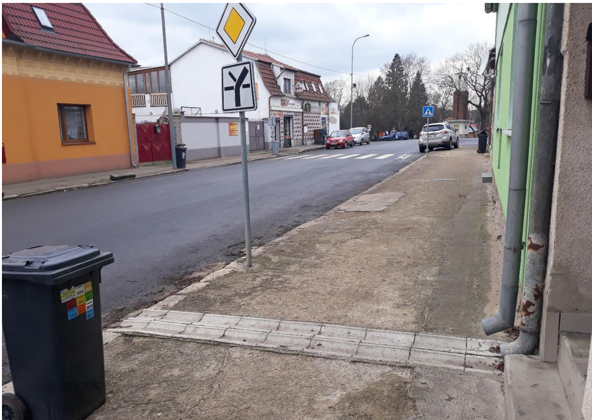
Obr. 18 Ulice Husova, odvodnění přelehle nemovitosti
