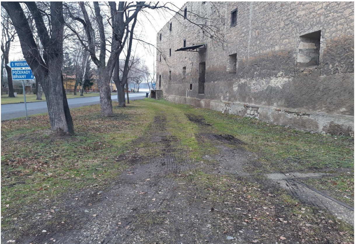
Obr. 47 Ul. Dlouhá, vpravo barokní sýpka, stávající směr chůze chodců
