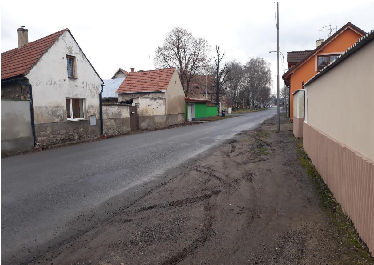
Obr. 41 Ulice Dlouhá, stávající chodník a komunikace
