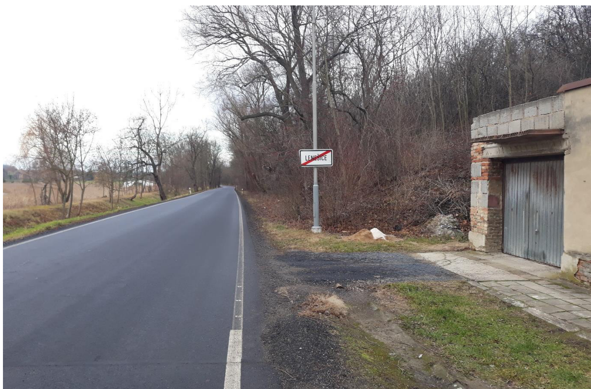
Obr. 71 Ulice Jiráskova, konec obce (IS 12b)
