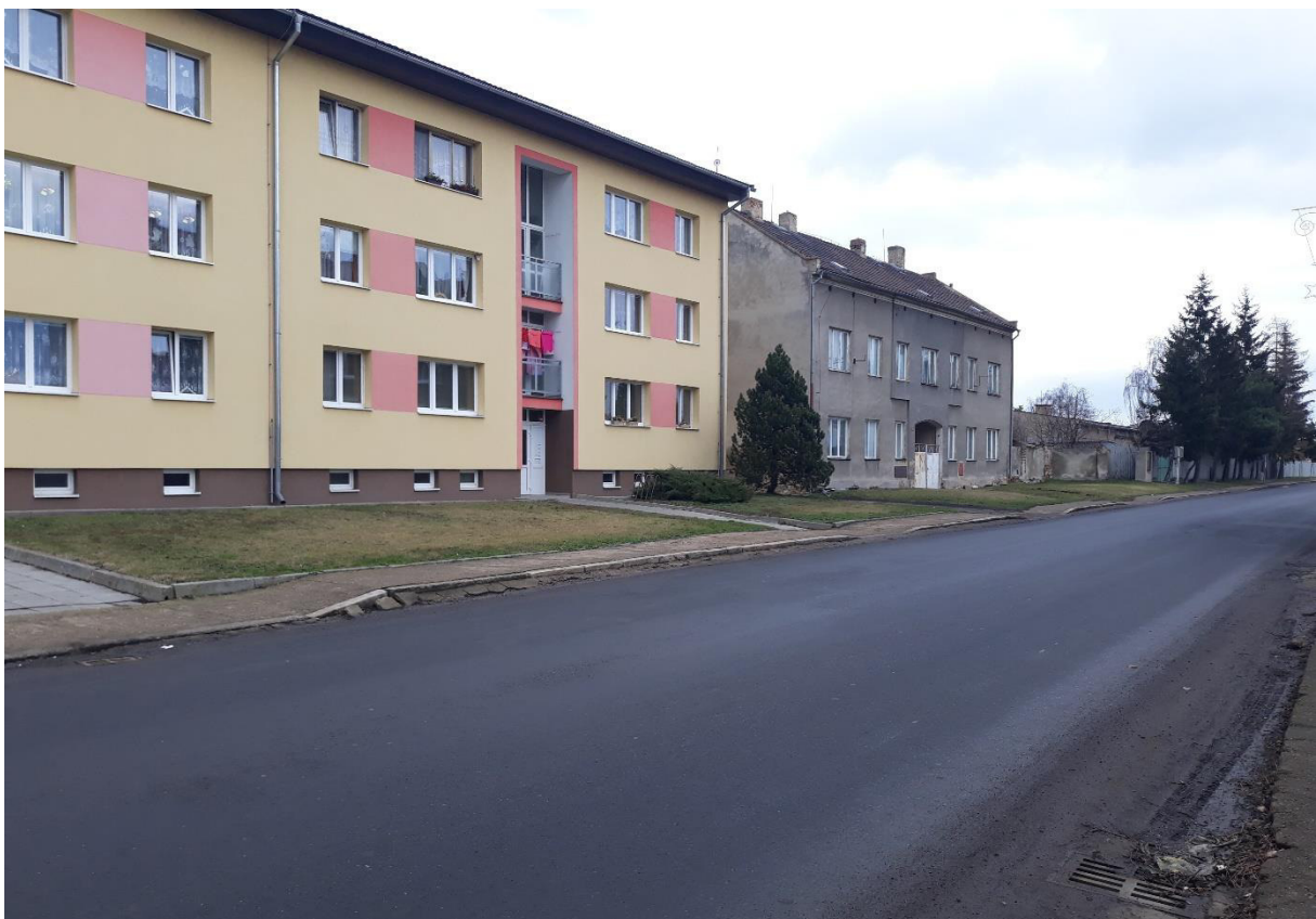
Obr. 9 Ulice Husova, stávající chodník, zbytečně snížená obruba v místech kde nejsou vjezdy pro vozidla
