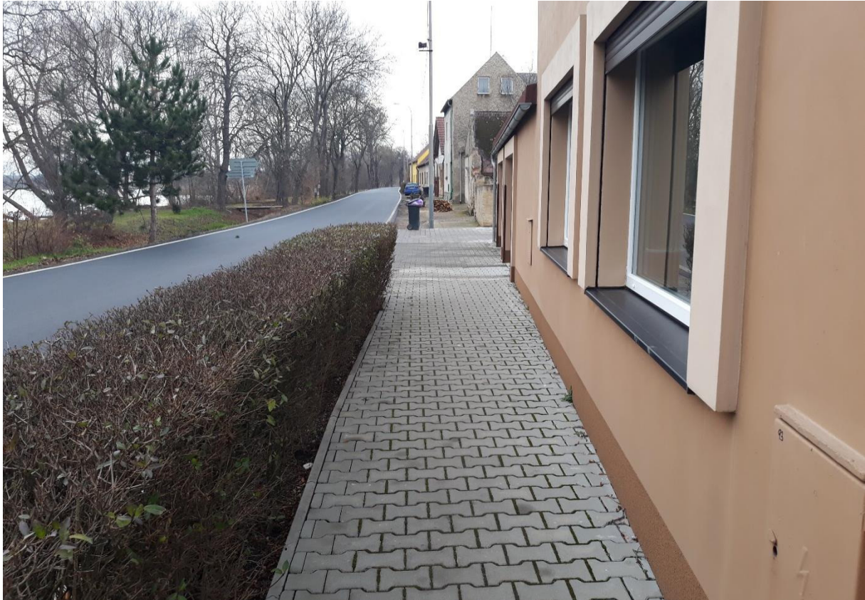
Obr. 56 Ulice Jiráskova, stávající chodník nová dlažba
