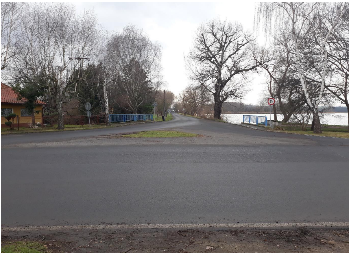
Obr. 52 Křižovatka č.1, pohled ze severu z ul. Dlouhá na komunikaci III/25011
