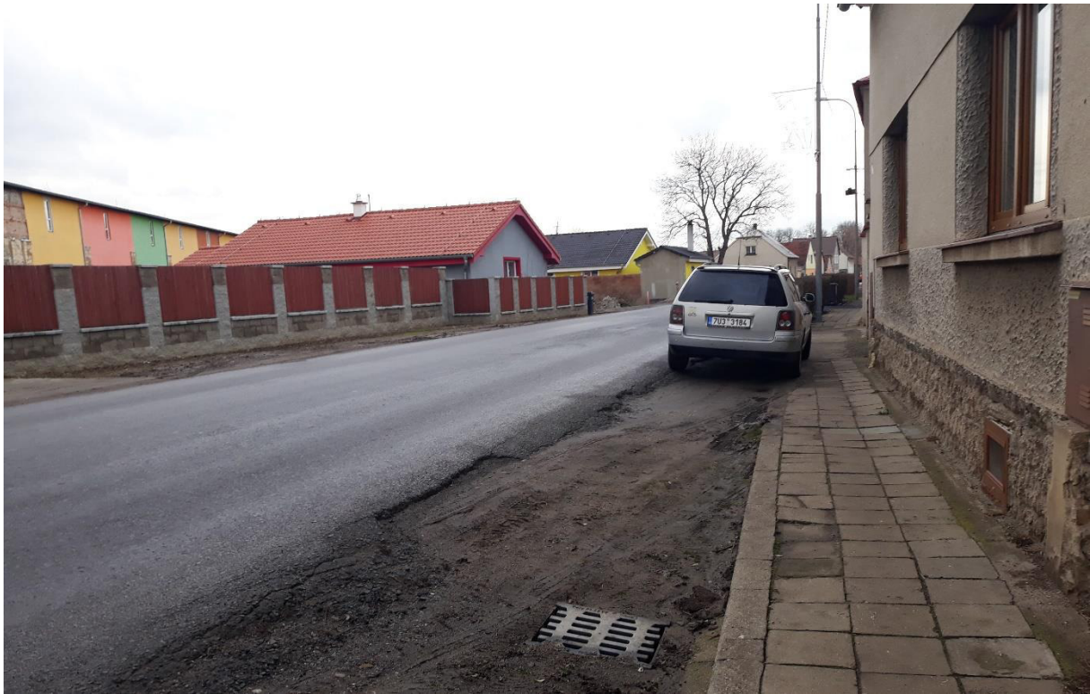
Obr. 32 Ulice Dlouhá, stávající chodník a komunikace
