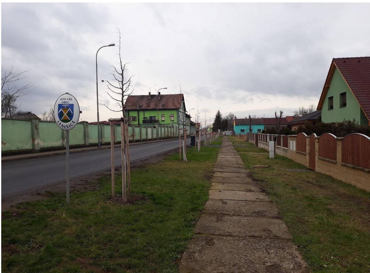
Obr. 2 Počátek obce – stávající chodník, ul. Husova
