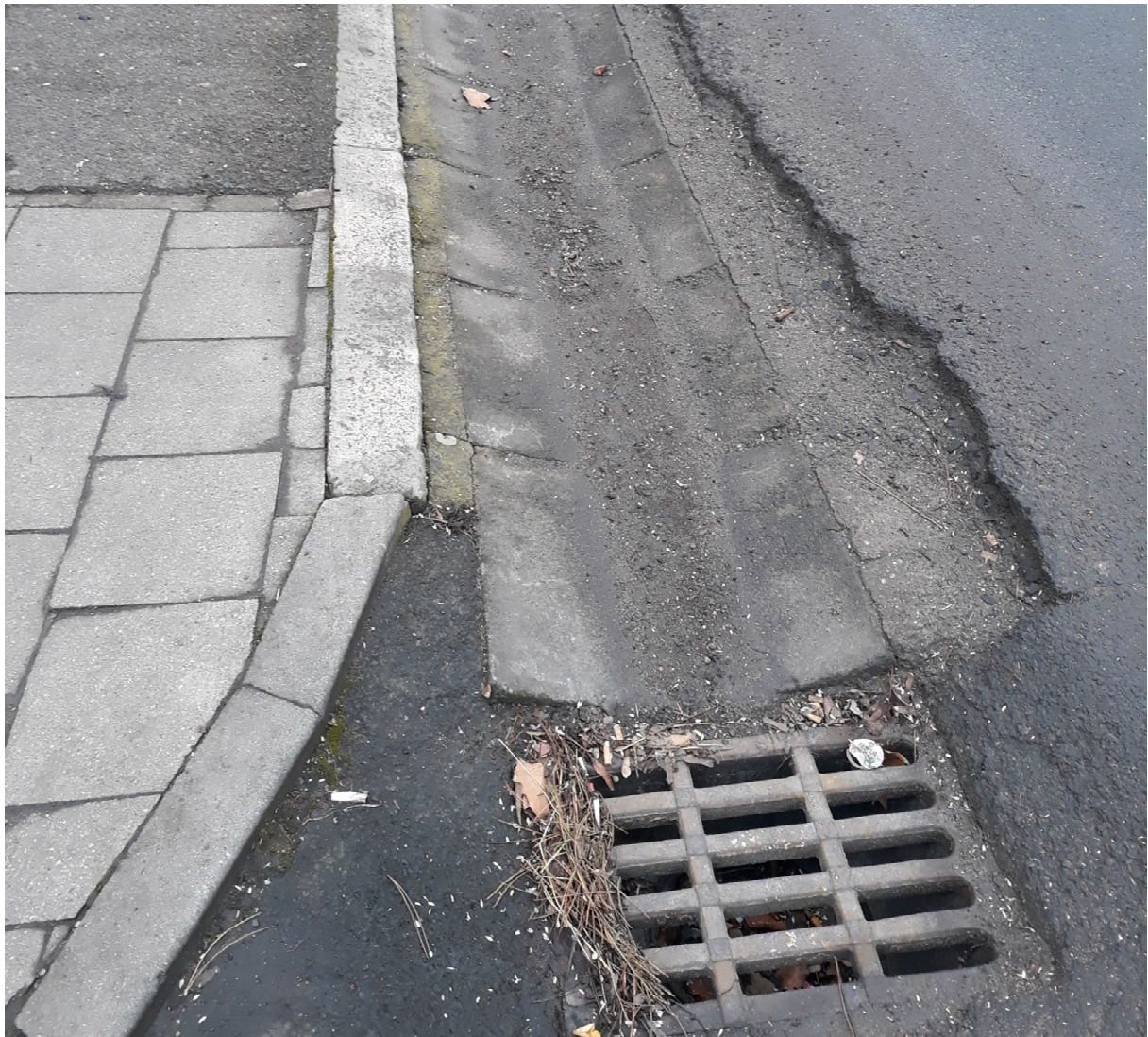
Obr. 29 Odvodňovací žlab s vpustí
