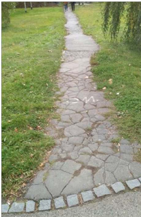
Obr. 5: Stávající chodník vedoucí od kolejí na zastávku Kajetánka
