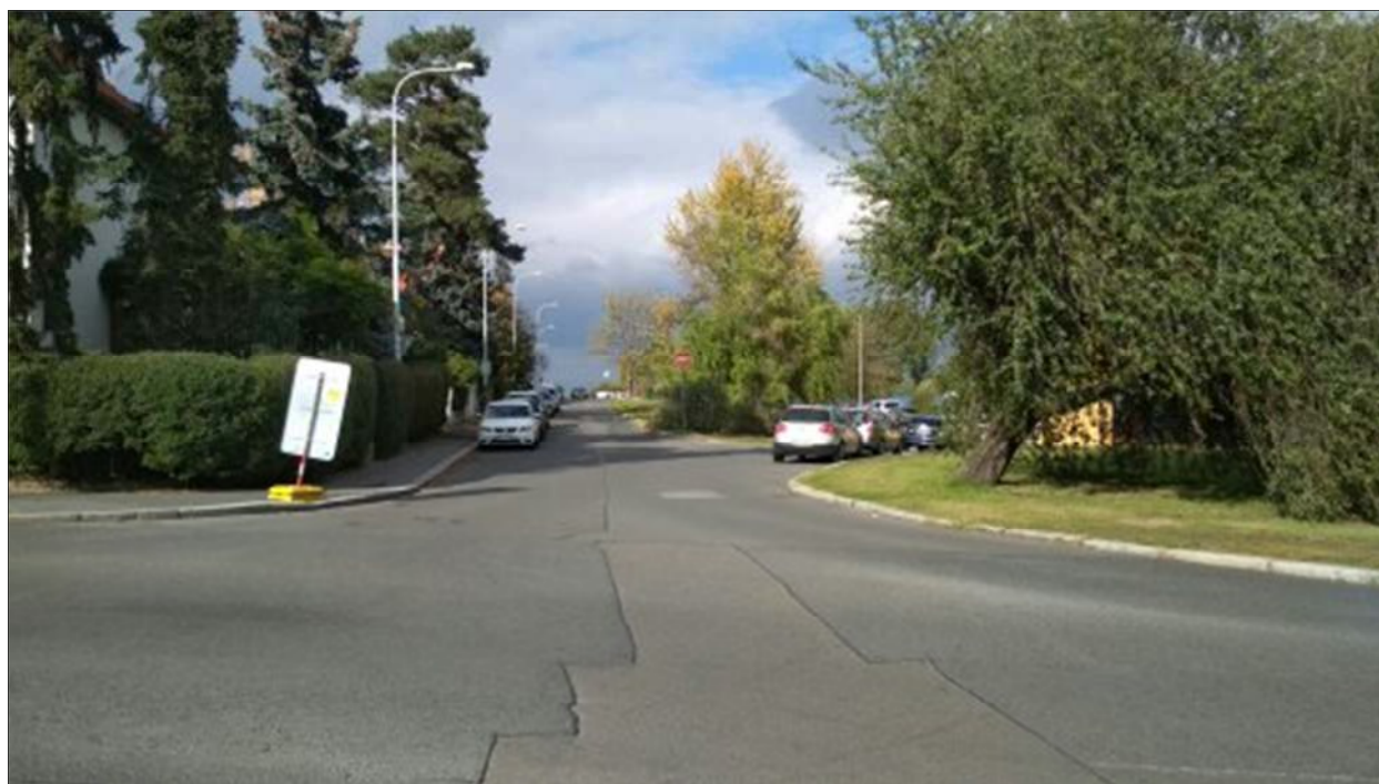
Obr. 16: Styková křižovatka na konci Radimovy ulice (pohled do ulice Stamicova). V křižovatce úplně chybí vodorovné značení, které zdůrazňuje úpravu přednosti v jízdě.
