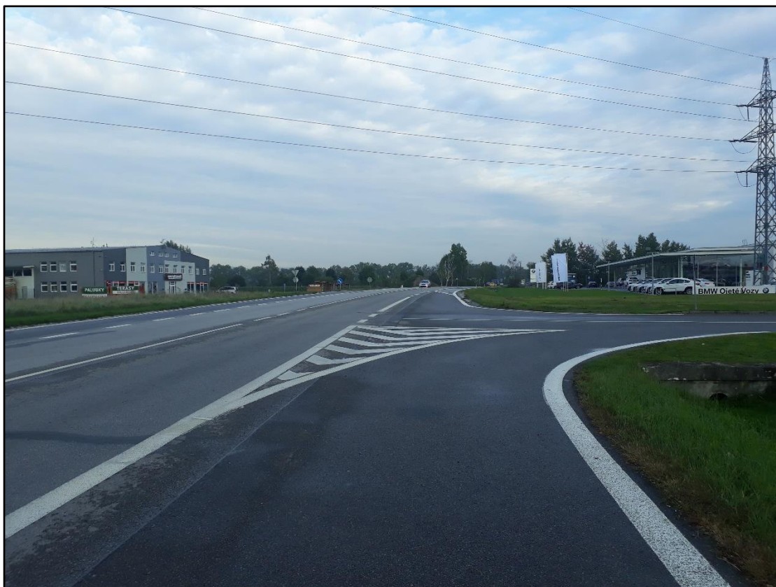
Obr. 8 Vjezd a výjezd z areálu firmy Porsche České Budějovice – pohled ze západu
