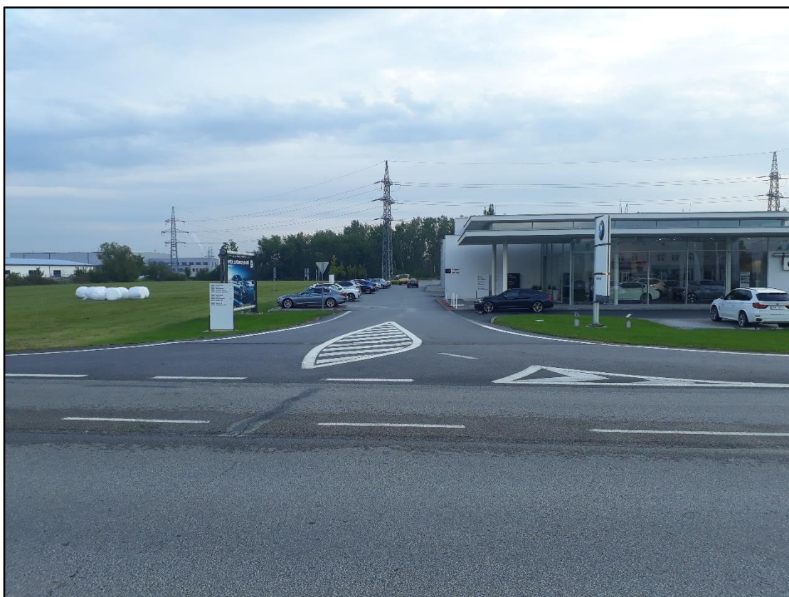
Obr. 12 Pohled na vjezd a výjezd z areálu firmy ACR auto – pohled od severovýchodu
