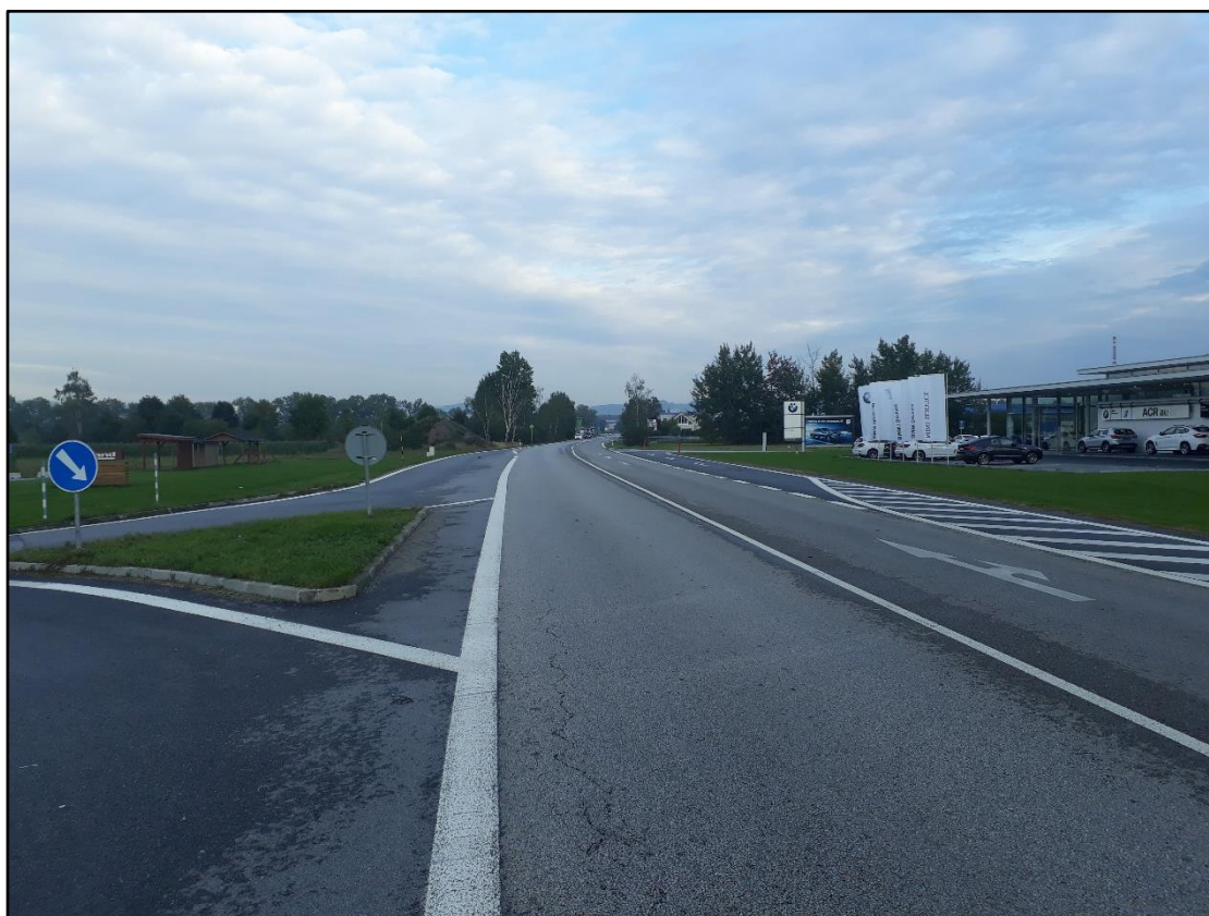
Obr. 10 Pohled v místě napojení firmy Weyland Holz – pohled od severozápadu
