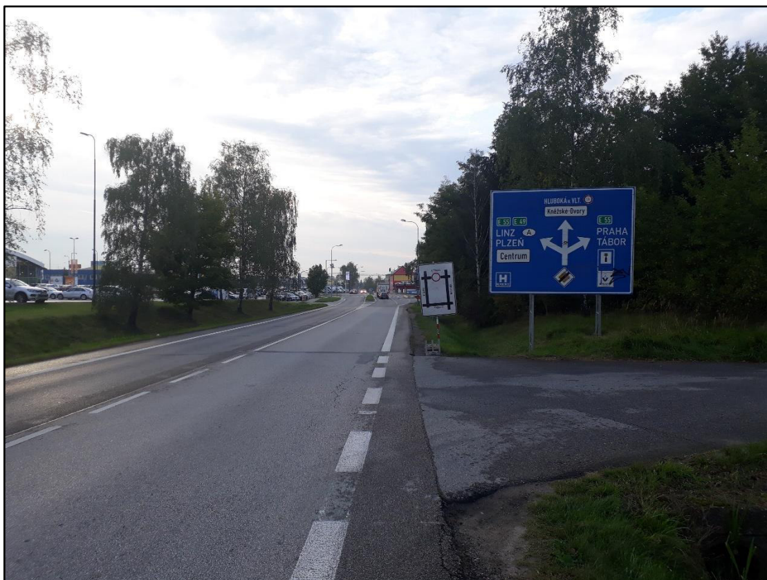
Obr. 7 Napojení na ulici Okružní od Nemanického rybníku – pohled z východu
