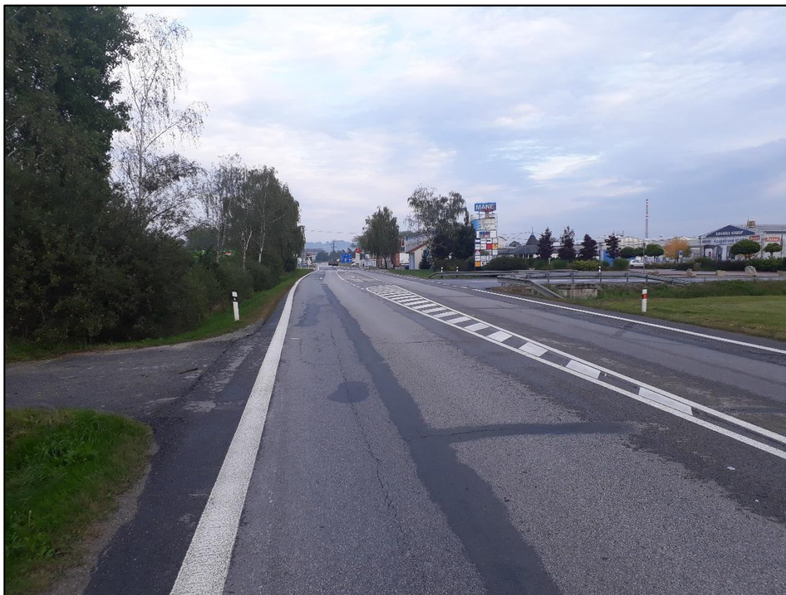
Obr. 13 Vlevo napojení pozemku firmy SpeedPack, vpravo napojení areálu firem MANE, GIENGER a Inter Cars – pohled od severozápadu
