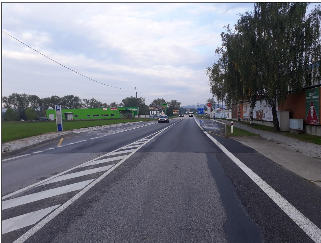
Obr. 15 Pohled na autobusové zastávky před firmou MANE – pohled z východu
