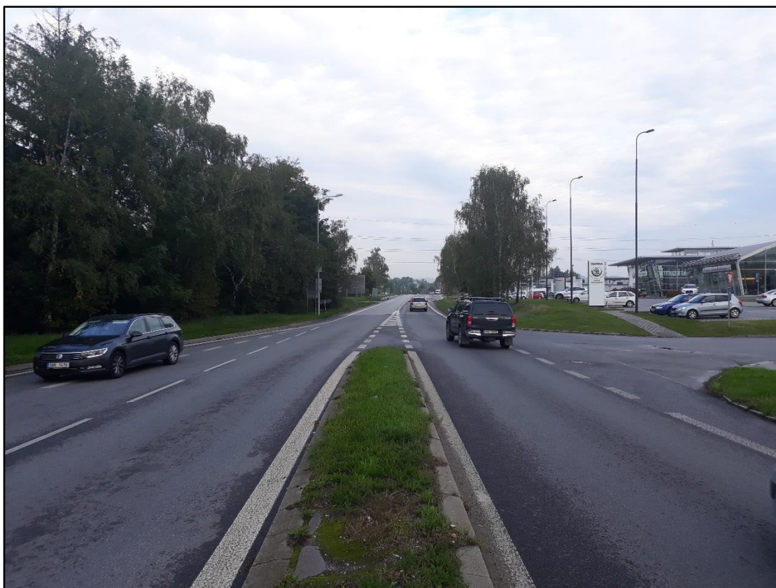
Obr. 2 Pohled na ulici Okružní na začátku staničení – pohled ze západu
