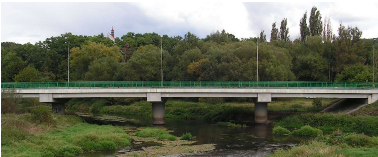
Obrázek 1 Pohled na stávající most přes Úhlavu
