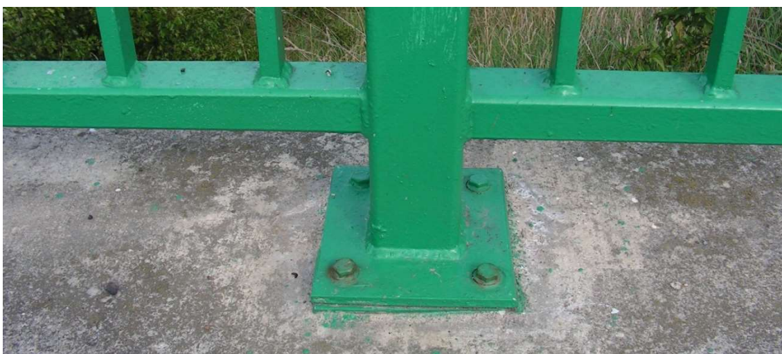
Obrázek 6 Kotvení zábradlí do římsy přes patní desku.
