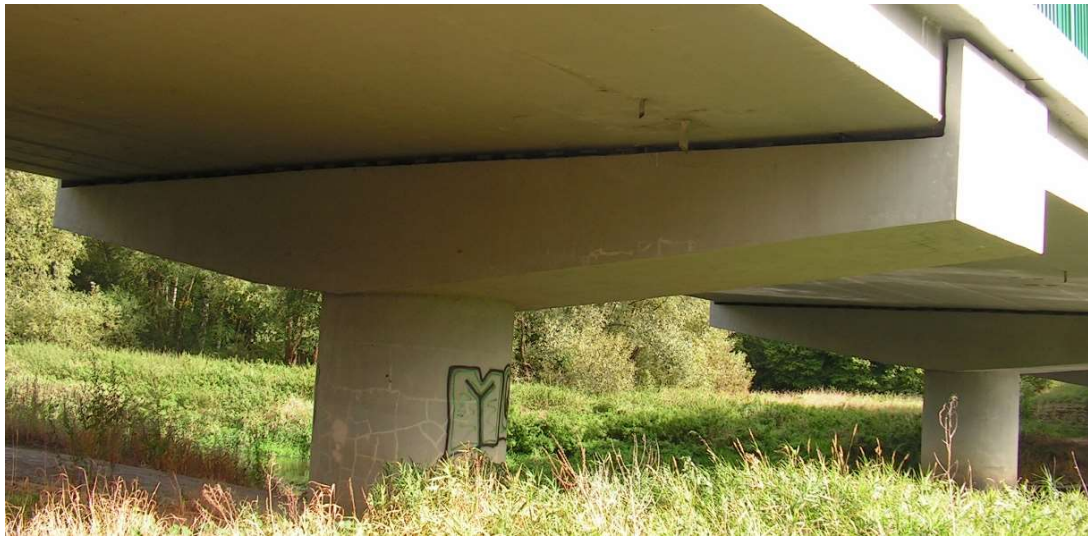
Obrázek 3 Pohled na pilíř mezi 1. a 2. polem stávajícího mostu 2
