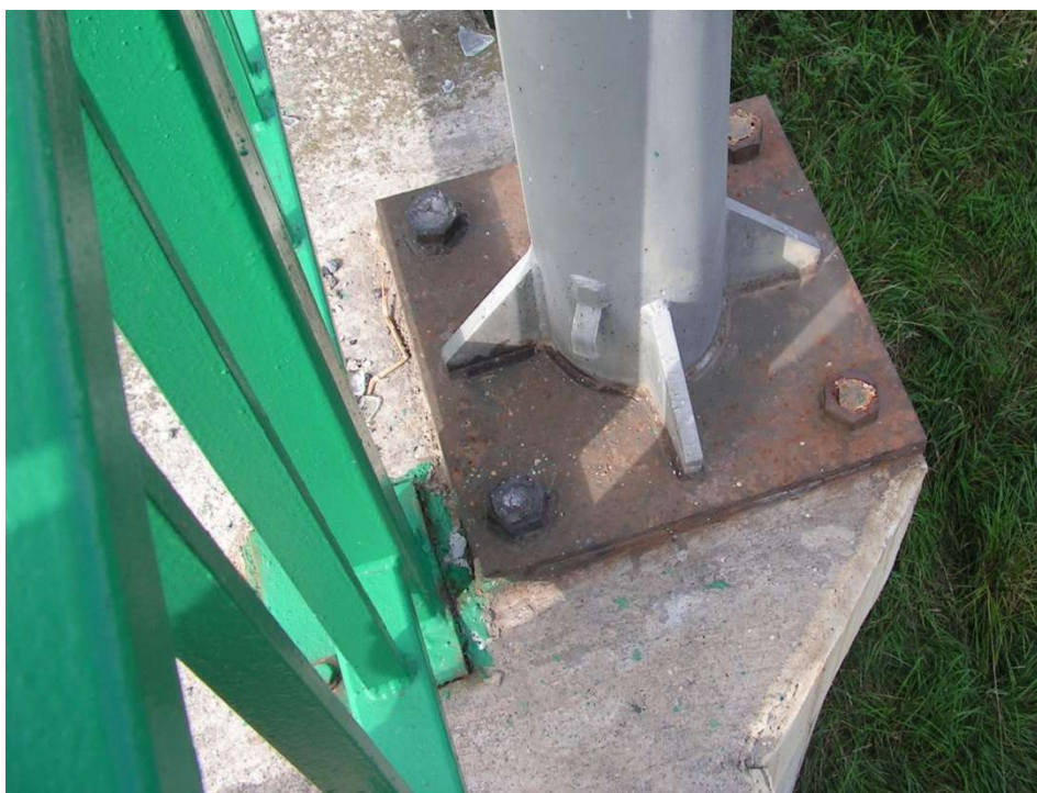
Obrázek 7 Výběžek římsy se zakotvením stožáru veřejného osvětlení
