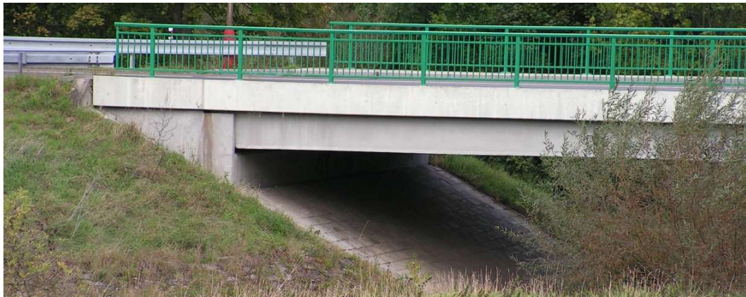
Obrázek 4 Krajní opěra prvního pole stávajícího mostu
