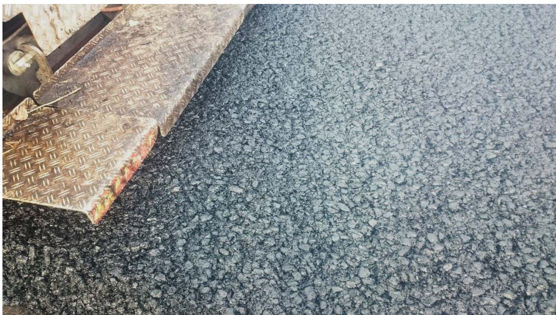
Obrázek 10: Směs SMA L 22 S za hladící lištou finišeru
