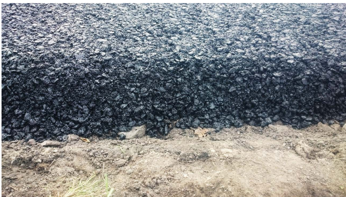
Obrázek 11: Tloušťka vrstvy směsi SMA L 22 S před zhutněním
