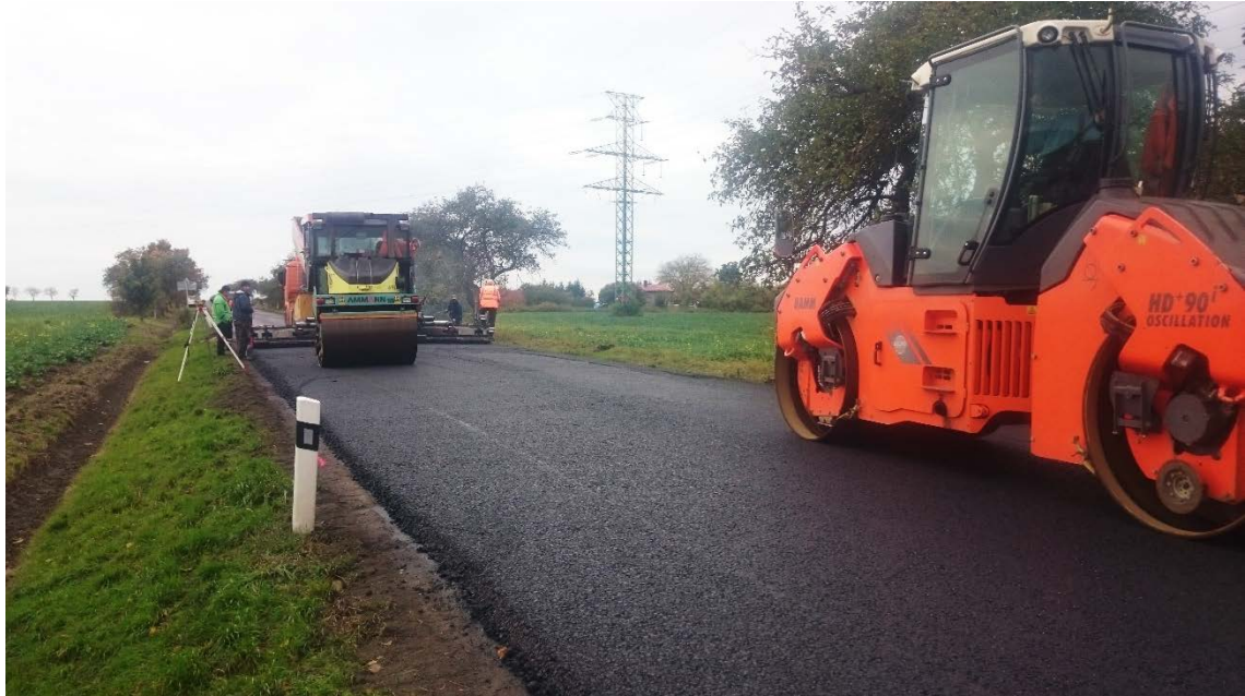
Obrázek 12: Hutnění směsi SMA L 22 S
