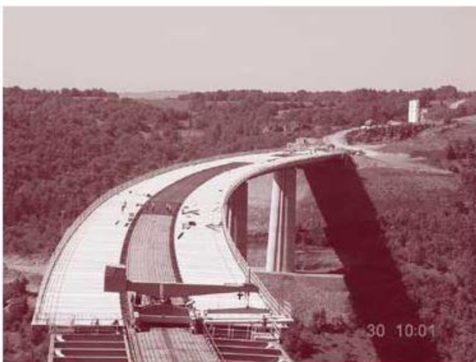
Obrázek 14 Prefabrikované desková mostovka
