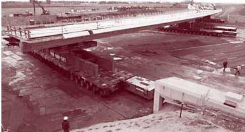
Obrázek 18 Most přemísťovaný pomocí SPMTs
