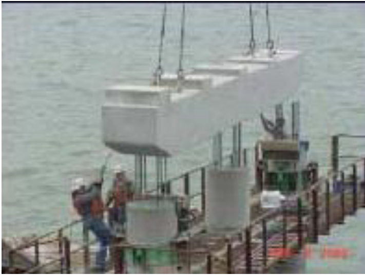
Obrázek 9 Montáž prefabrikovaného stativa
