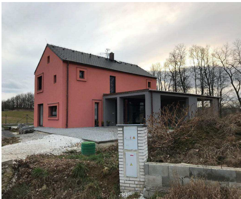
Obrázek 18: Foto pasivního rodinného domu Šulcovi
