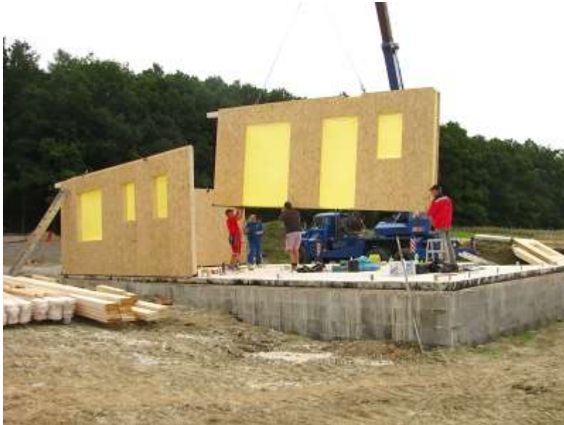
Obrázek 5 Skládání panelů
