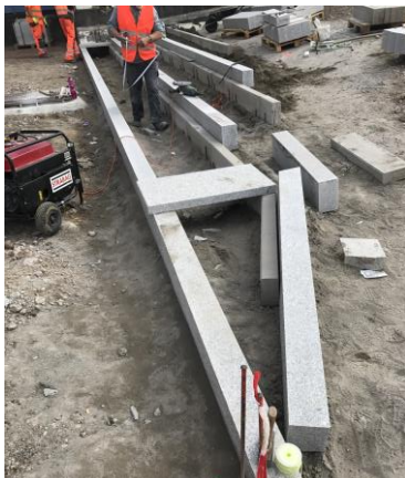
Obrázek 22: Montáž schodiště, zdroj: vlastní fotodokumentace
