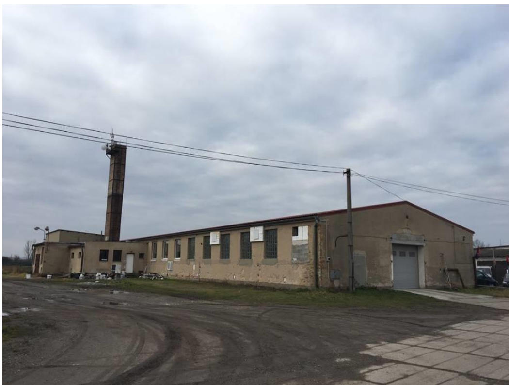
Obr. 27: Brownfield: Hala Záryby.
