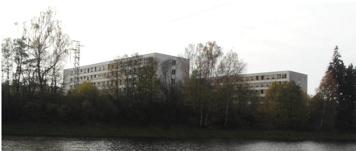
Obr. 45: Bytové domy v týnci nad Vltavou.
