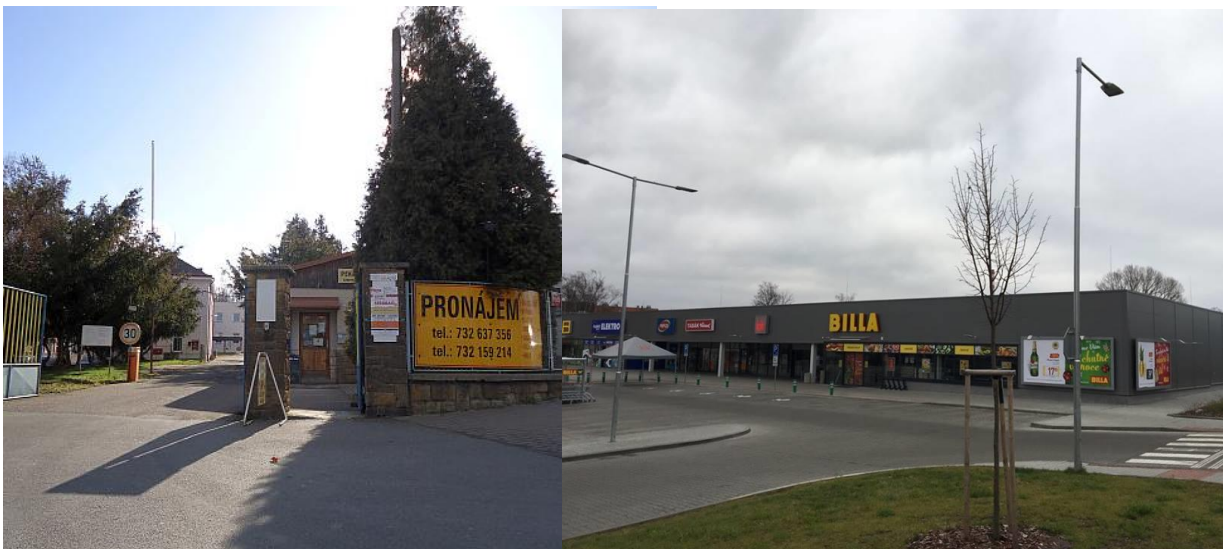
Obr. 39: Plynárna Kolín, před rekonstrukcí (vlevo) [66] a po rekonstrukci. (vpravo)
