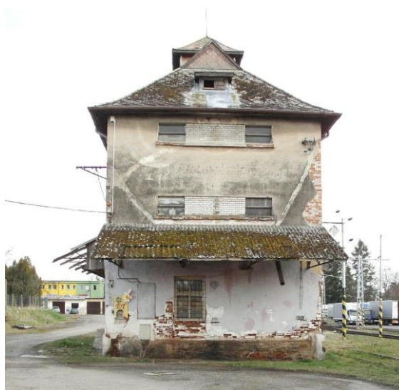
Obr. 46: Budova určená pro drážní dopravu.
