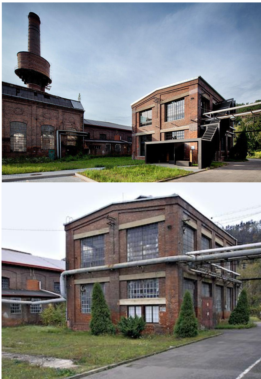
Obr. 40: Uhelný mlýn s kotelnou, před rekonstrukcí (nahore) a po rekonstrukci (dole). [67]
