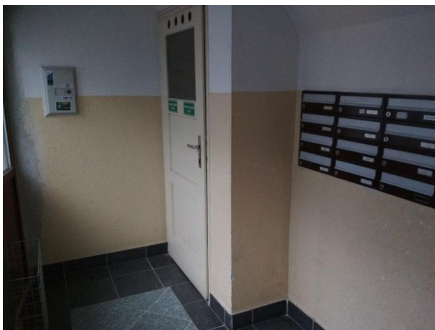
Obrázek 6 Vstup do sklepa
