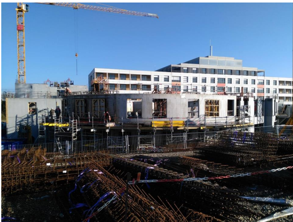
Obrázek 48 Výstavba nové nemocnice v Pornichet (vytvořeno autorem)
