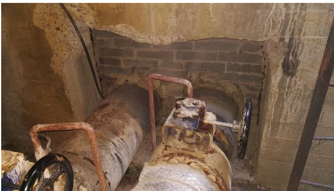
Obrázek 9: Degradace výztuže železobetonu a roznášecích nosníků Zdroj: vlastní tvorba.
