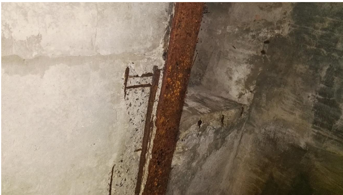
Obrázek 9: Degradace výztuže železobetonu a roznášecích nosníků Zdroj: vlastní tvorba.
