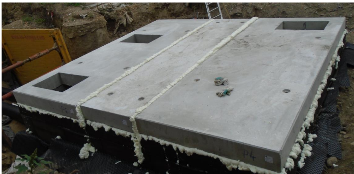
Obrázek 23: Zmonolitnění železobetonových panelů PUR pěnou
