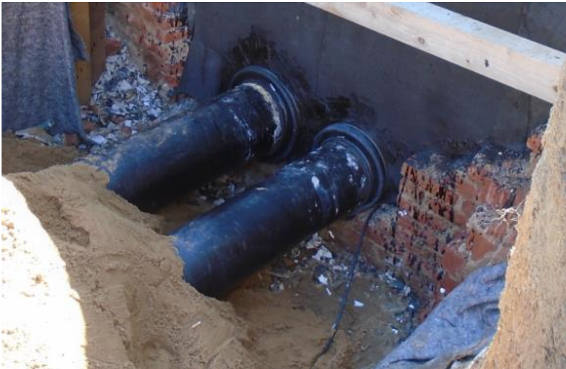
Obrázek 22: Protažení sdělovacího kabelu chráničkou pro potrubí
