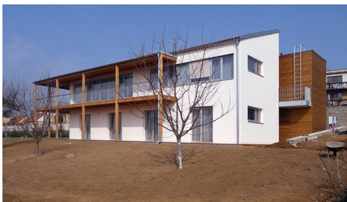
Obr. 46 - Pohled na budovu z jihu (13)
