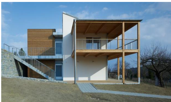
Obr. 45 - Pohled na budovu ze západu (13)
