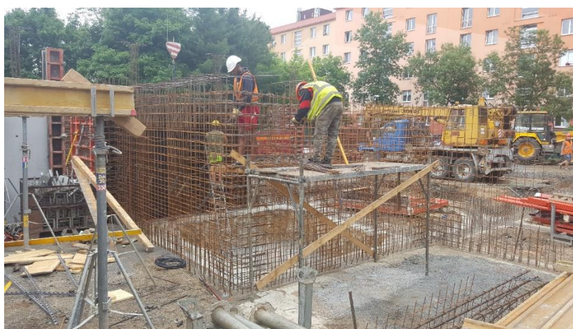
Obr. 16 Práce ve výškách - armování
