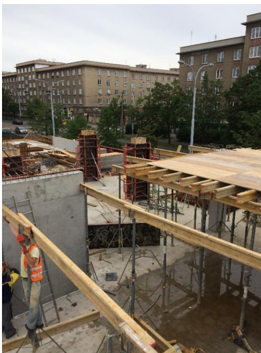
Obr. 18 Nepoužívání dočasné konstrukce
