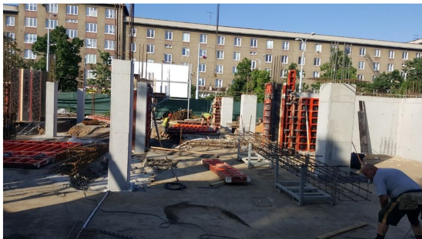
Obr. 7 Nedodržování používání OOPP (I)
