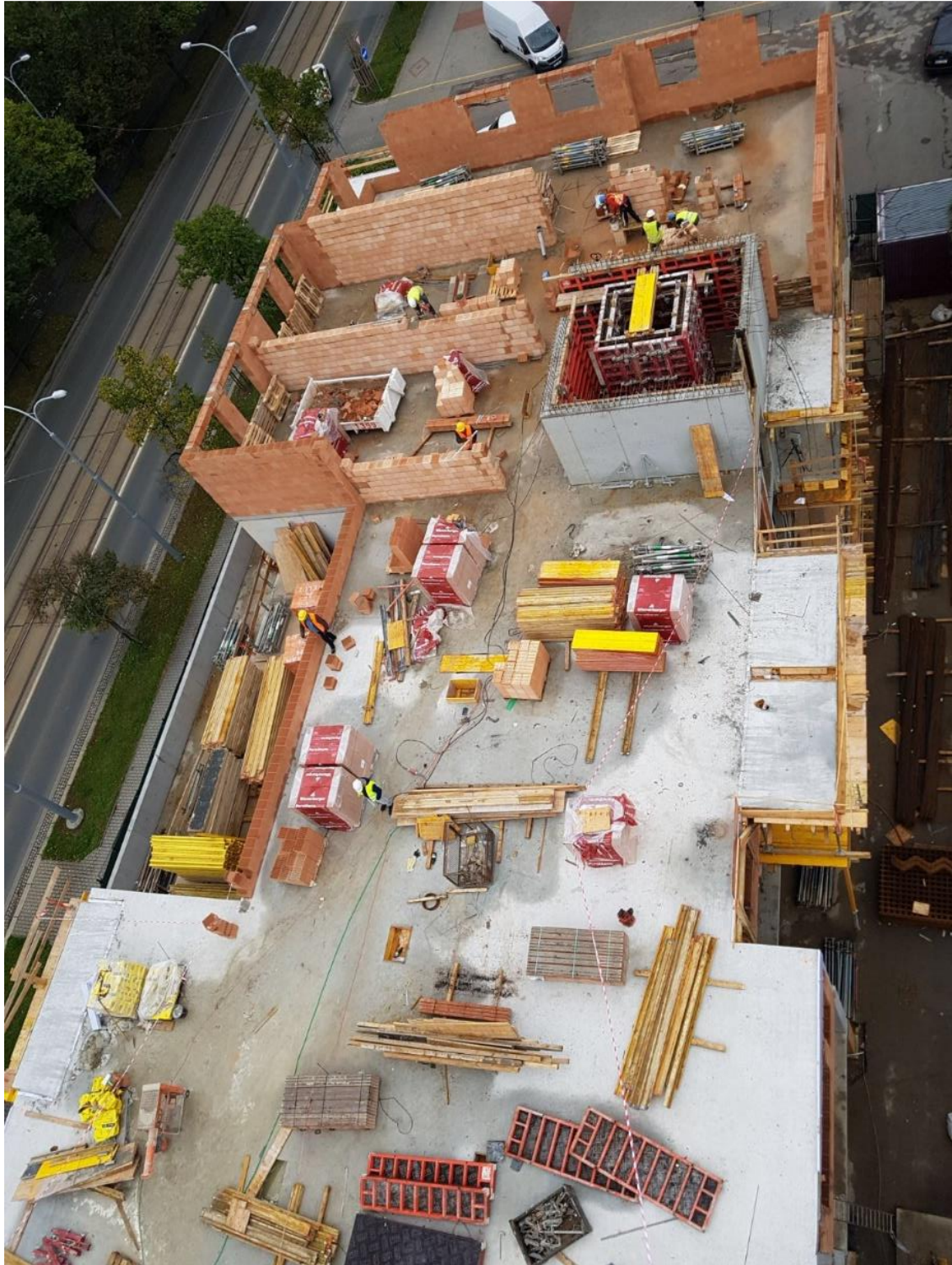
Obr. 3 Realizace bytového domu Koterovská
