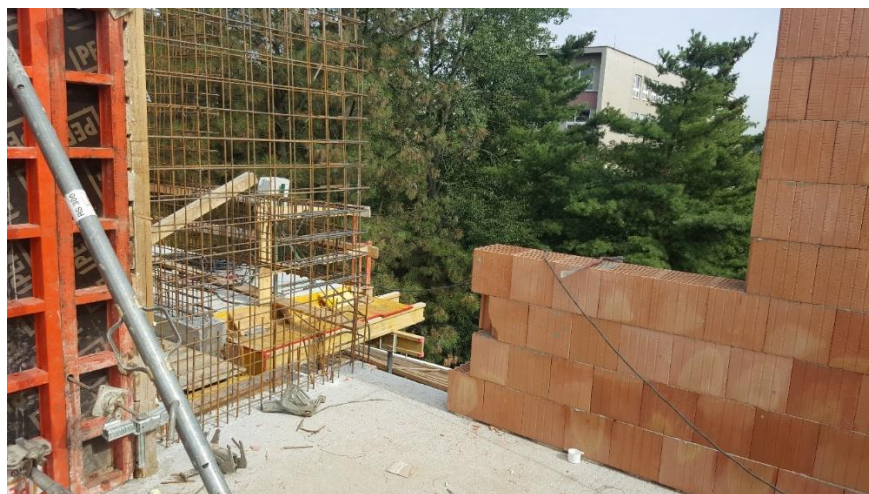
Obr. 22 Nebezpečí pádu z výšky (II)
