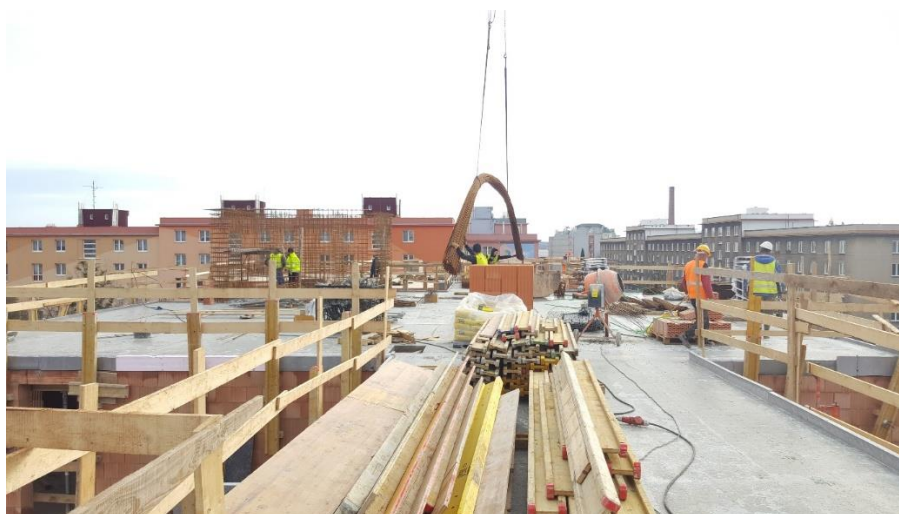
Obr. 9 Práce pod zavěšeným břemenem
