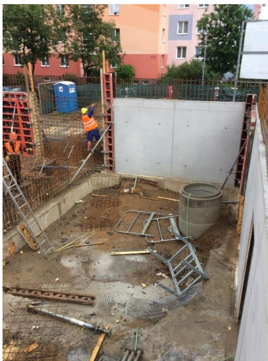
Obr. 17 Výztuž využítá k práci ve výškách
