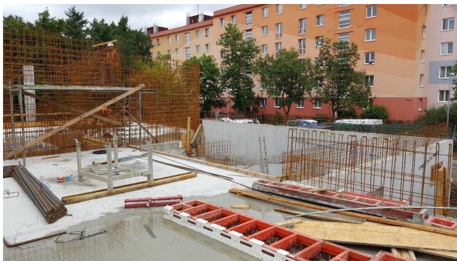
Obr. 23 Nebezpečí pádu z výšky (III)
