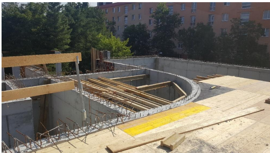
Obr. 21 Nebezpečí pádu z výšky (I)
