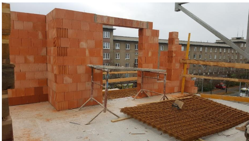
Obr. 37 Nebezpečné lešení
