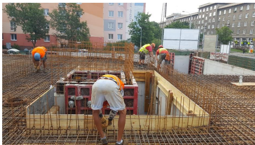
Obr. 14 Nebezpečí pádu z výšky - armování
