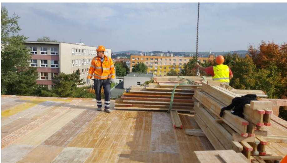
Obr. 19 Pohyb ve výškách bez zajištění
