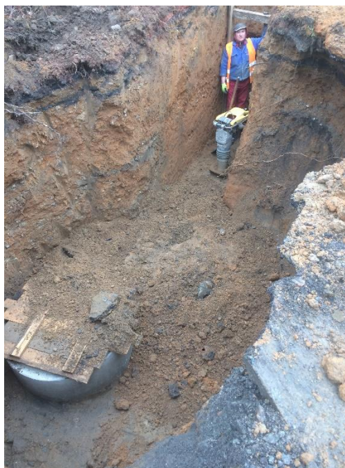
Obr. 11 Nprovedení pažení výkopu (II)
