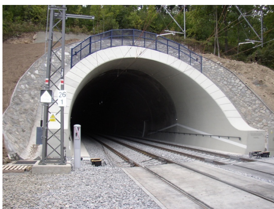
Obr. 2 –Tunel Krasíkov; zdroj: vlastní
