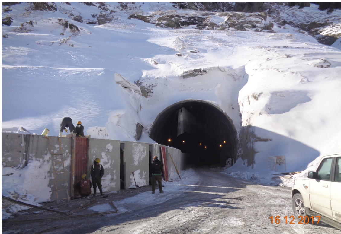
Obr. 21 – Rohtang tunel - severní portál; zdroj: vlastní
