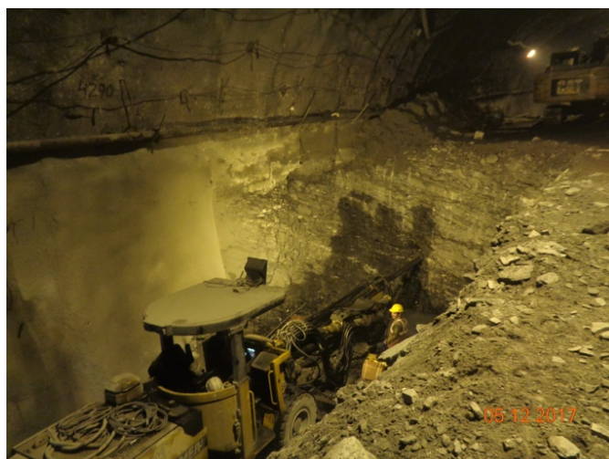
Obr. 25 – Strojní vrtání pro odpal v jádře; zdroj: vlastní
