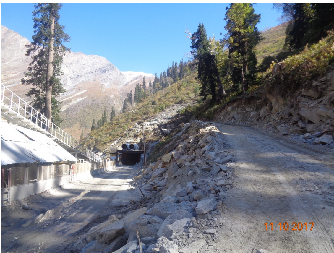
Obr. 20 – Rohtang tunel – jižní portál; zdroj: vlastní
