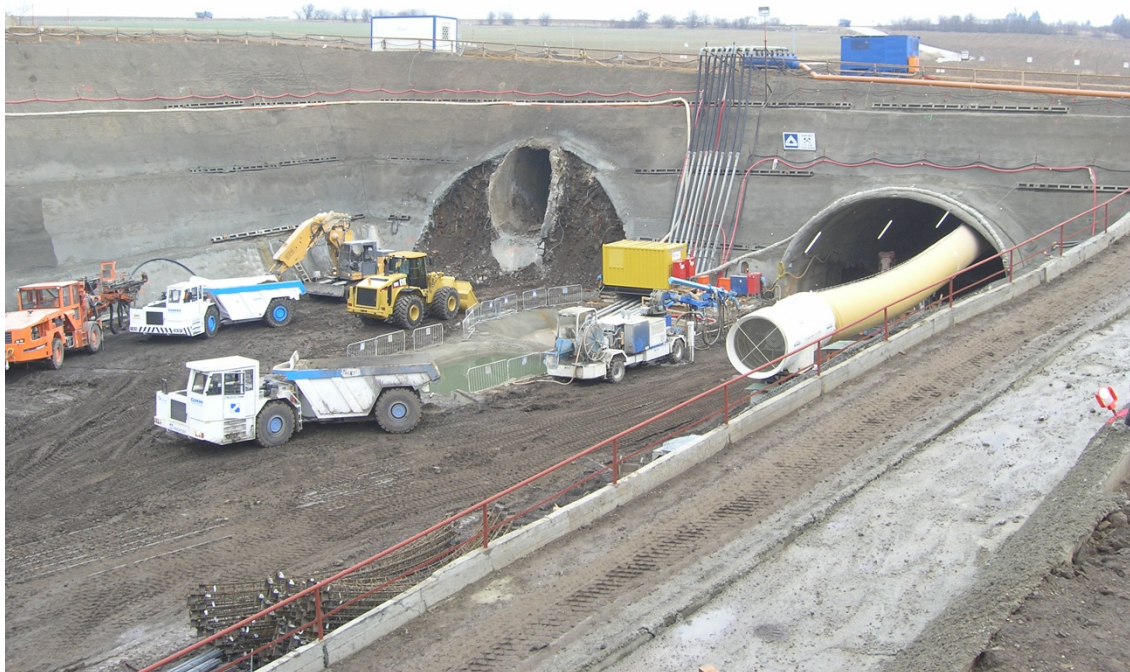
Obr. 7 – Strojní sestava používaná při ražbě NRTM; zdroj: vlastní
