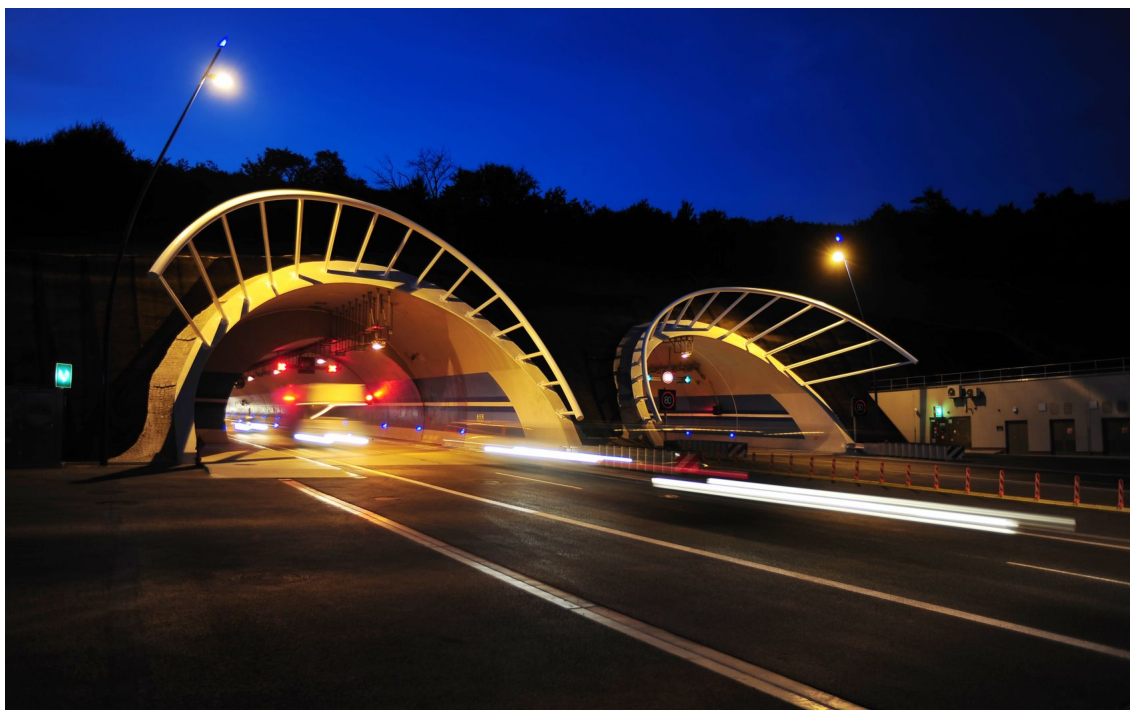
Obr. 1 – Tunel Lochkov; zdroj: vlastní
