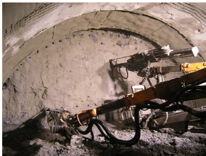
Obr. 24 – Strojní vrtání čelby kaloty na odpal; zdroj: vlastní
