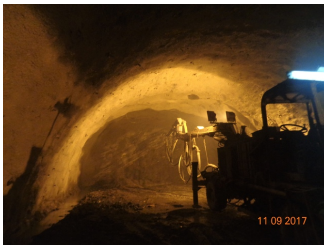
Obr. 23 – Strojní stříkání při razbě kaloty; zdroj: vlastní
