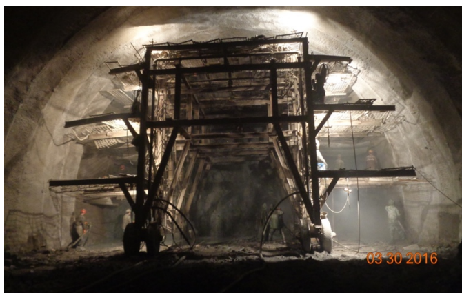
Obr. 13 – Ruční vrtání z pojízdného lešení; zdroj: vlastní
