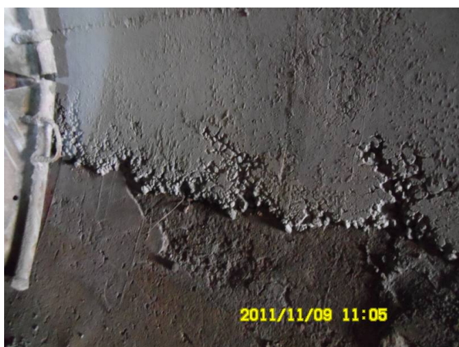
Obr. 15 – Konstrukční spára; zdroj: vlastní
