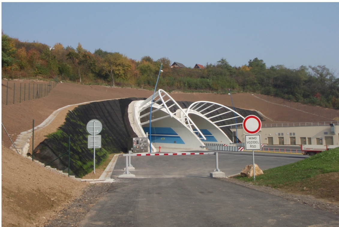
Obr. 5 – Tunel Lochkov (Radotínský portál); zdroj: vlastní
