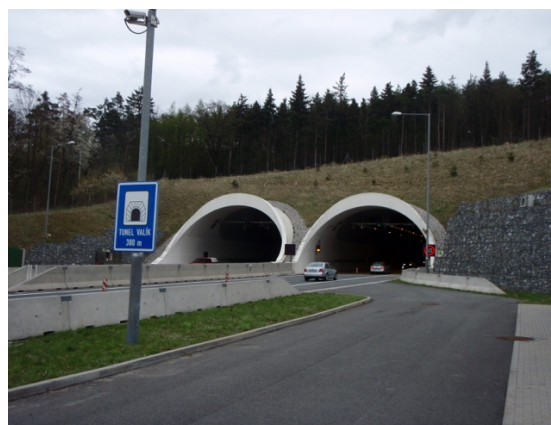
Obr. 3 –Tunel Valík; zdroj: vlastní
