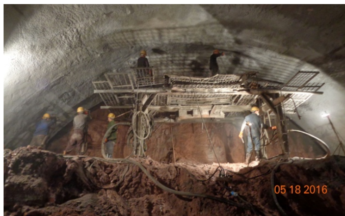
Obr. 12 – Ruční vrtání z lešení na čelbě kaloty; zdroj: vlastní
