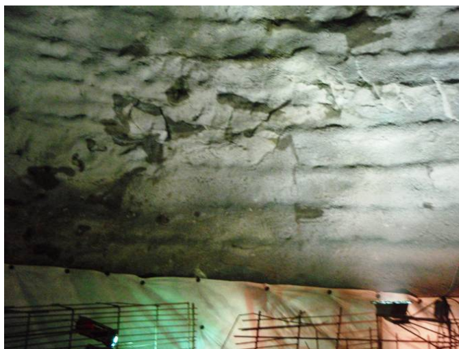
Obr. 18 – Primární ostění před pokládkou izolace; zdroj: vlastní
