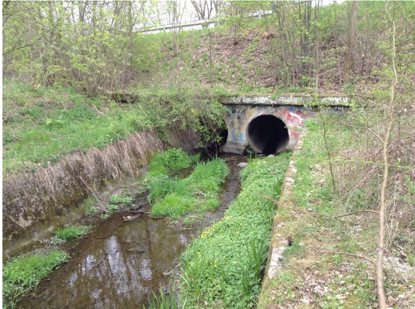
Obrázek č. 36 – Usazovací nádrž před propustkem (foceno po vodě)
