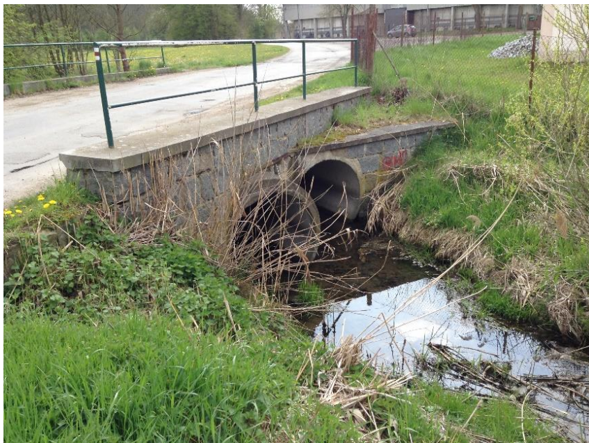
Obrázek č. 42 – Betonový propustek pod silnicí (foceno proti vodě)
