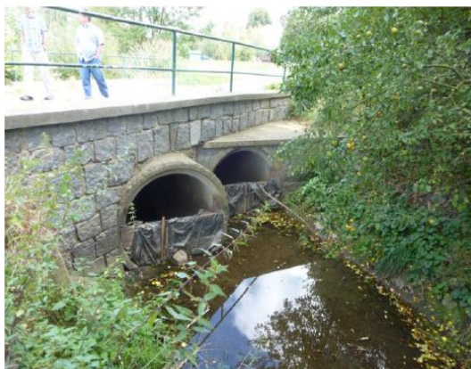
Obrázek č. 27 – Pohled na objekt z horní vody
