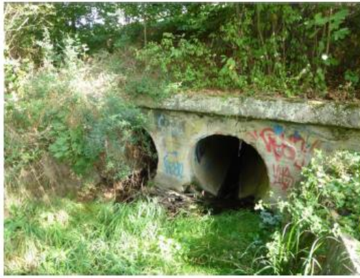
Obrázek č. 20 – Pohled na objekt z horní vody
