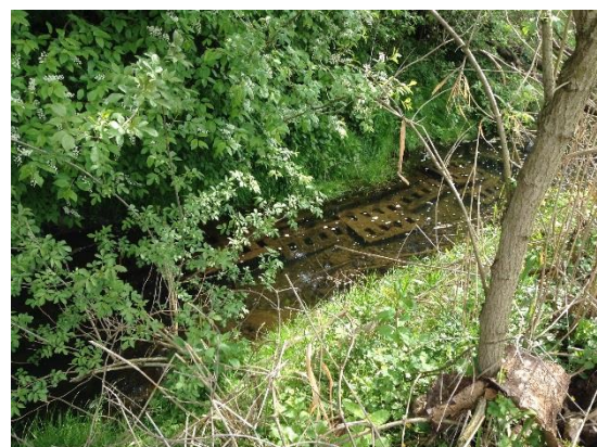
Obrázek č. 58 – Posunutě opevnění
