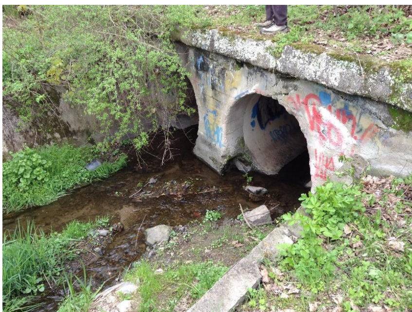
Obrázek č. 35 – Betonový propustek pod silnicí II. třídy (foceno po vodě)
