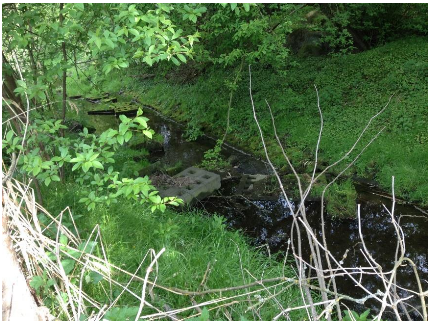
Obrázek č. 49 – Vymleté polovegetační tvárnice (foceno proti vodě)
