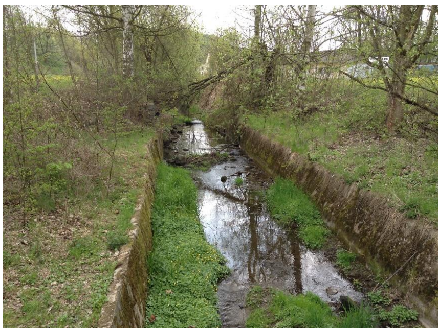
Obrázek č. 37 – Usazovací nádrž před propustkem (foceno proti vodě)
