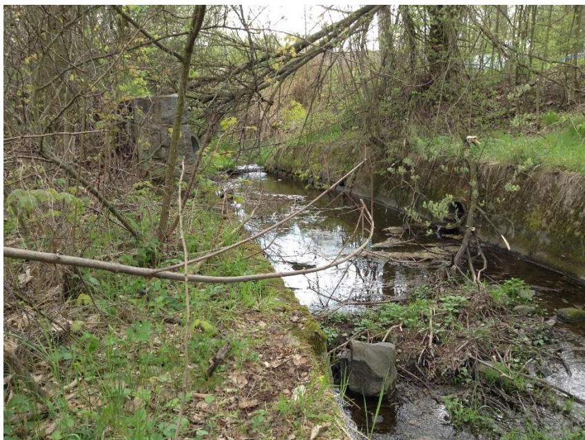
Obrázek č. 38 – Zaústění dešťové kanalizace DN400, DN500 (proti vodě)
