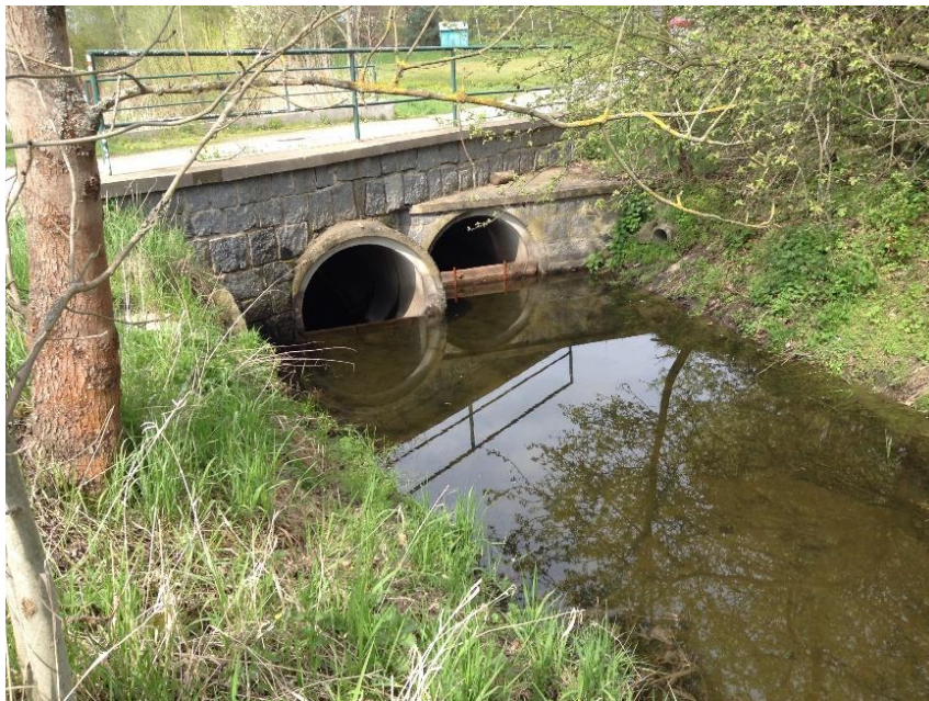
Obrázek č. 43 – Betonový propustek pod silnicí (foceno po vodě)
