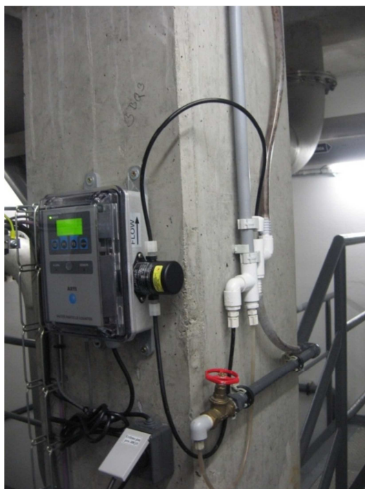
Obrázek 11: Přívod a odtok vody z čítače částic
