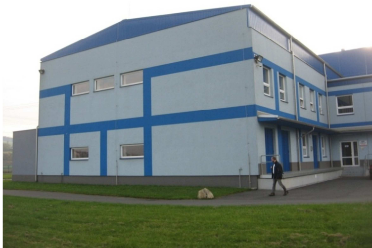
Obrázek 9: Pohled na vstup a manipulační rampu úpravny vody
