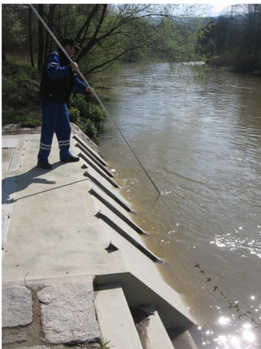
Obrázek 12: Ukázka shrabování česlí na odběrném objektu (vlevo)
