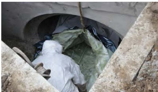
Obr. 9.4: Instalace rukávce [18]
