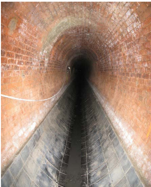
Obr. 10.5: Zděná stoka sanovaná čedičovým žlábkem [29]
