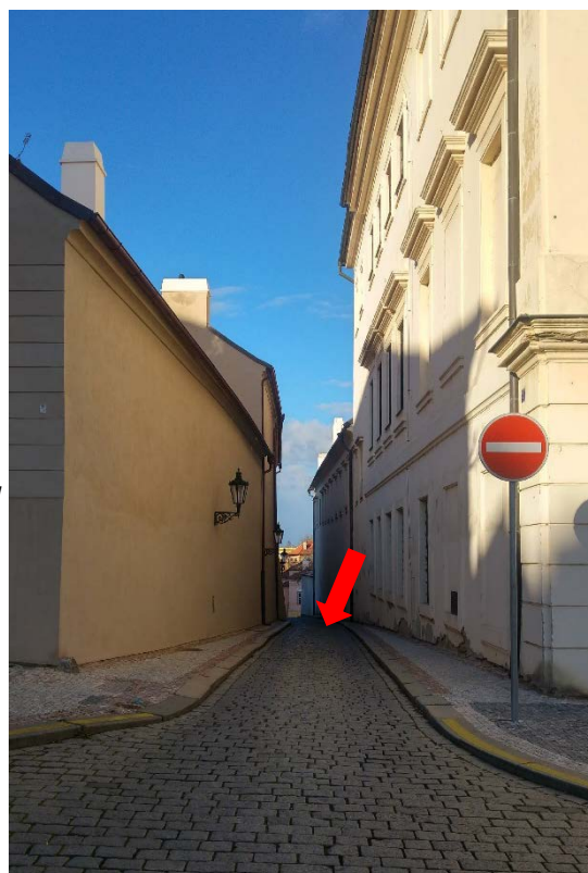
Obr. 11.15: Pohled do ulice U Kasáren severně, označené místo propadlé klenby
