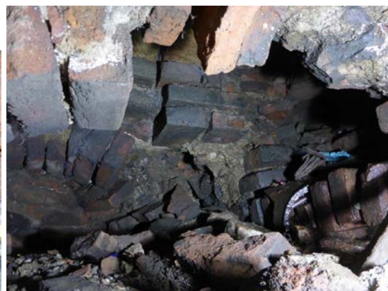
Obr. 11.14: Pohled do koncové šachty shora [33]
