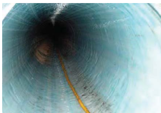
Obr. 9.5: Instalovaný a vytvrzený rukávec [18]
