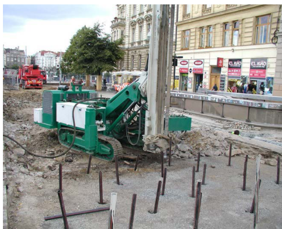
Obr. 10.8: Injektáž z povrchu za ostění [27]
