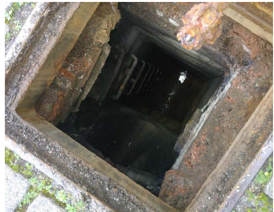
Obr. 11.9: Pohled shora do spadiškové šachty
