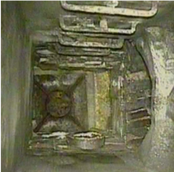
Obr. 11.8: Pohled zespod do spadiškové šachty se zaústěním uliční vpusti a úseku 2 stoky [32]
