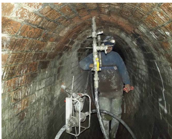
Obr. 10.7: Injektáž z vnitřku štoly za ostění [27]
