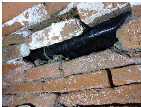
Obr. 11.12: Lepenka použitá místo cihel [33]
