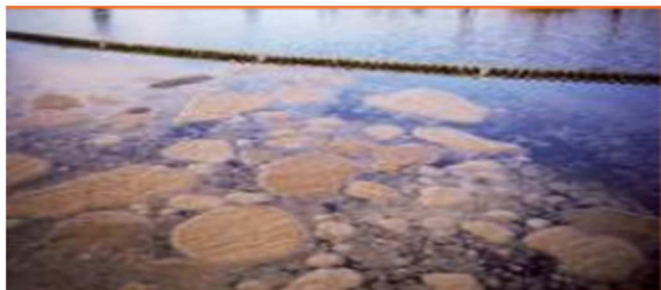
Obr. 5 Vzplývající kal v DN
