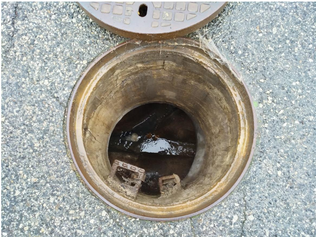
Obr. 8 MP 8 - Dešťová kanalizace Nová ul. č.p. 685
