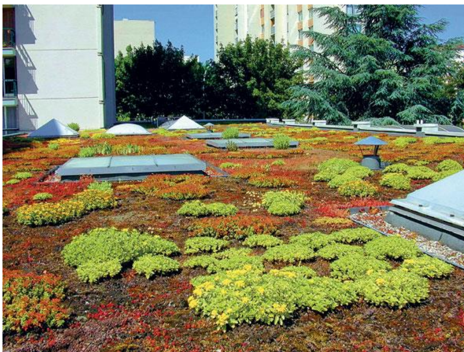
Obr. 6 Extenzivní vegetační střecha [51]
