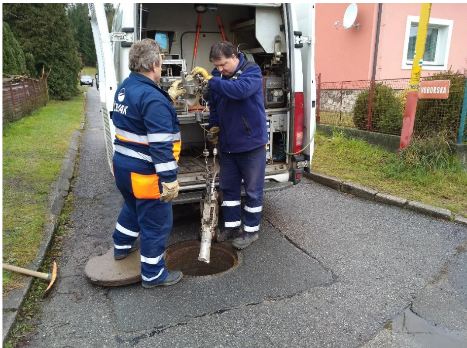
Obr. 24 Provádění kamerového průzkumu
