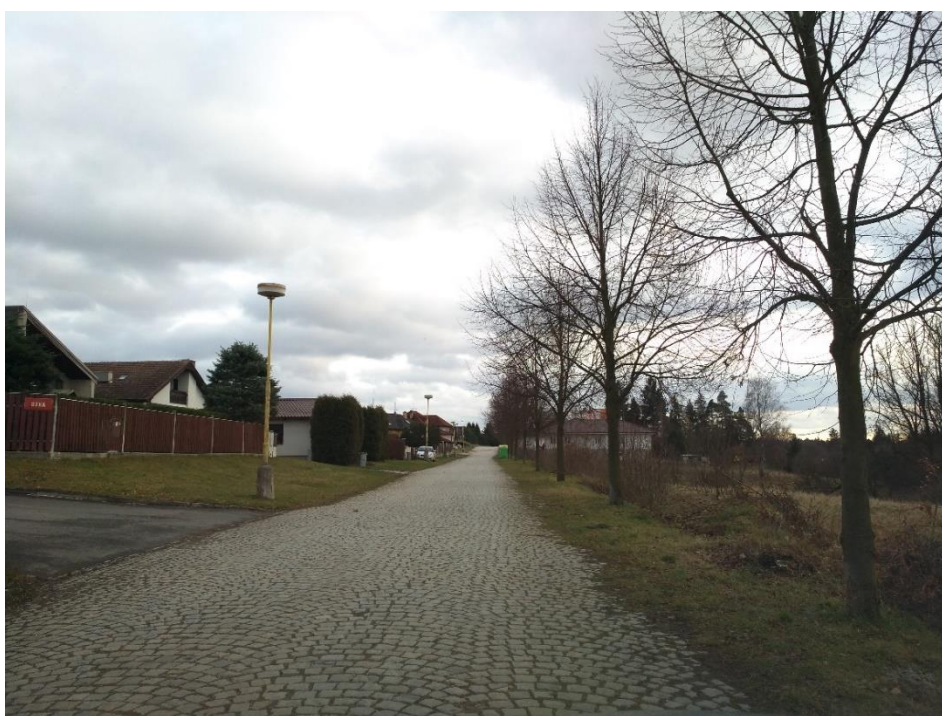
Obr. 31 Dlažební kostky v ulici Nad Hejtmanem
