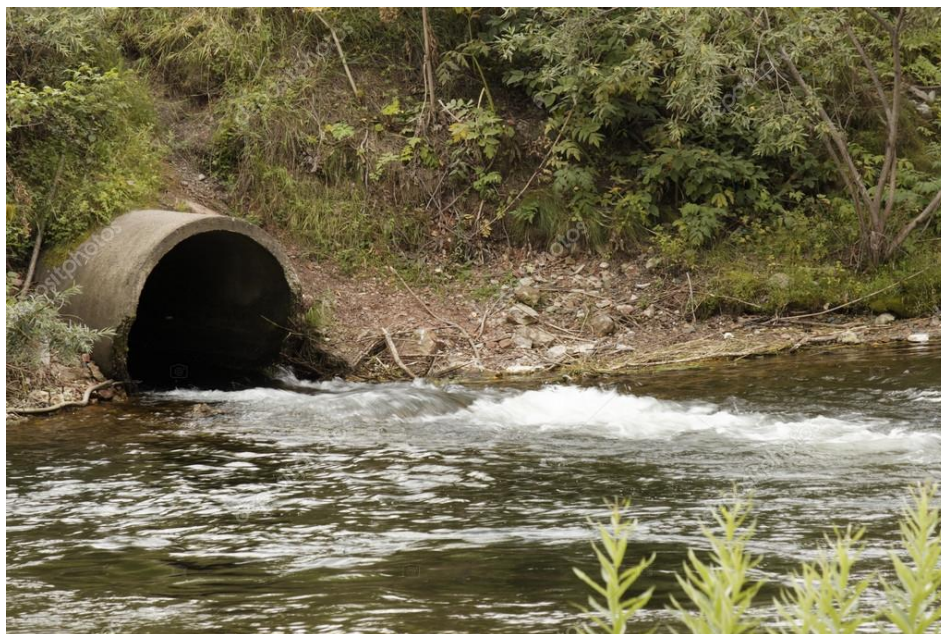
Obr. 3 Svedení dešťové vody potrubím do povrchových vod [48]
