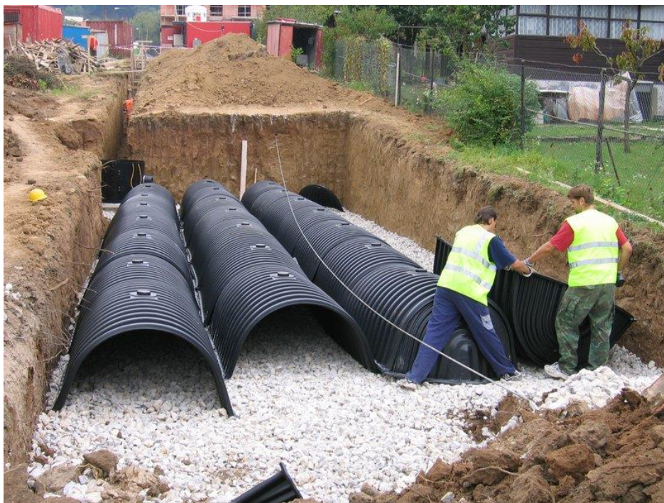
Obr. 12 Vsakovací tunel [54]
