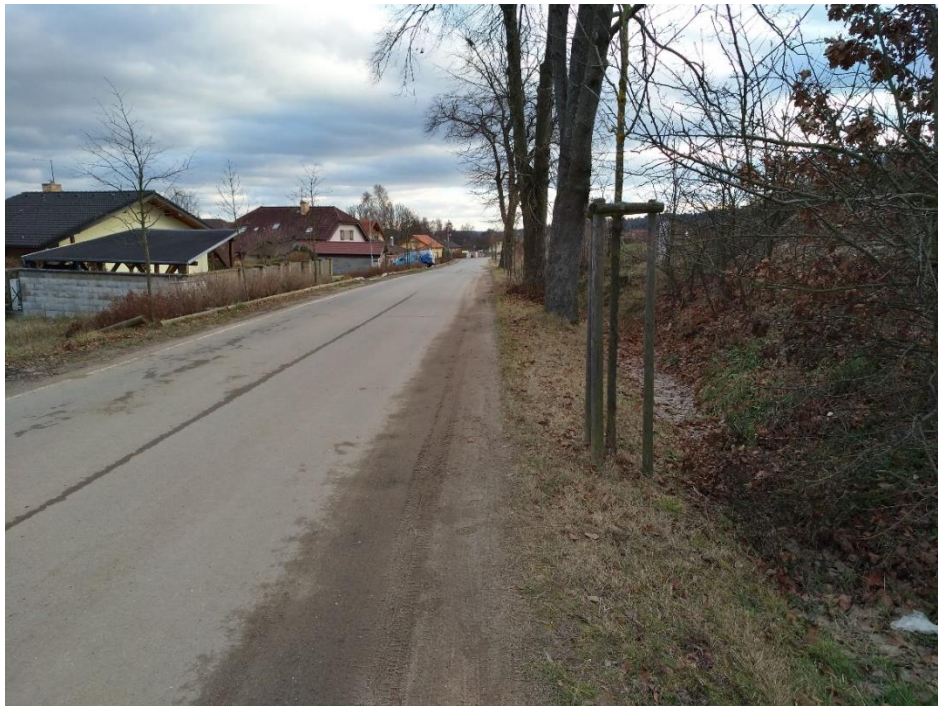
Obr. 32 Vsakovací průleh podél ulice Soukenická
