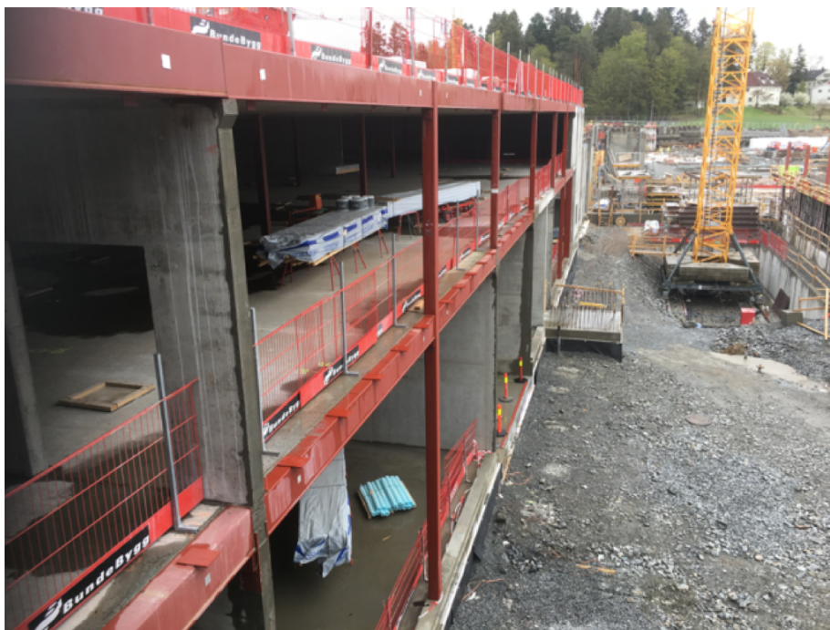
Picture 7 - proper edge protection
