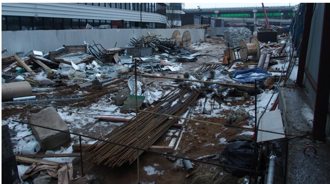
Obrázek 37: Pohled na zařízení staveniště 2 [zdroj vlastní]
