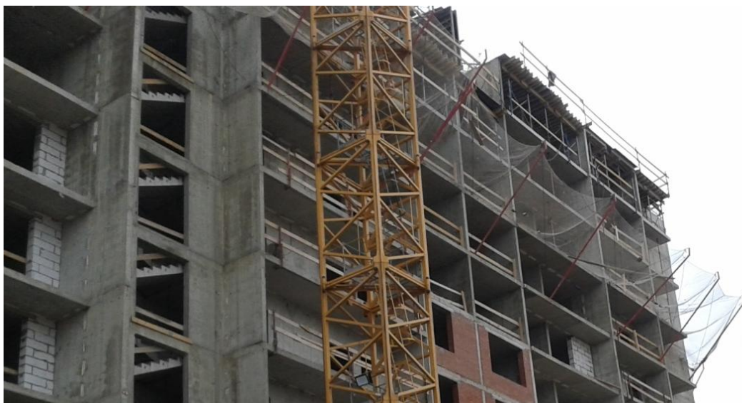
Obrázek 34: Ochranné sítě proti pádu [zdroj vlastní]
