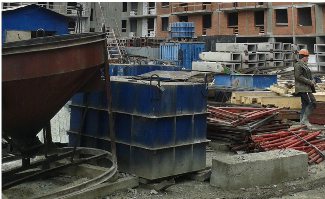
Obrázek 36: Pohled na zařízení staveniště 1 [zdroj vlastní]
