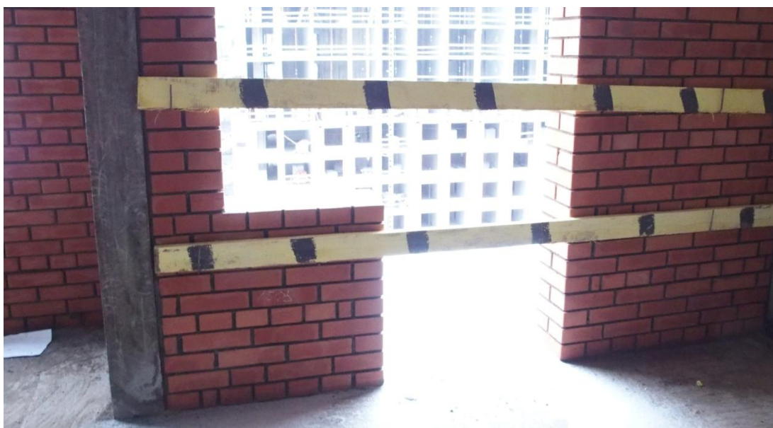
Obrázek 29: Zajištění hrany pádu 2[zdroj vlastní]
