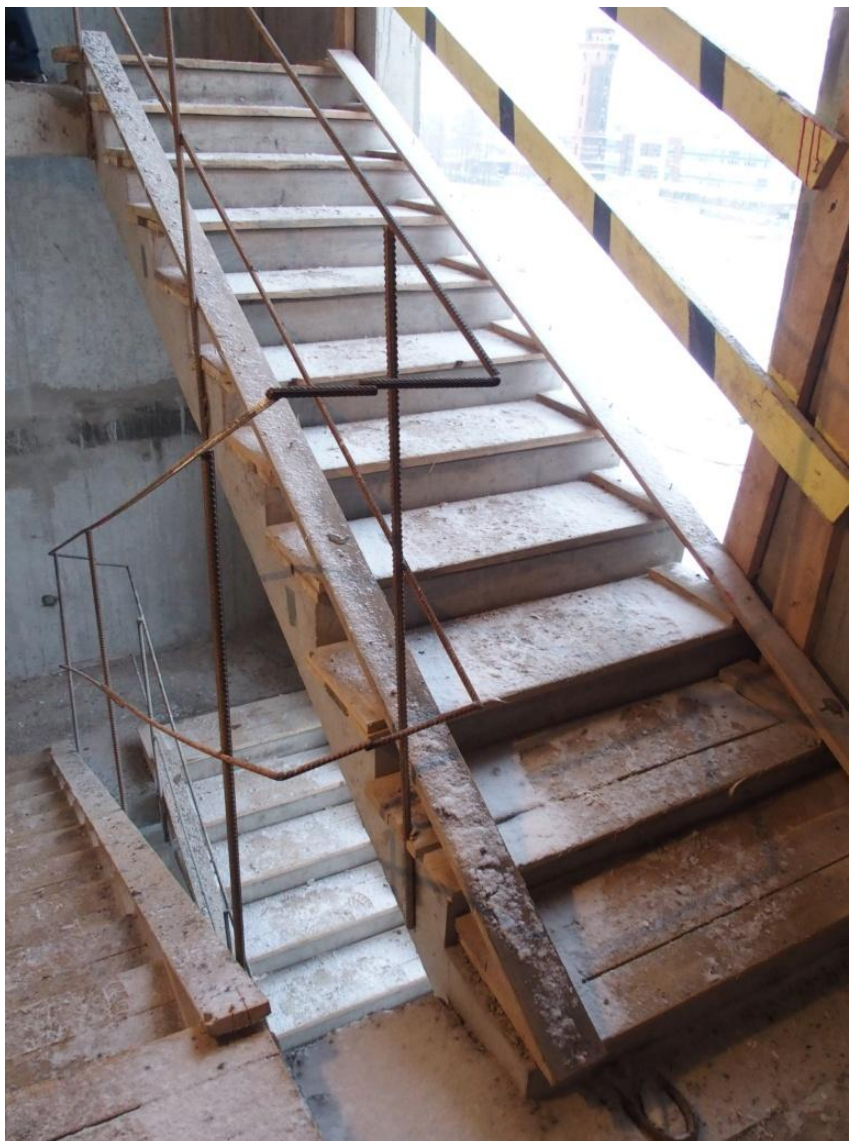
Obrázek 27: Schodiště [zdroj vlastní]
