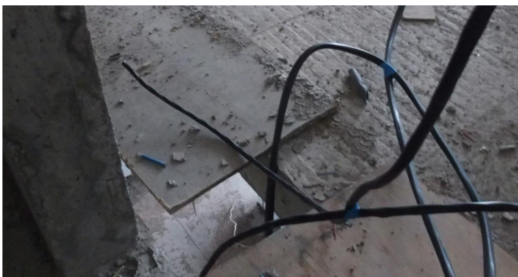
Obrázek 31: Zakrytí otvoru v podlaze [zdroj vlastní]
