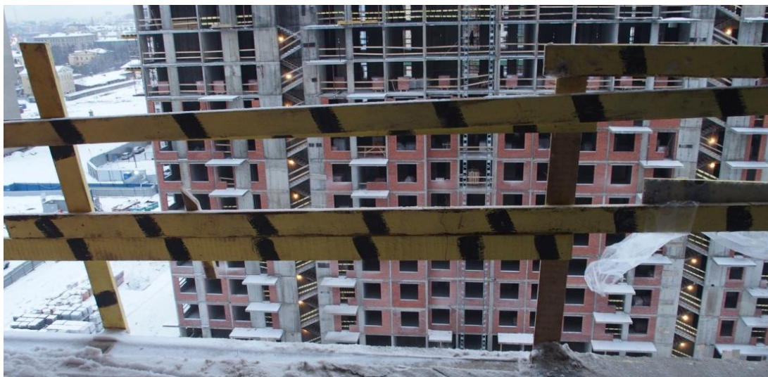
Obrázek 28: Zajištění hrany pádu [zdroj vlastní]
