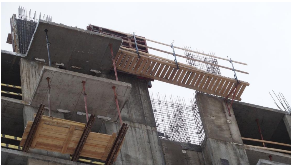
Obrázek 32: Přechodový můstek [zdroj vlastní]
