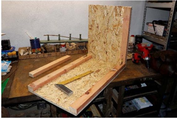
Montáž nosné konstrukce
