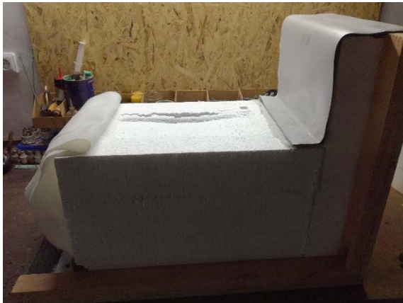
Skladba č. 1: Odstraněná PVC fólie s geotextílií
