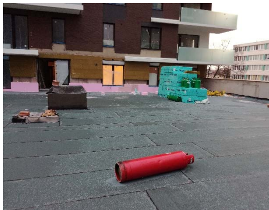
Obr. 1: V pozadí skládka tepelné izolace z minerální vlny, v popředí PB láhev (zdroj autor)
