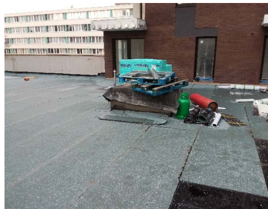
Obr. 2: Skladování materiálu při realizaci střešního pláště (zdroj autor)
