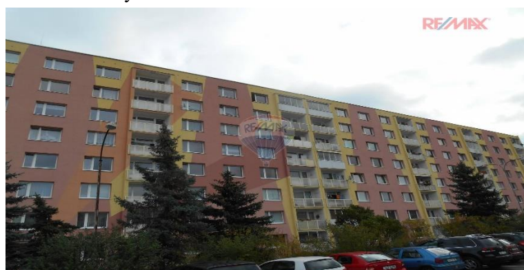
Obrázek 15 Bytový dům bytu v Chomutově, zdroj viz inzerát – Příloha č. 8
