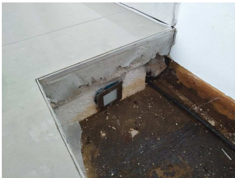
Obrázek 22 Řez podlahou ve vzorovém domě
