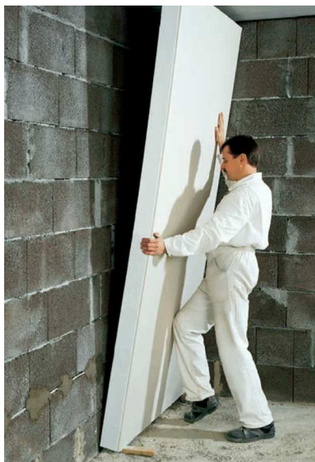
Obrázek 17 Montáž panelů Rigitherm (převzato z profi.rigips.cz )
