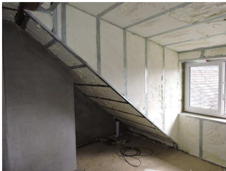
Obrázek 8 Měkká PUR pěna - izolace podkroví (převzato z www.pur.cz )
