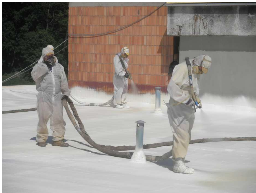
Obrázek 9 Aplikace tvrdé PUR pěny (převzato z www.ceskestavby.cz )
