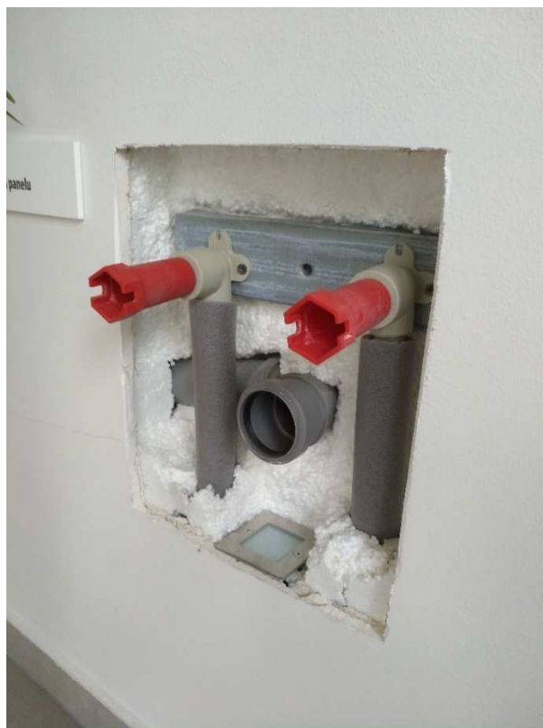
Obrázek 23 Vedení instalací v tepelném izolantu
