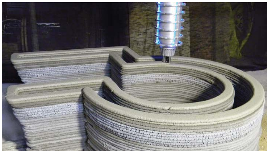
Obr. 8: 3D tisk betonové konstrukce (Převzato z: http://www.totalkustom.com/photo.html )
