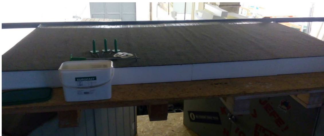
Obrázek 64 - Pokládka samolepícího asfaltového pásu
