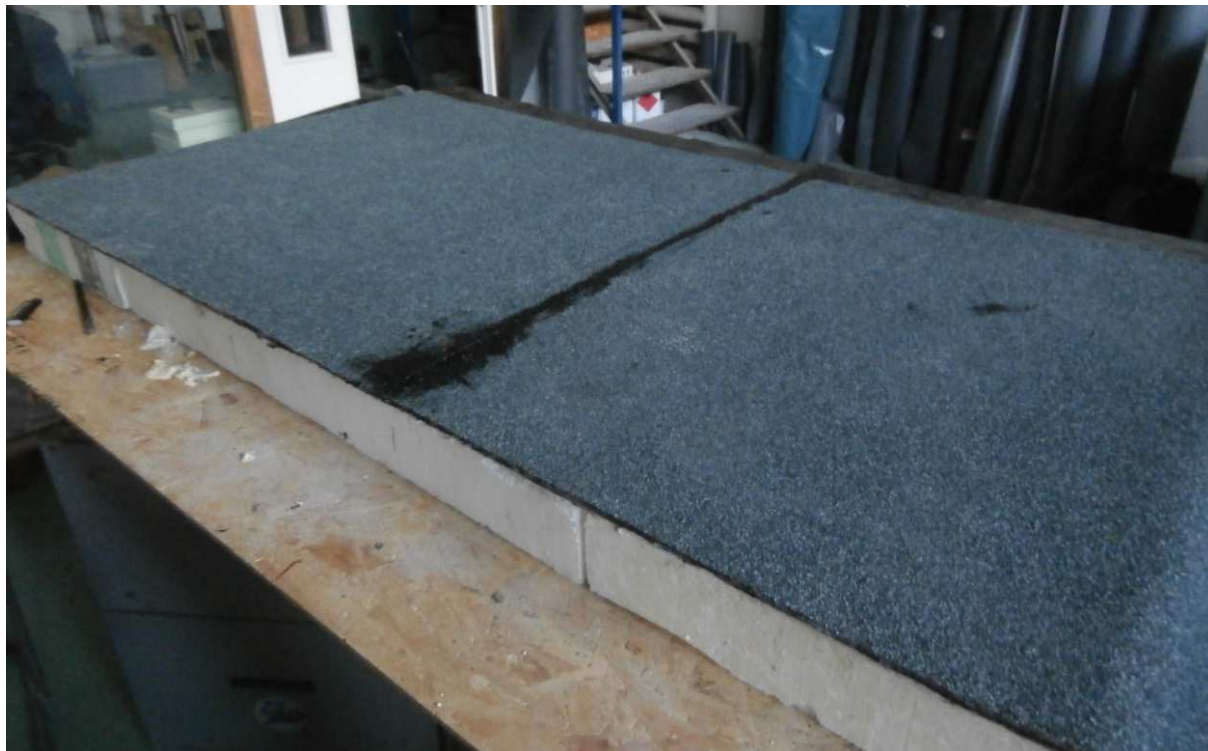
Obrázek 68 - Natavení vrchního asfaltového pásu
