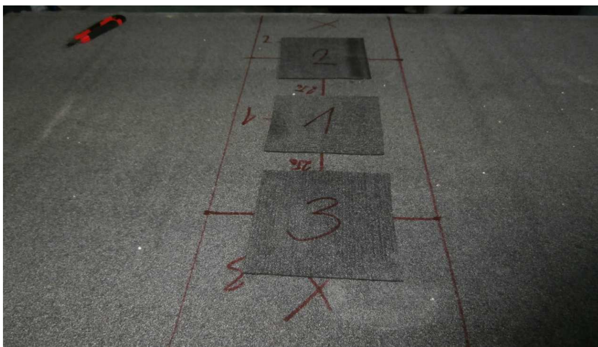
Obrázek 67 - Překrytí hlav teleskopických podložek přířezy asfaltového pásu
