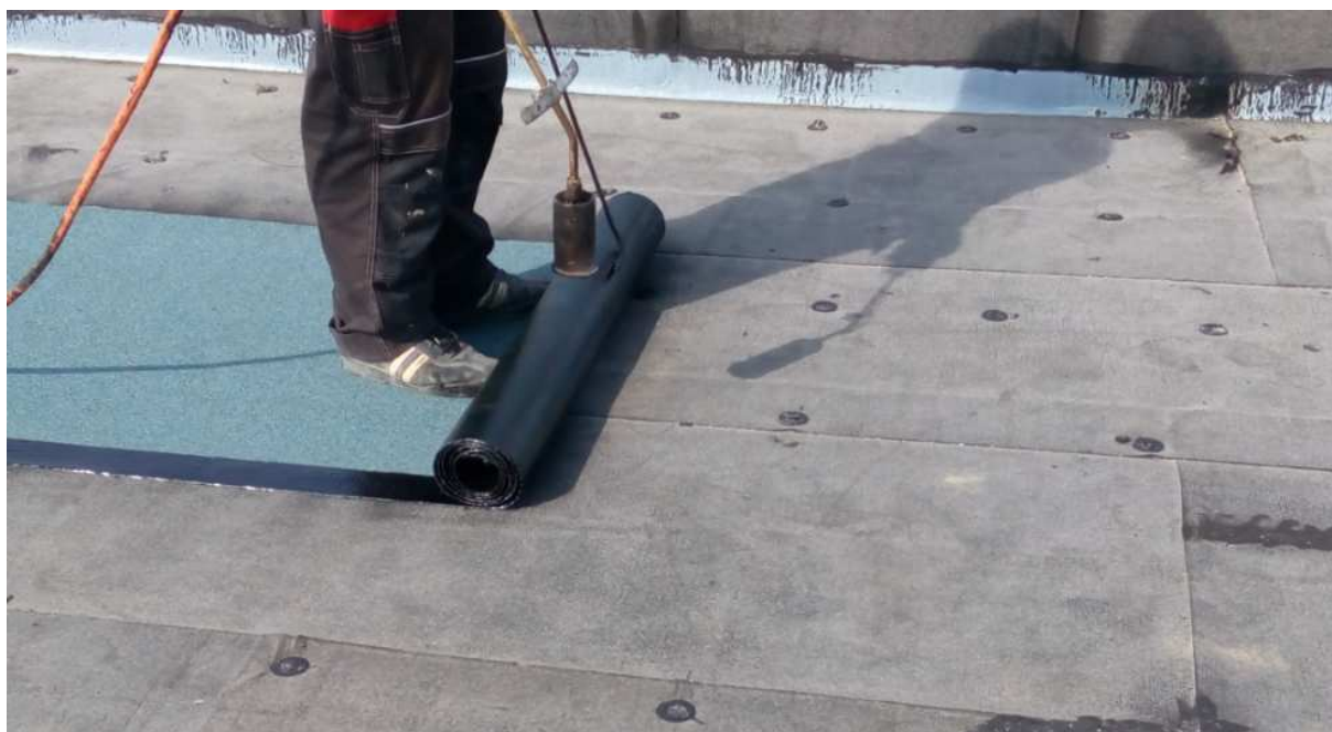
Obrázek 18 – Realizace hydroizolačního souvrství z asfaltových pásů
