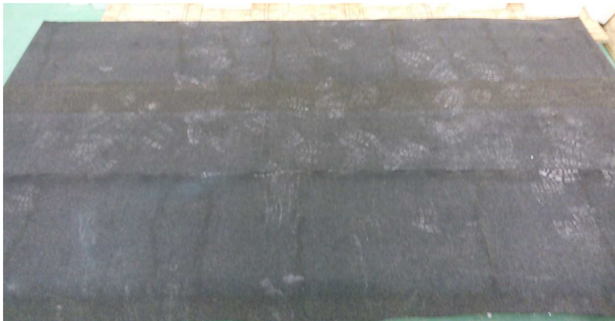
Obrázek 51 - Aplikace SBS modifikovaného samolepícího pásu
