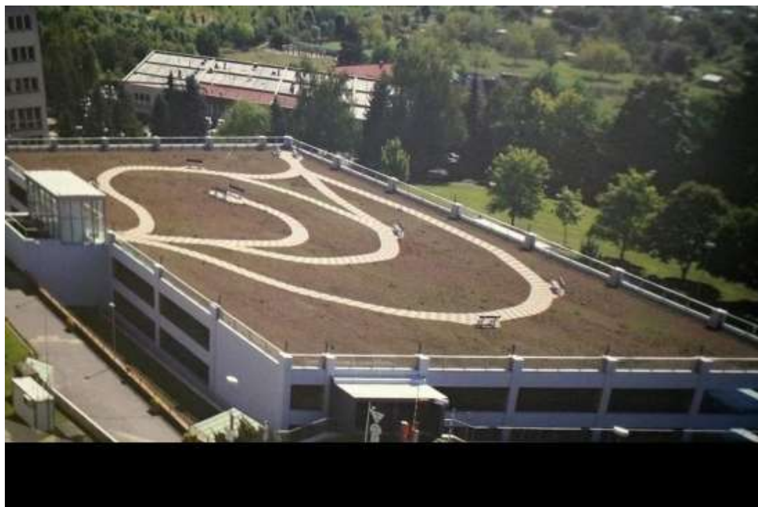
Obrázek 19 Dokončený objekt Zdroj [2]
