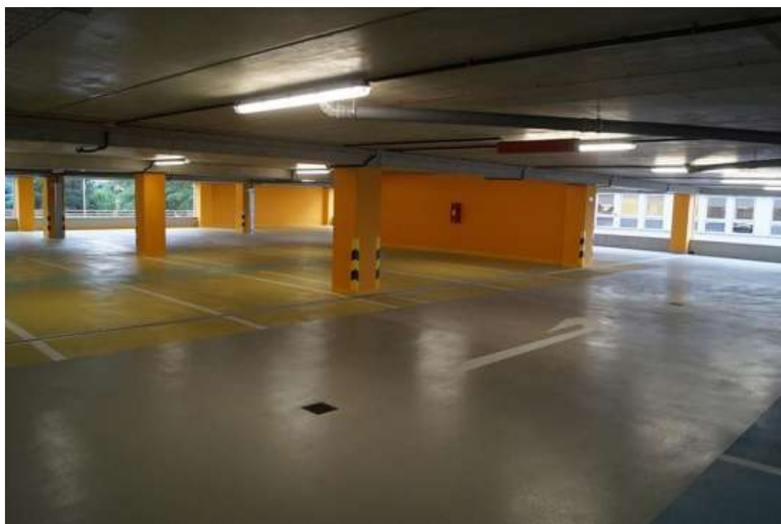
Obrázek 23 Dokončený objekt Zdroj [2]
