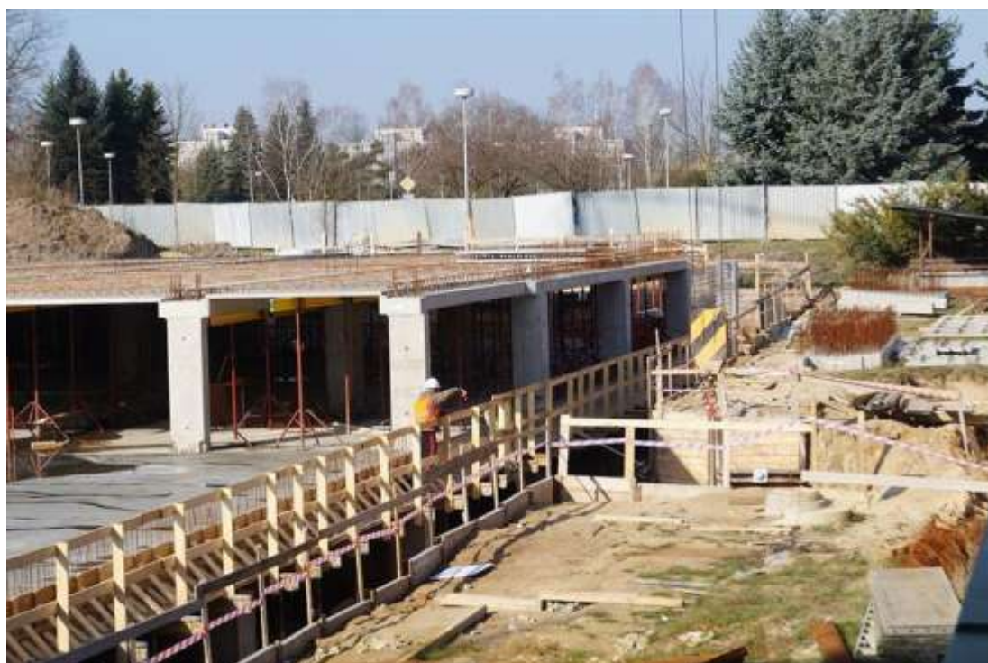
Obrázek 8 Výstavba Parkovacího domu Zdroj [2]
