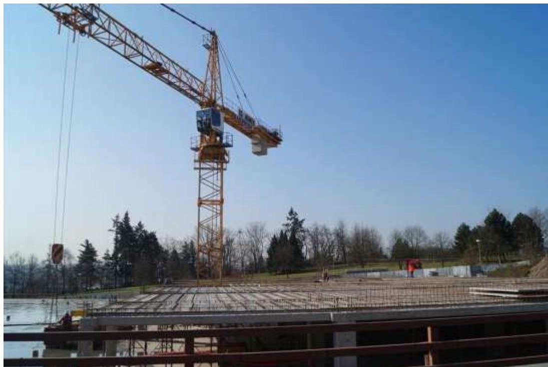
Obrázek 3 Osazování stropních panelů Zdroj [2]
