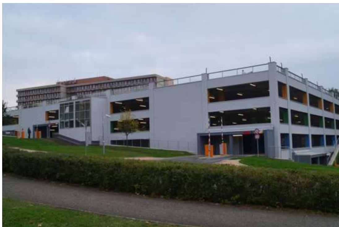
Obrázek 14 Dokončený objekt Zdroj [2]
