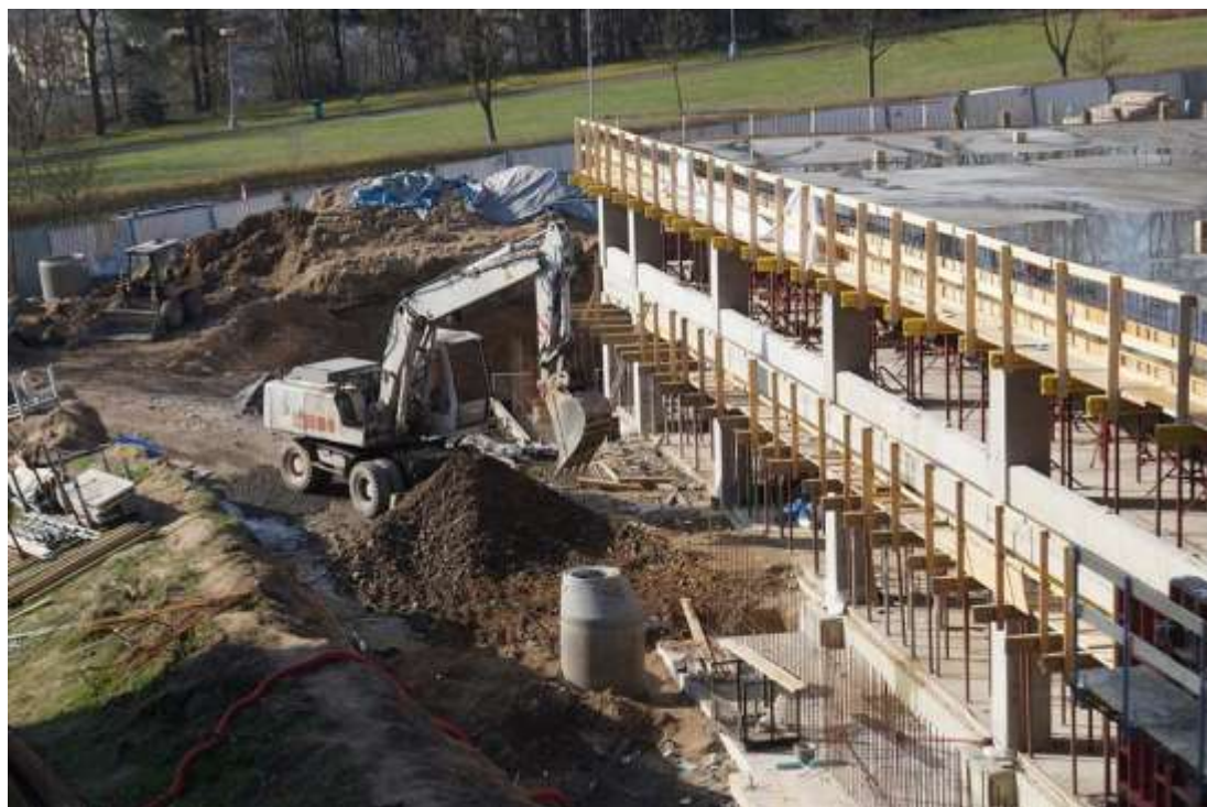
Obrázek 5 Výstavba Parkovacího domu Zdroj [2]
