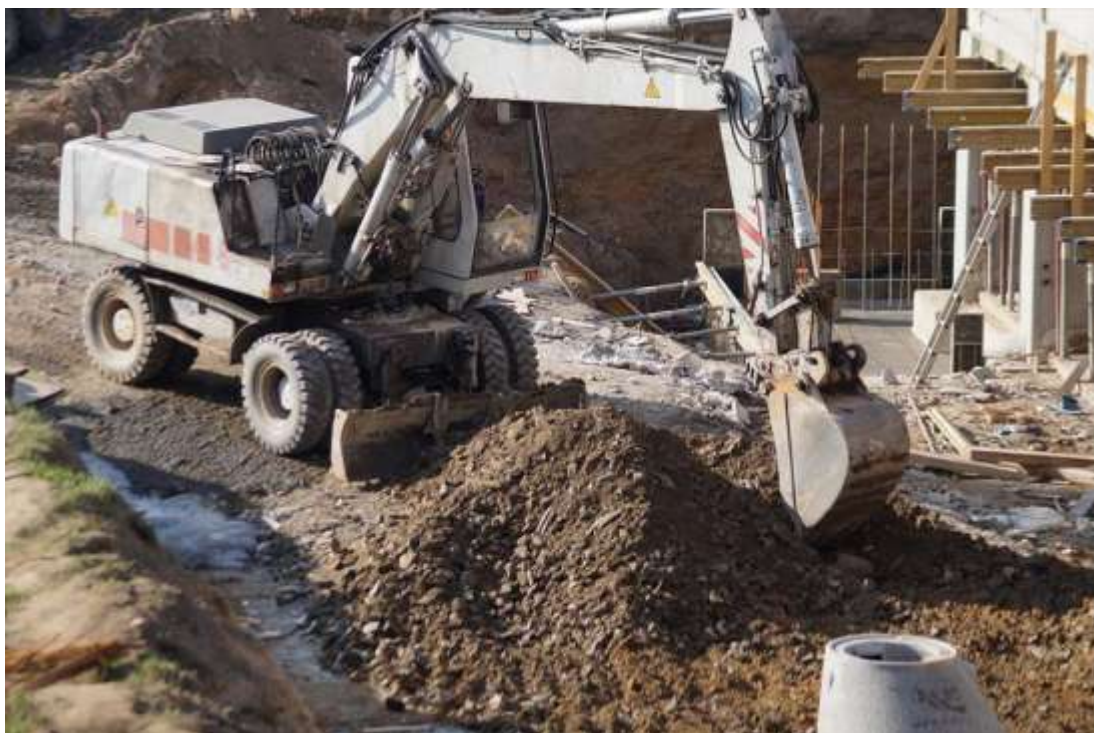
Obrázek 11 Výstavba Parkovacího domu Zdroj [2]
