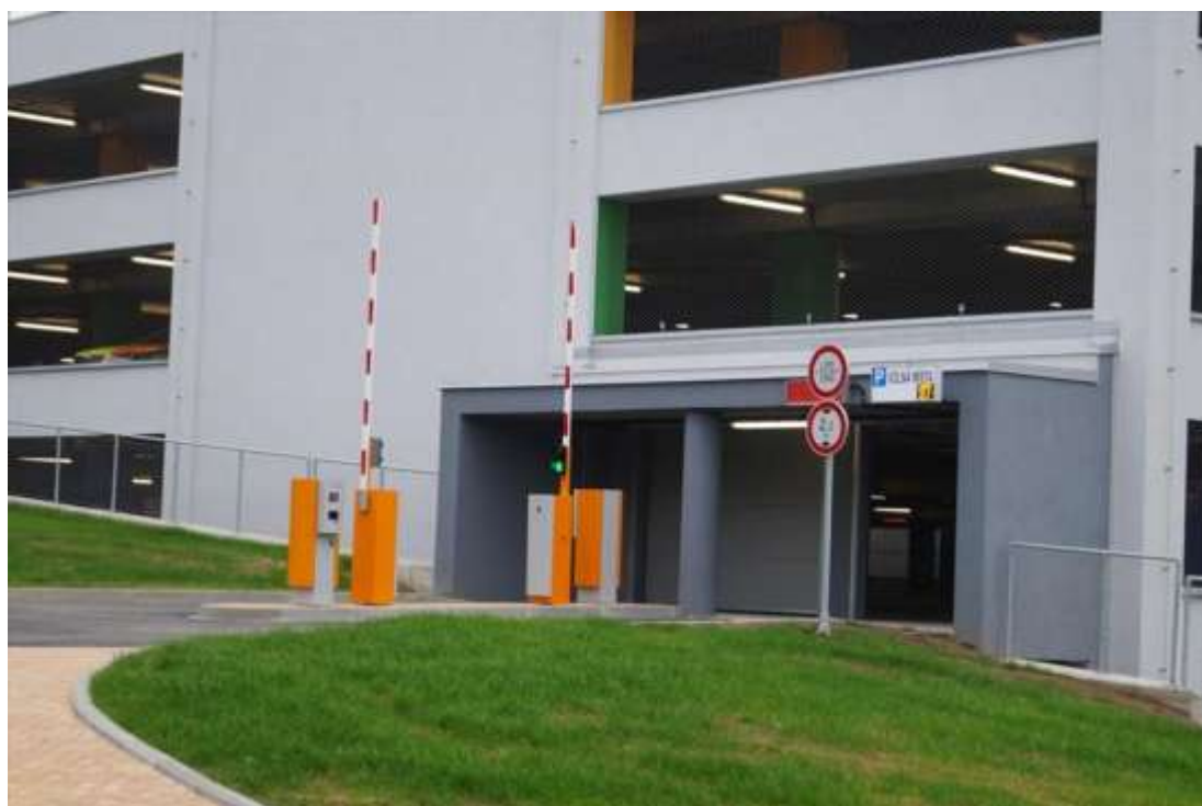
Obrázek 16 Dokončený objekt Zdroj [2]
