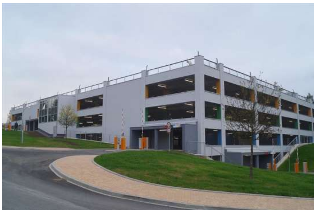
Obrázek 15 Dokončený objekt Zdroj [2]
