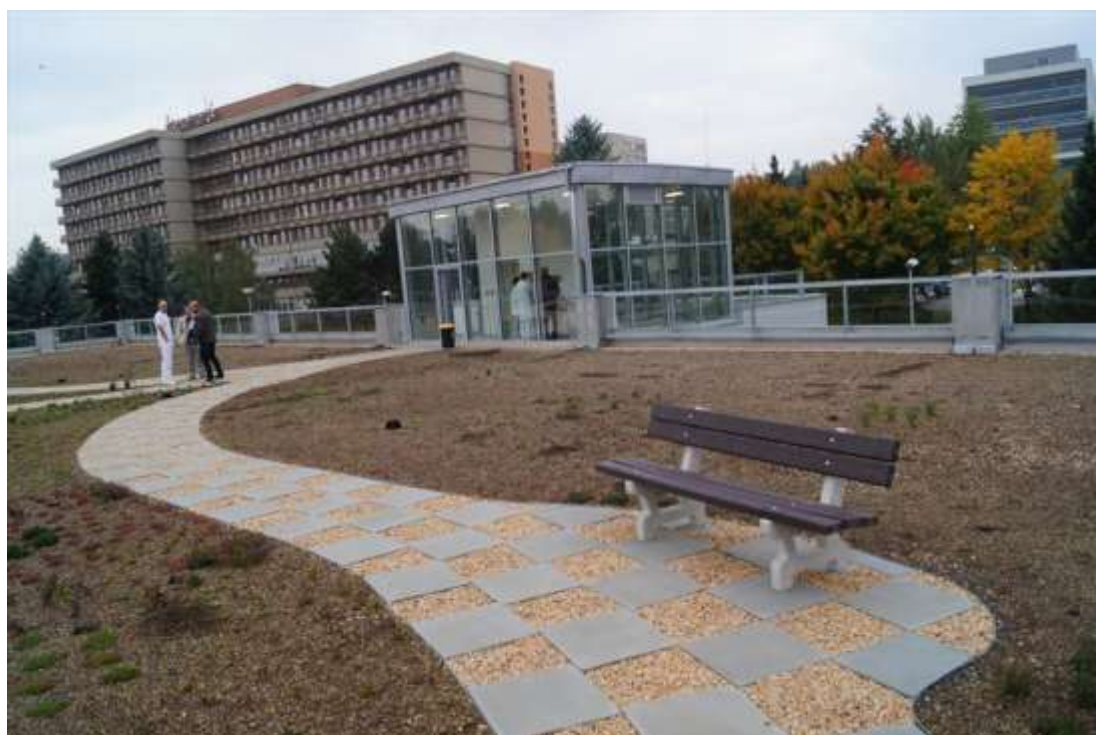
Obrázek 20 Dokončený objekt Zdroj [2]
