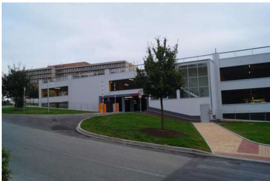
Obrázek 18 Dokončený objekt Zdroj [2]
