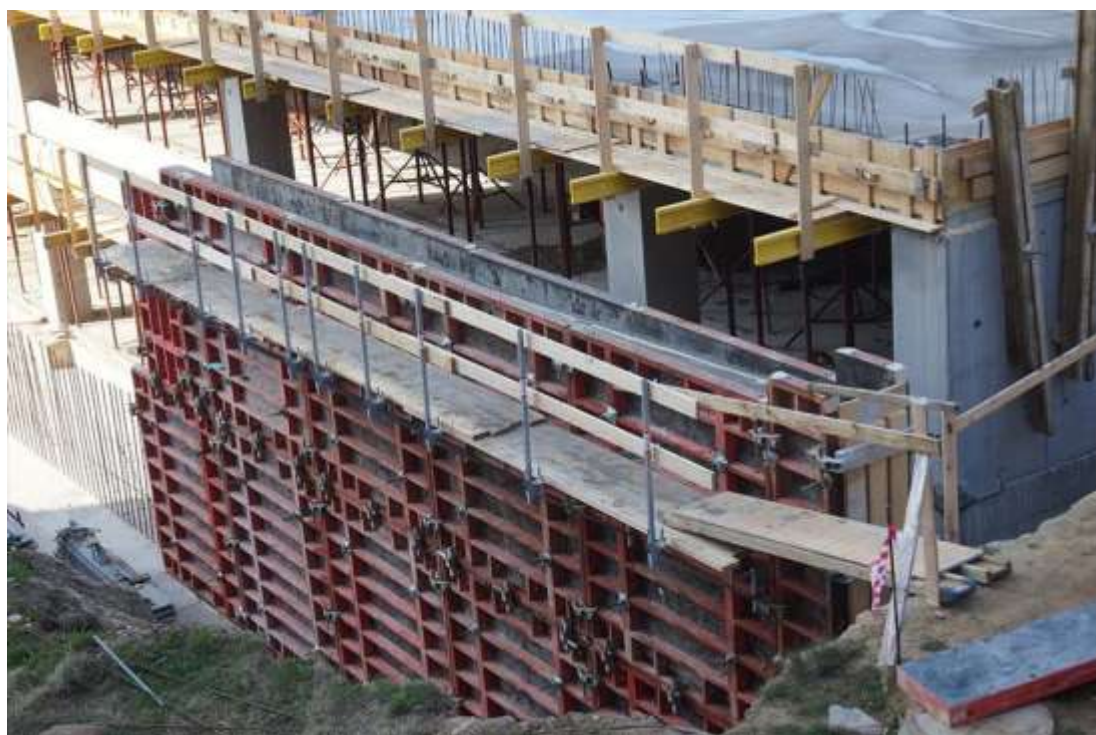
Obrázek 9 Výstavba Parkovacího domu Zdroj [2]
