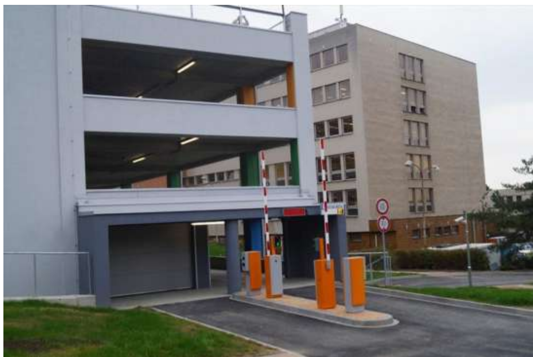
Obrázek 17 Dokončený objekt Zdroj [2]
