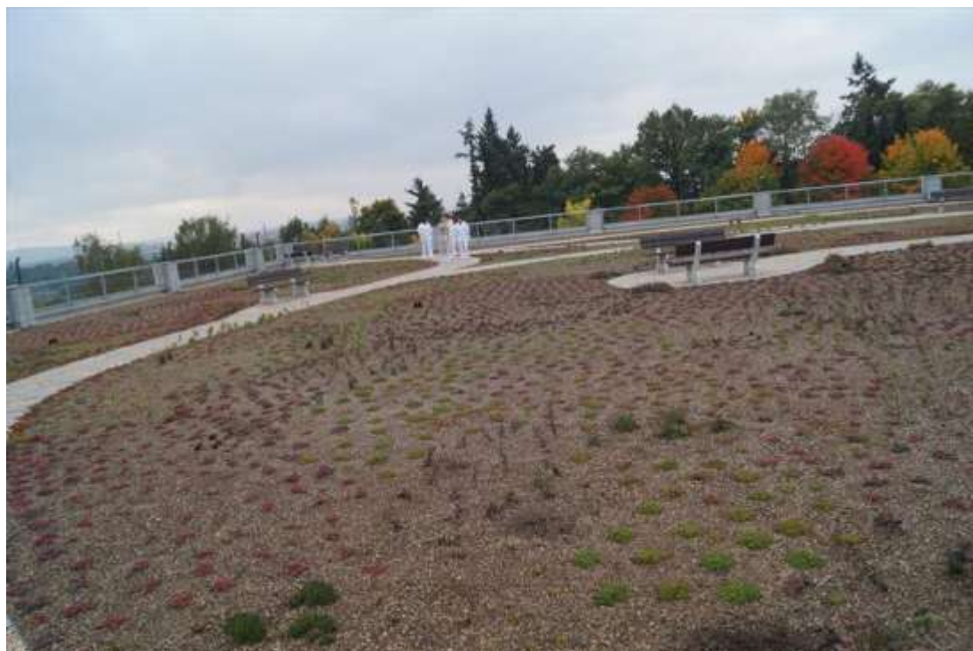
Obrázek 21 Dokončený objekt Zdroj [2]
