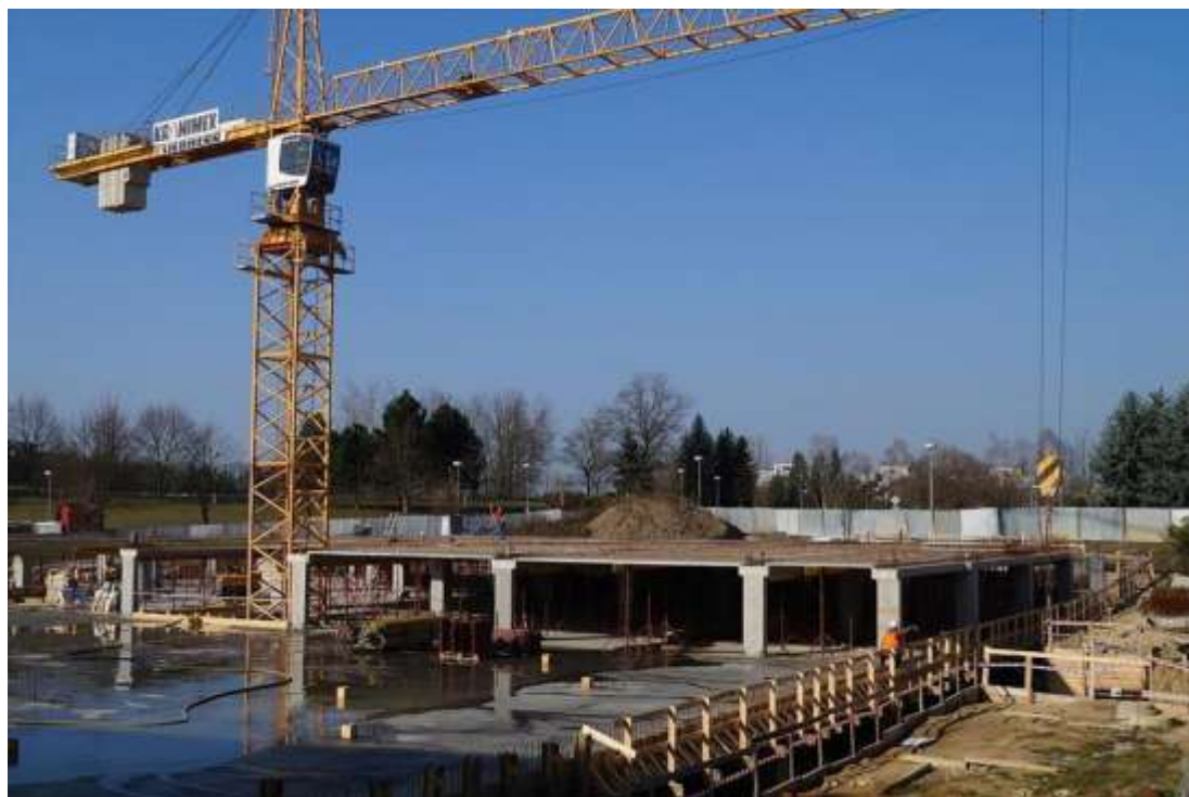
Obrázek 6 Výstavba Parkovacího domu Zdroj [2]
