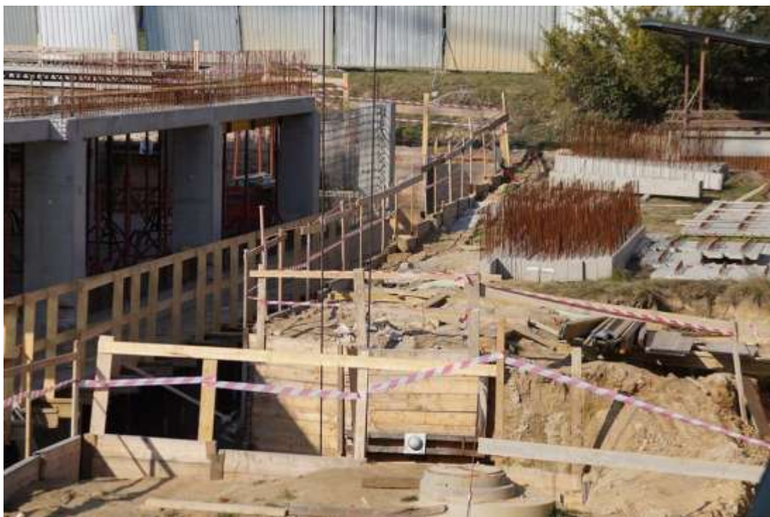
Obrázek 12 Výstavba Parkovacího domu Zdroj [2]
