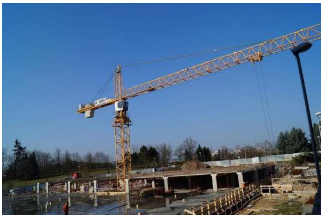
Obrázek 7 Výstavba Parkovacího domu Zdroj [2]
