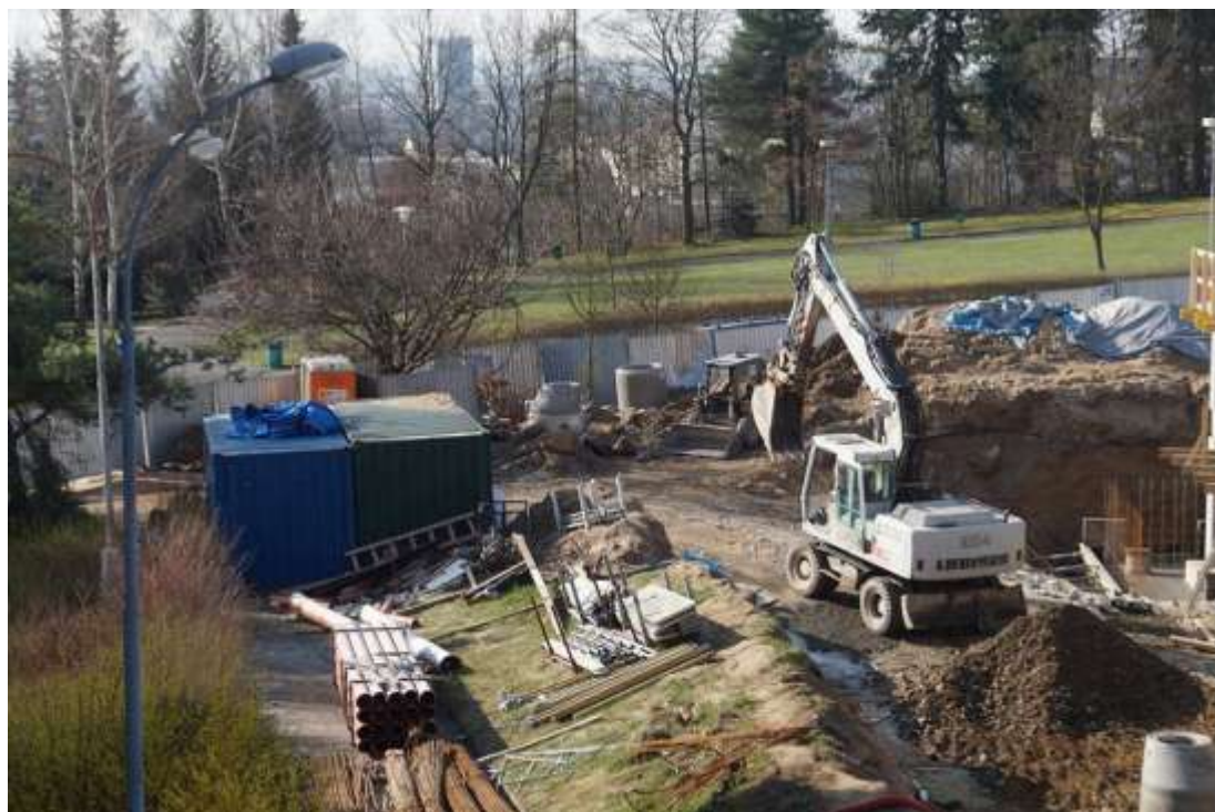
Obrázek 10 Výstavba Parkovacího domu Zdroj [2]
