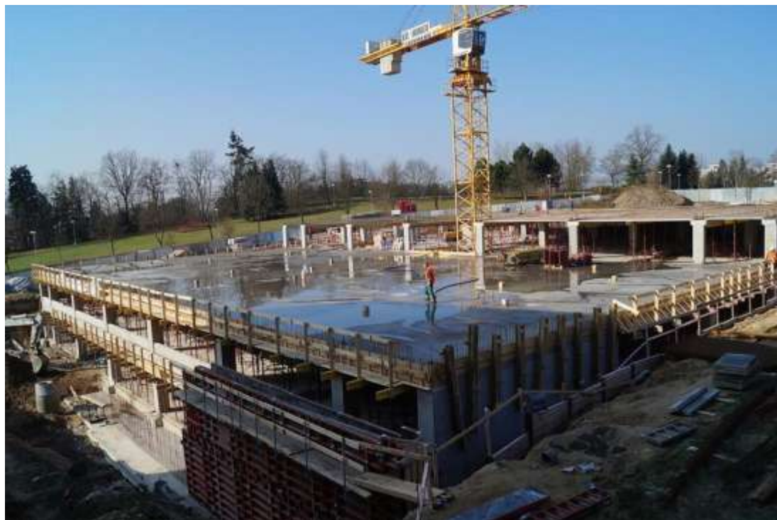
Obrázek 4 Výstavba Parkovacího domu Zdroj [2]
