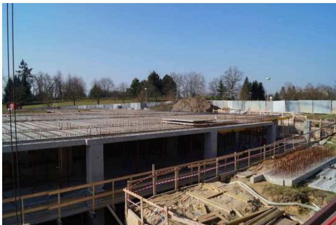
Obrázek 13 Výstavba Parkovacího domu Zdroj [2]
