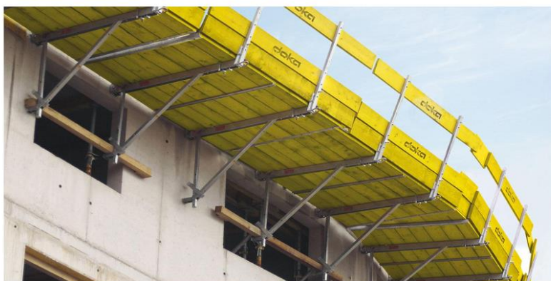
Obrázek č. 4: Systémy pracovních plošin od společnosti Doka
