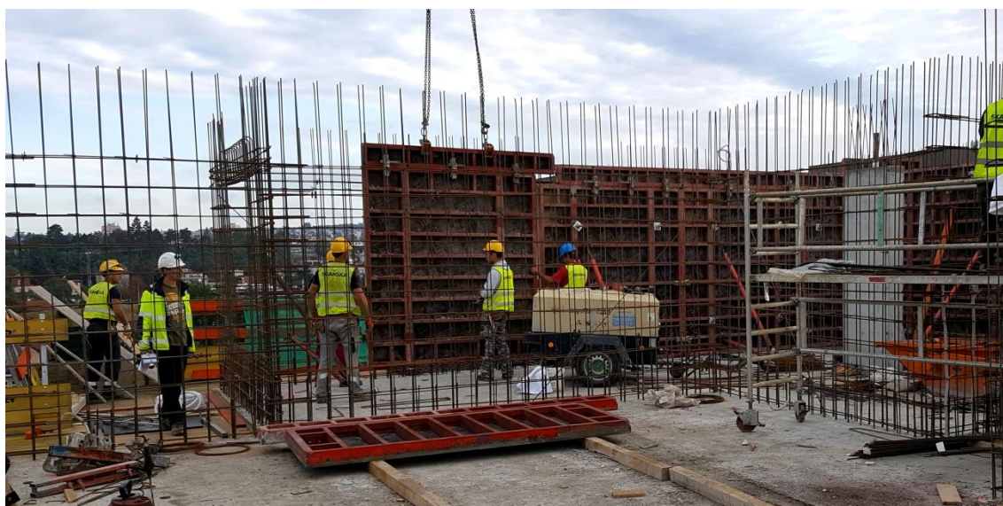
Obrázek č. 6: Ukládání bednění na předem vyvázanou armaturu - první varianta
