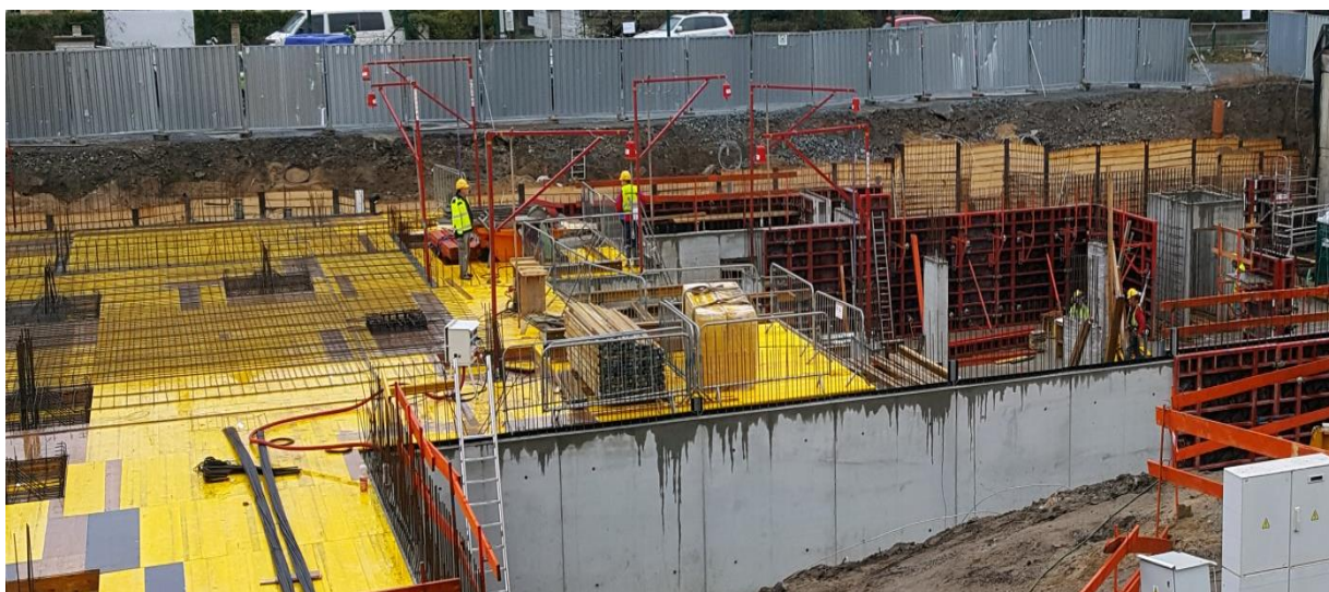
Obrázek č. 10: Ukázka realizace monolitické konstrukce „do schodu“
