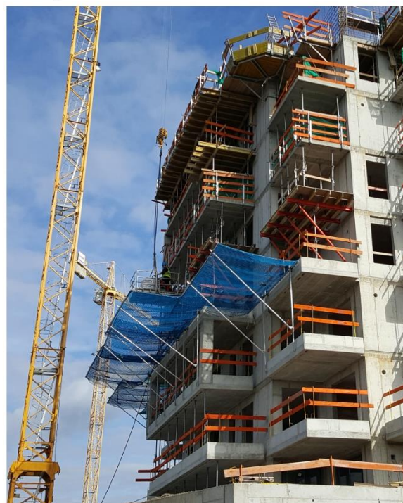
Obrázek č. 5: Záchytné systémy na stavbě Neoriviera v Modřanech
