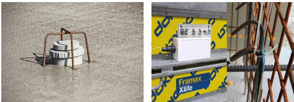
Obrázek č. 7: Senzory Concremote (vlevo pro vodorovné a vpravo pro svislé konstrukce)
