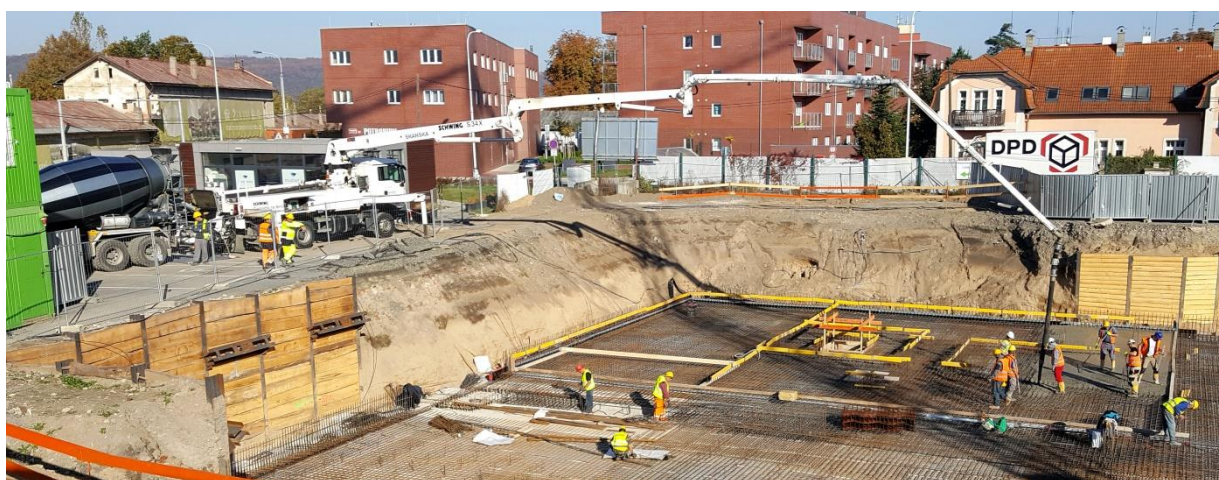
Obrázek č. 9: Použití mobilního čerpadla Schwing S34X při betonáži základové desky
