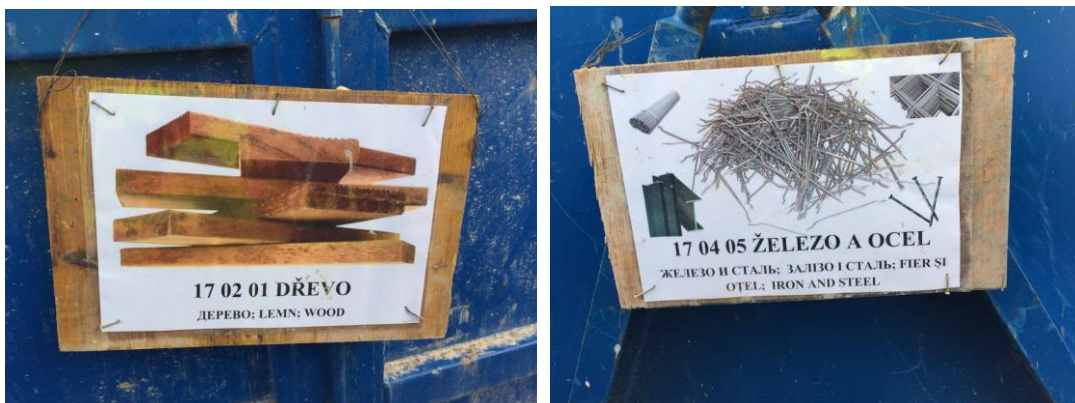
Obrázek 5a, 5b – Ukázka vhodného označování odpadových kontejnerů [Zdroj: vlastní]
