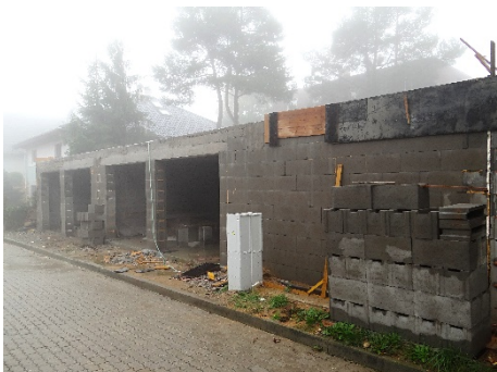
Obrázek 19 – Garáž, Brno – Útěchov
