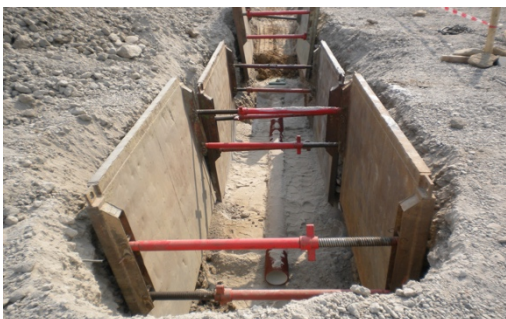
Obr. 66 – Realizace připojovacího potrubí splaškové kanalizace za chladicími věžemi; i zde byly prostorové podmínky příznivé
