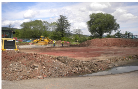
Obr. 58 – Úprava pláně plochy ZS v prostoru za chladicími věžemi v návaznosti na obr. 56 a 57; lze potvrdit příznivé podmínky pro realizaci ZS
