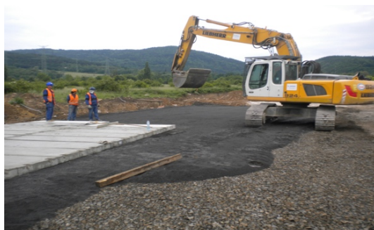
Obr. 63 – Pokládání panelů na připravené podloží pro buňkovou sestavu ZS (ná vaznost na obr. 64 a 65)
