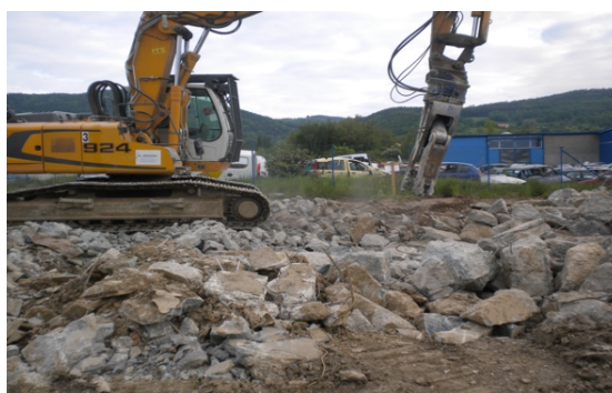
Obr. 59 - Rozbívění a drcení vytěžených beton bloků v ploše ZS za chladicími věžemi; v návaznosti na předchozí obr. 57 – 58 bylo možné provést rozbíjení a drcení
