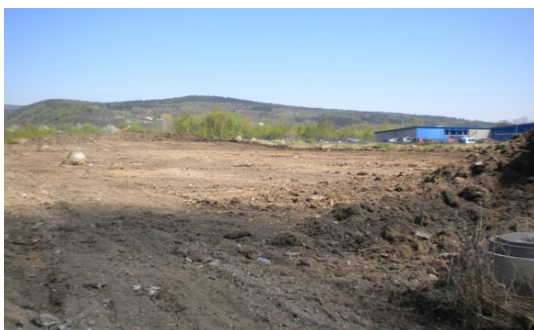
Obr. 56 – Sejmутí ornice před vybudováním ZS v prostoru za chladicími věžemi; prostorové podmínky areálu EPR byly v tomto případě velice příznivé
