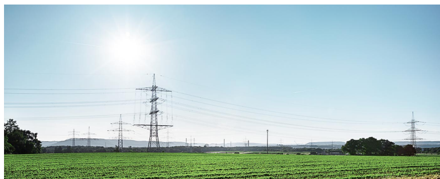
Obr. 11 – Stožárová nadzemní vedení elektrické energie [60]; veliké riziko havárií plus nelogicky tolerované poškození vzhledu krajiny
