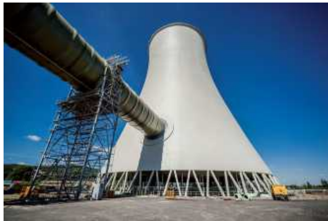
Obr. 51 – Chladicí věž s přívodem chladicí vody s užitím potrubního mostu (viz Příloha č. 19 )
