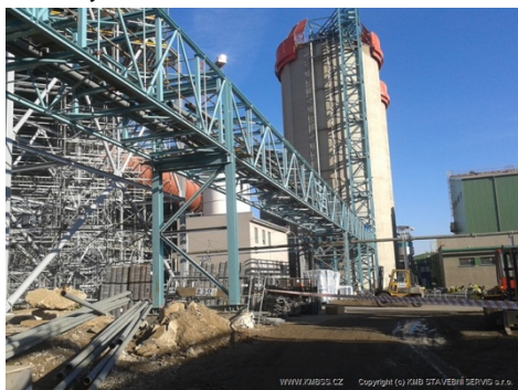
Obr. 46 – Záběr prokazující uplatnění různých typů ukládání VTTV vč. různých typů sružených tras VTTV
