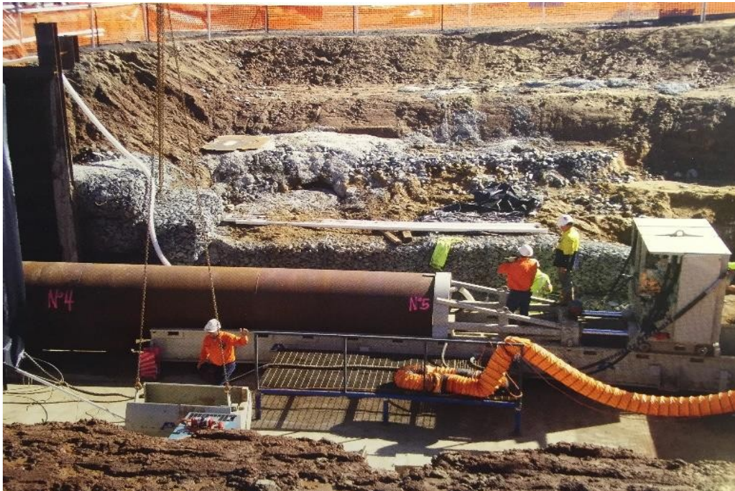
Obr. 24 – Technologie prostého štítování, příklad BT C.3/S1 [69]
