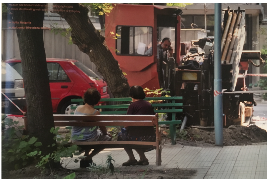
Obr. 72 – ZS při uplatnění BT; při aplikacích BT zůstává k dispozici veřejný prostor ve větším rozsahu než v případě užití klasické výkopové technologie
