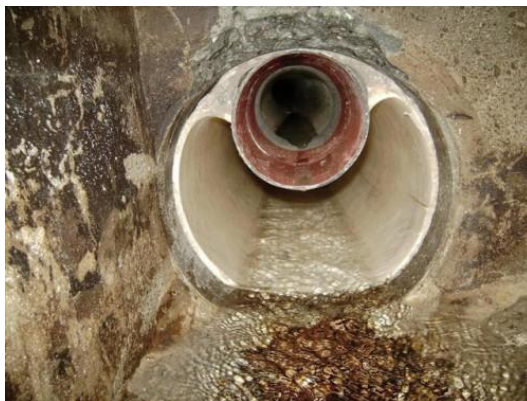
Obr. 23 - Technologie rukávcového reliningu [61]
