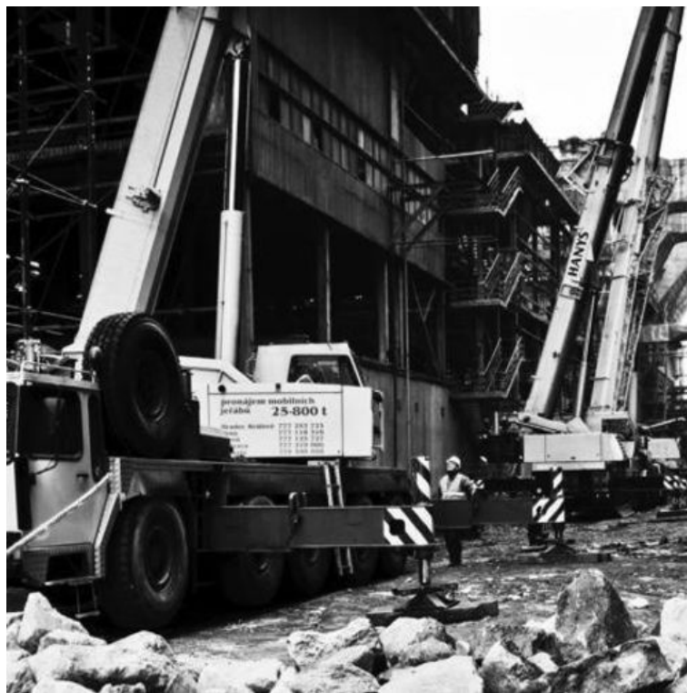
Obr. 54 – Záběr navazující na obr. 53
