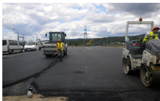
Obr. 61 – Záběr v návaznosti na obr. 60; dokončení asfaltových povrchů
