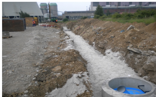
Obr. 67- Realizace připojovacího potrubí splaškové kanalizace v návaznosti na obr. 66
