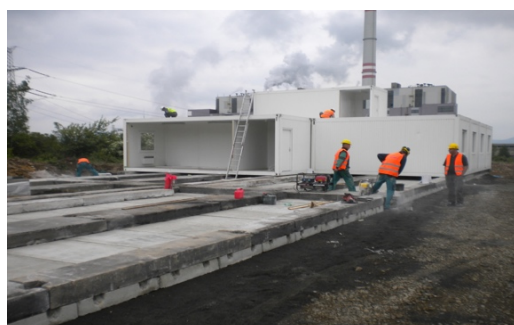
Obr. 65 - Montáž buňkové sestavy ZS na panelovou plochu
