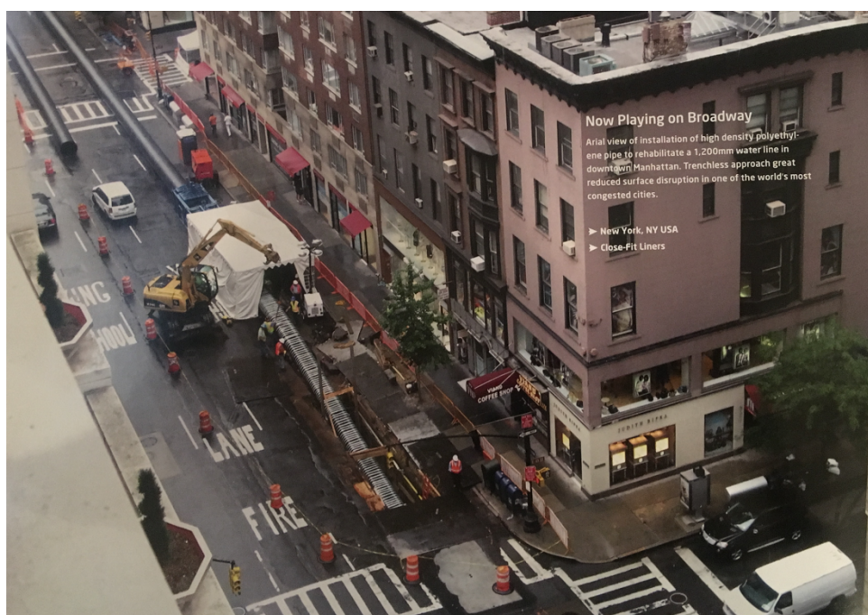
Obr. 76 – Záběr navazující na 72, 73, 74 a 75; i zde zůstal jeden jízdní pruh volný
