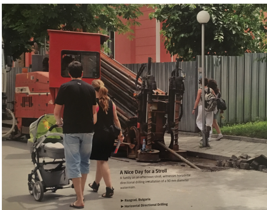
Obr. 73 – Záběr navazující na obr. 72
