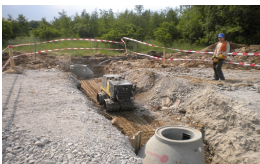
Obr. 68 – Hutnění zásypu splaškové kanalizace V návaznosti na obr 66 a 67
