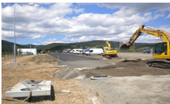
Obr. 60 – Provádění nových vnitroareálových komunikací a zpevněných ploch; i v tomto případě šlo o příznivé podmínky realizace vč. ZS
