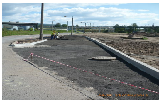
Obr. 69 - Realizace plochy pro očistu vozidel ve východní části areálu; i zde byly prostorové podmínky příznivé
