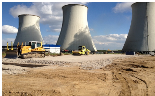
Obr. 57 – Úprava pláně plochy ZS v prostoru za chladicími věžemi v návaznosti na obr. 56
