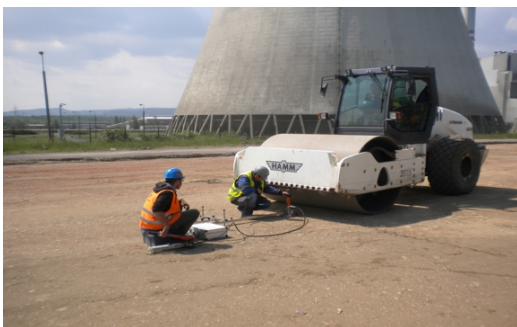
Obr. 62 – Statické zatěžovací zkoušky únosnosti podloží pro nové vnitroareálové komunikace a zpevněné plochy (ná vaznost na obr. 60 a 61)
