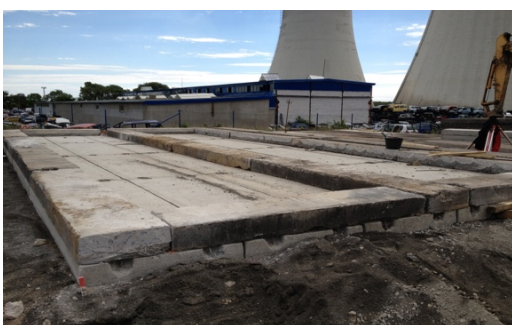
Obr. 64 – Panelová základová plocha pro objekty ZS
