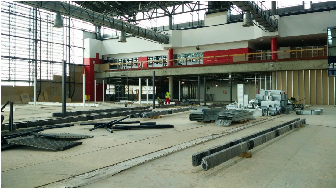
Obr. P17.5: 24. 5. 2017 – 13. týden – Montáž svislé nosné konstrukce pergoly. (Zdroj: archiv autora)
