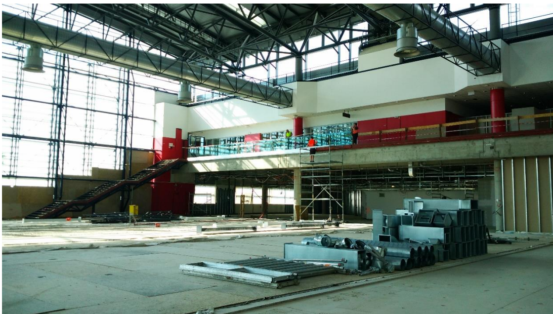
Obr. P17.4: 17. 5. 2017 – 12. týden – Začala demontáž schodiště a bourací práce na galerii. (Zdroj: archiv autora)
