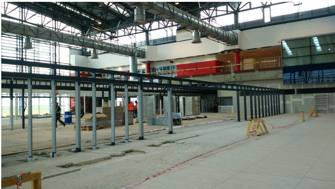
Obr. P17.7: 9. 8. 2017 – 24. týden – Dokončená nosná konstrukce prosklené příčky P13. (Zdroj: archiv autora)
