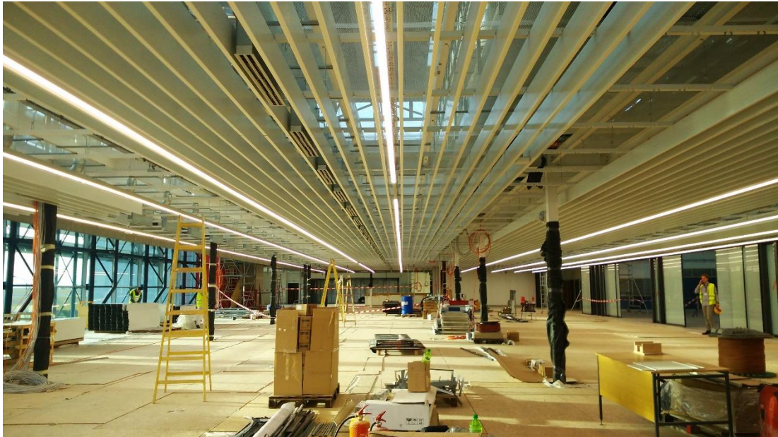
Obr. P17.13: 22. 11. 2017 – 39. týden – Zkouška osvětlení. (Zdroj: archiv autora)
