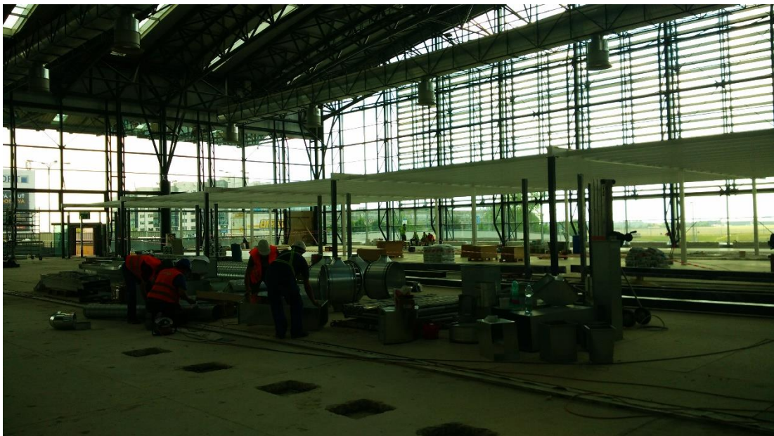
Obr. P17.6: 14. 6. 2017 – 16. týden (1 den před původním termínem kolaudace) – Dokončená nosná konstrukce pergoly. (Zdroj: archiv autora)
