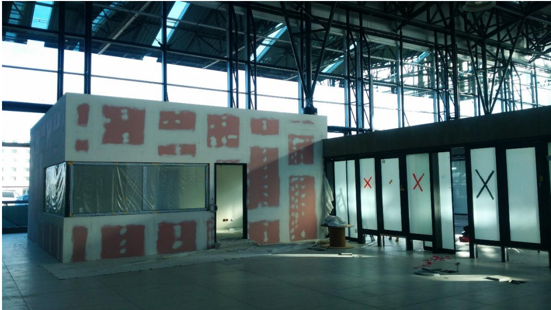
Obr. P17.9: 14. 11. 2017 – 38. týden – Dokončení prosklení přiček P13, P14 a SDK konstrukcí zázemí Policie ČR. (Zdroj: archiv autora)
