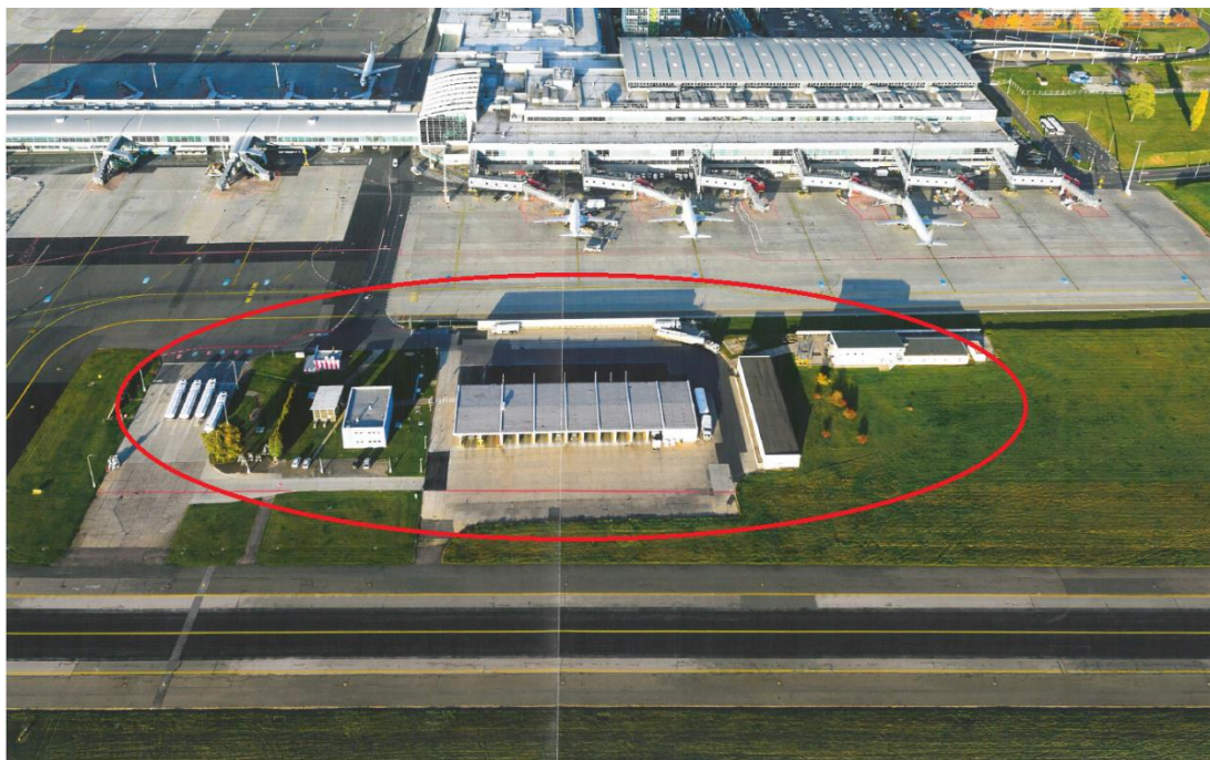
Obr. 3.1: Letecký snímek stávajícího depa autocisteren (Zdroj: interní dokumenty [redacted])
