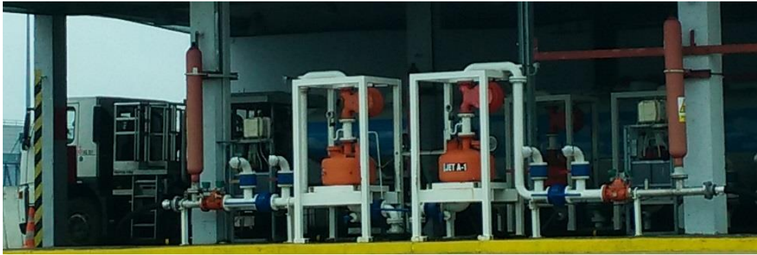
Obr. 3.2: Technologie stávajícího depa autocisteren (Zdroj: archiv autora)
