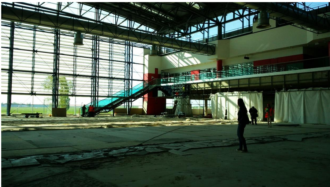
Obr. 3.7: Prostor COB 10. 5. 2017 - 2,5 měsíce po zahájení stavby (Zdroj: archiv autora)
