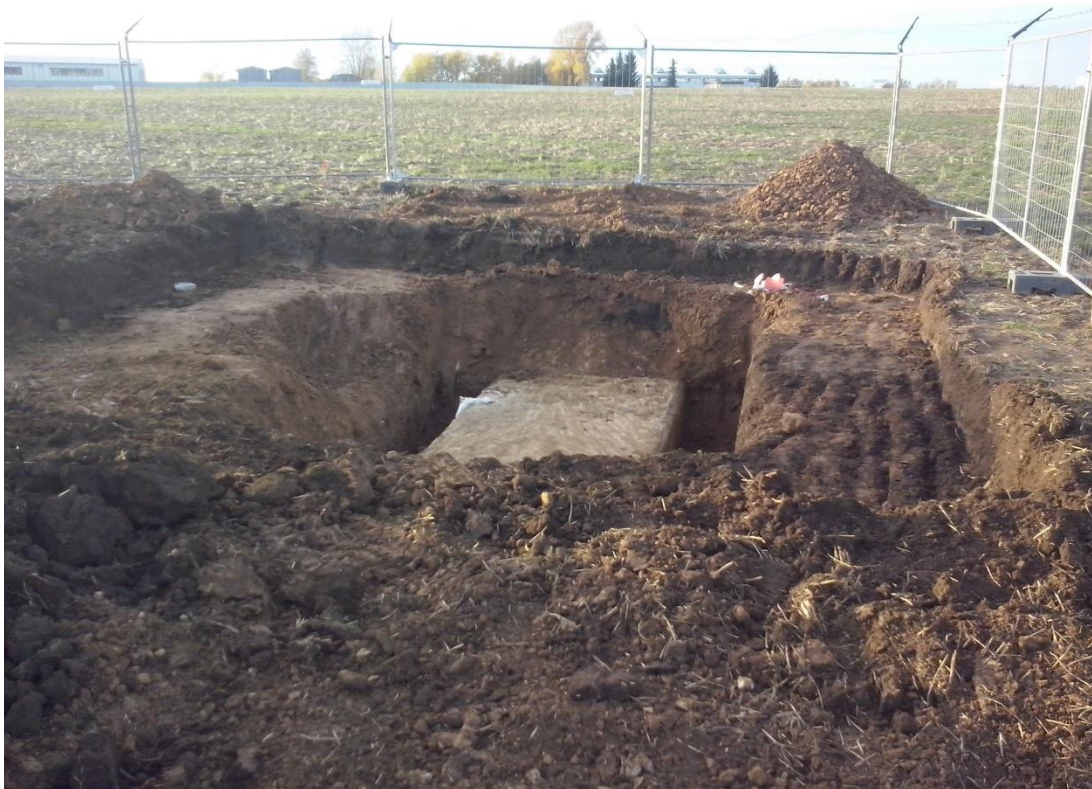
Obr. 3.10: Výstavba Šachty č. 5 (Zdroj: archiv autora)
