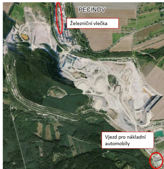
Obr. 37, areál skládky Rynholec s vyznačenými místy pro vjezd dopravních prostředků
